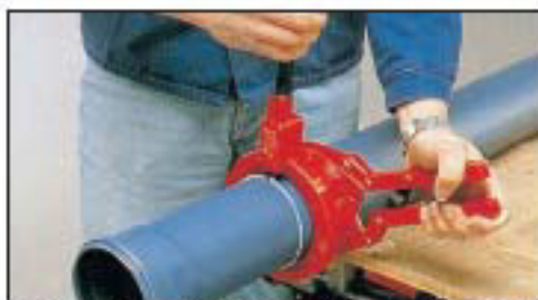
a) Taglio a misura e smussatura con apposita apparecchiatura
