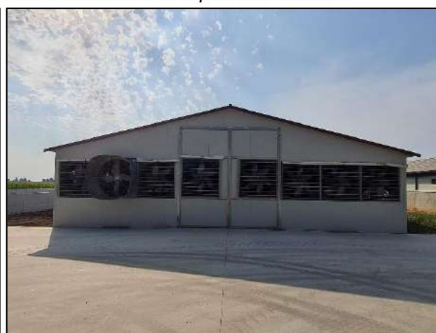
Fotografie del sistema di ventilazione forzata installato nei capannoni avicoli.
