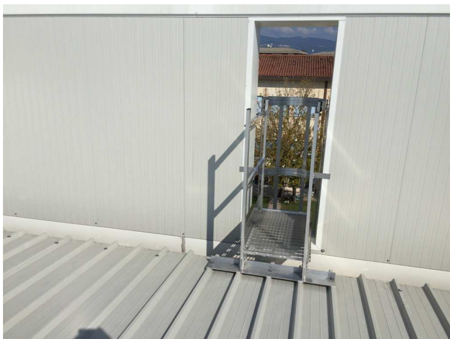
Sbarco della scala di accesso al tetto sulla copertura
