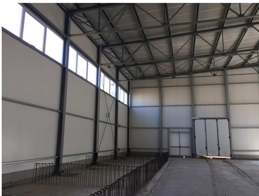
Vista interna, nel dettaglio le armature per l'esecuzione delle future gradinate
