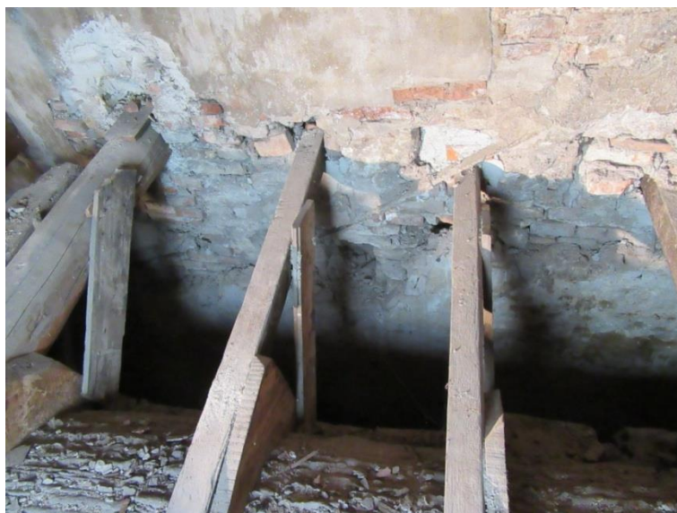
Figura 2.43: sottotetto S.02.a-b: parete lato ovest, confinante con l'altra proprietà – estremità del lato sud. Nella foto 4 è evidente la scarsa qualità della tessitura muraria all'appoggio delle travi lignee di controsoffitto
