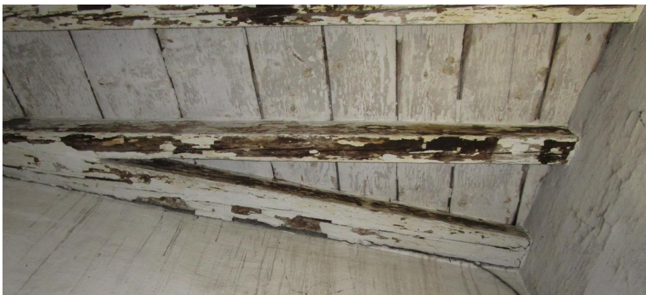
Figura 2.94: foto di dettaglio del degrado delle travi a soffitto del vano A.04.b
