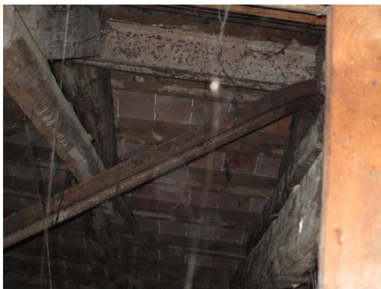
Figura 2.110: copertura S.06: particolare della trave di colmo in acciaio e (sulla sinistra) del travicello in legno chiodato sul fianco delle travi con funzione di contenimento della spinta
