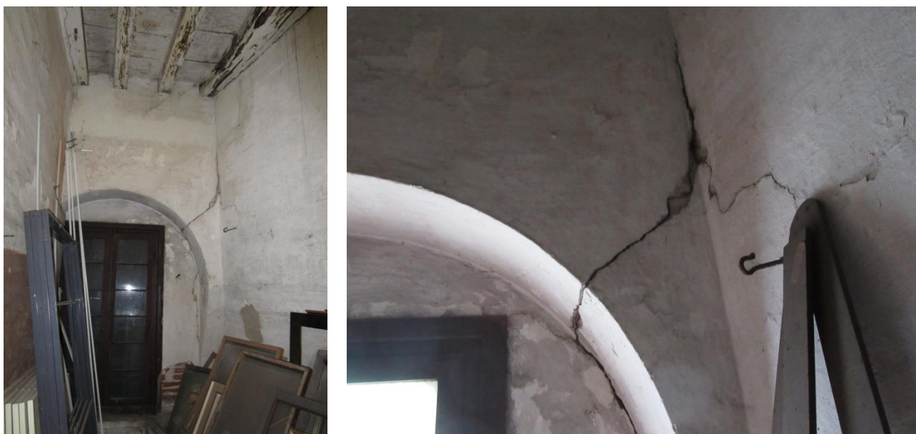
Figura 2.51: piano ammezzato – vano A.04.b: parete di fondo, verso il cavedio, ove è visibile una lesione in corrispondenza dell'imposta dell'arco che racchiude la finestra.
