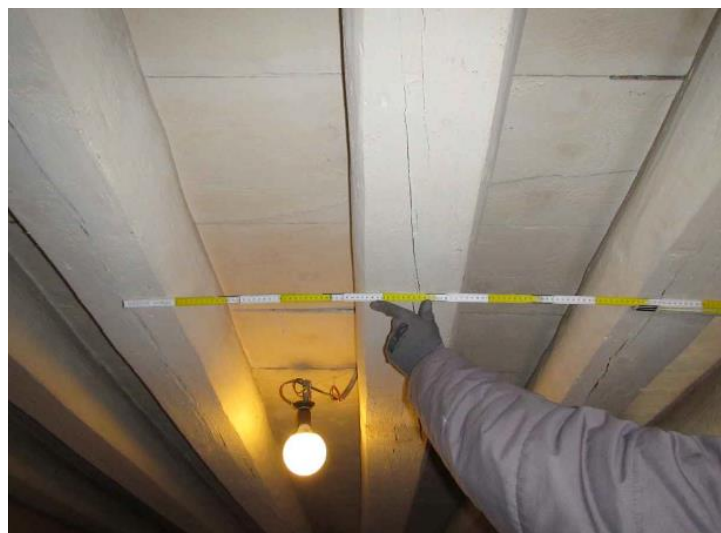
Figura 2.87: solaio a soffitto del vano A.09 (immagine tratta dalla relazione di Expin srl)
