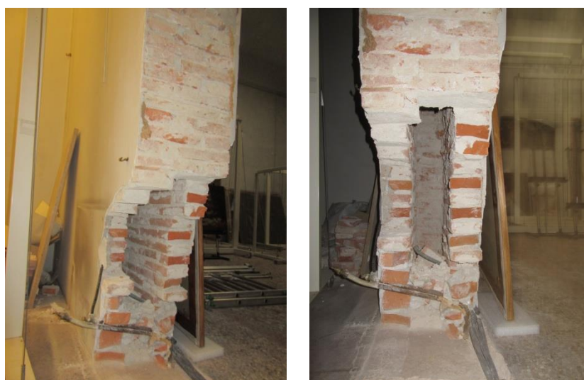
Figura 2.39: vano N.03.b: ricostruzione della muratura per la traslazione verso il cortile delle aperture di collegamento dei vani retrostanti il prospetto monumentale caratterizzato dal loggiato
