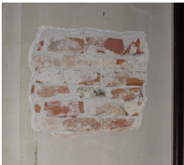
Figura 2.33: esito dei saggio eseguito al piano ammezzato sulla parete lato corso Palladio del vano A.02
