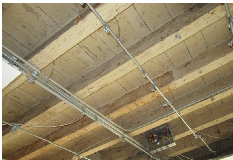
Figura 2.68: intradosso del solaio a soffitto di T.06.a (area predisposta per la classificazione a vista del legno)
