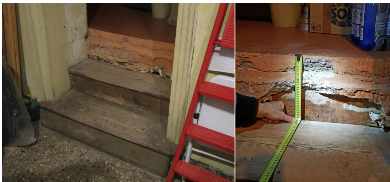
Figura 2.90: pacchetto pavimentazione dell'attuale appartamento del custode
