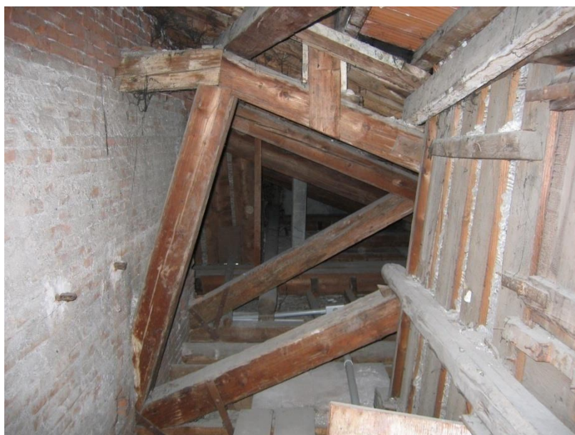
Figura 2.98: copertura S.01.a (foto arch. Alberti): in primo piano è ripresa la semicapriata C2, sul fondo la semicapriata C3, posta tra la copertura S.01.a e la copertura S.01.b
