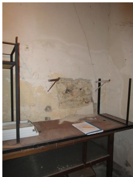
Figura 2.49: piano ammezzato – vano A.06.c: lesioni visibili sull'intonaco della parete ovest ed esito delle scarifiche, che hanno evidenziato una muratura in mattoni mista a pietrame dalla tessitura molto irregolare e rimaneggiata
