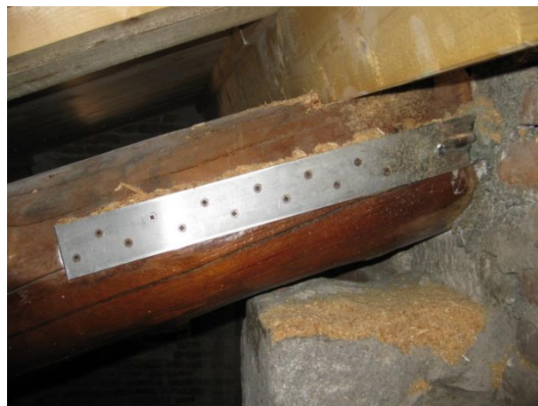
Figura 3.10: esempi di collegamento di strutture lignee alla muratura mediante piatto-barra in acciaio inox (a sx: caso di piastra ancorata alle travi lignee tramite il tavolato; a dx: caso di piastra ancorata direttamente sul fianco di una trave)
