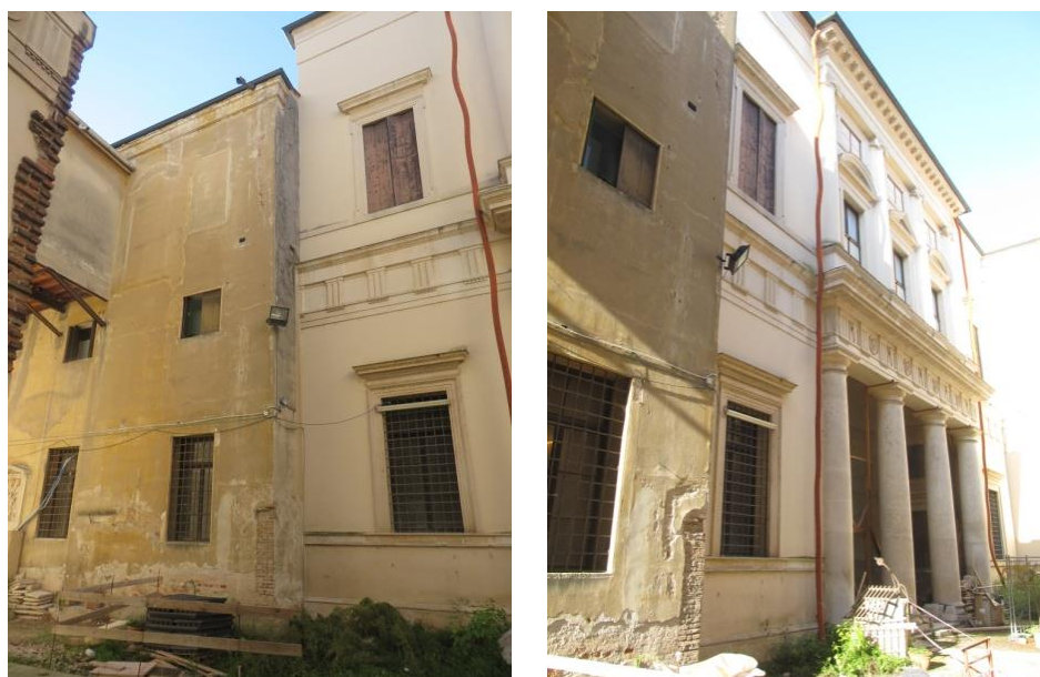
Figura 2.26: prospetto est sul cortile principale, ove risulta ancora più evidente la diversa fase e qualità costruttiva tra la porzione nord e quella sud dell'ala ottocentesca
