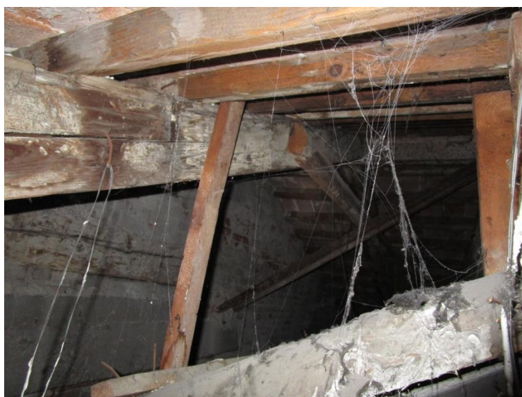
Figura 2.109: copertura S.06: foto scattata dal foro praticato sul controsoffitto. È ben visibile uno stato di diffuso degrado e scarsa manutenzione delle strutture lignee.
