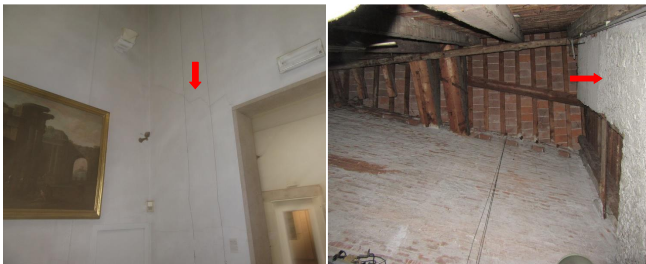
Figura 2.52: piano nobile – vano N.02.a (a sx) e disbrigo lungo il lato nord dello stesso (a dx). La parete, di spessore 30 cm e che presenta delle lesioni, è risultata essere costituita da murali verticali in legno e tavole poste orizzontalmente, a supporto di un rivestimento in arelle, poi intonacate. La parete risulta essere in falso rispetto al muro sottostante.
