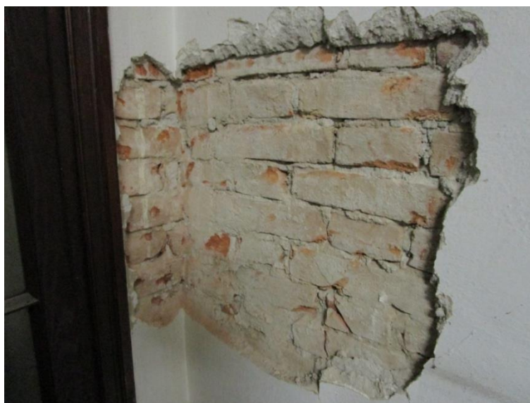
Figura 2.32: esito dei saggio eseguito al piano ammezzato all'angolo nord-est del vano A.06.a
