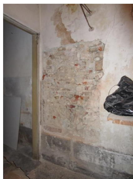
Figura 2.31: esito dei saggi eseguiti al piano ammezzato sulla parete confinante con la proprietà privata: vano A.06.c – lato ovest
