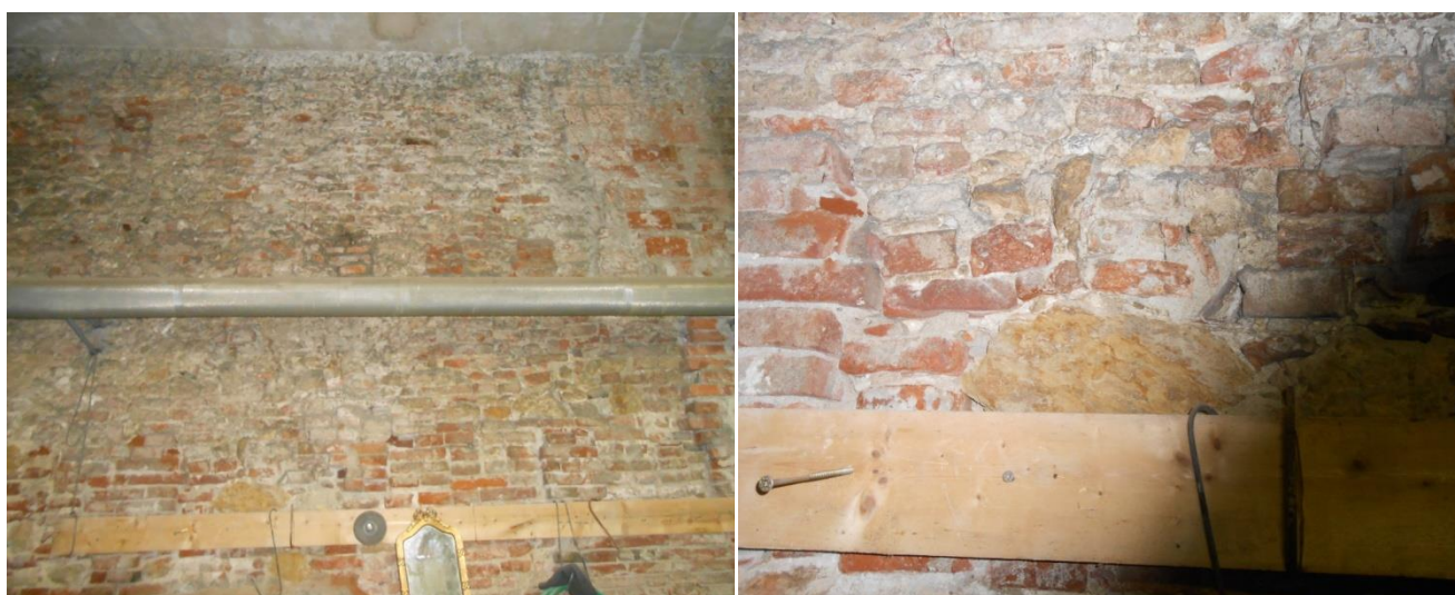
Figura 2.24: vano T.10: parete ovest, confinante con l'altra proprietà, e dettaglio della tessitura muraria visibile nella parte superiore, priva di rifodera
