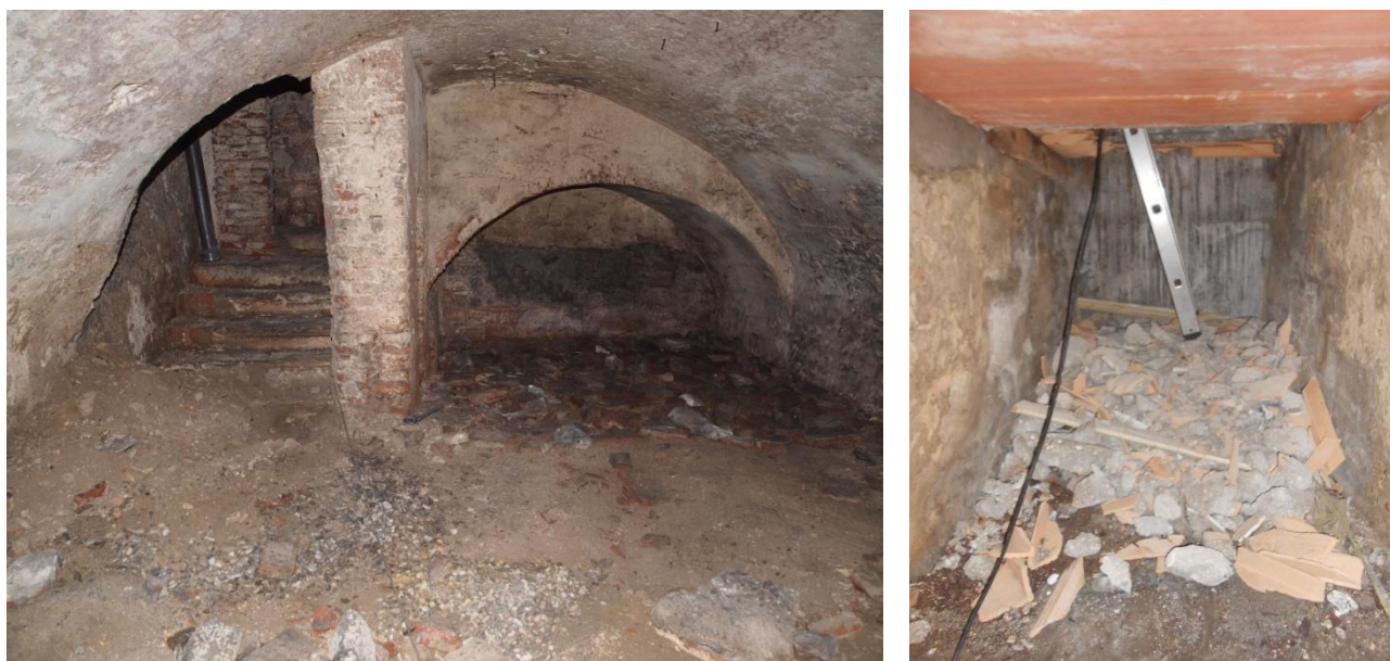
Figura 2.66: immagini dell'ambiente voltato scattate dopo l'apertura della bocca di lupo (foto arch. Alberti) e del solaio posto a sigillare l'accesso al vano scala dal vano T.06.a
