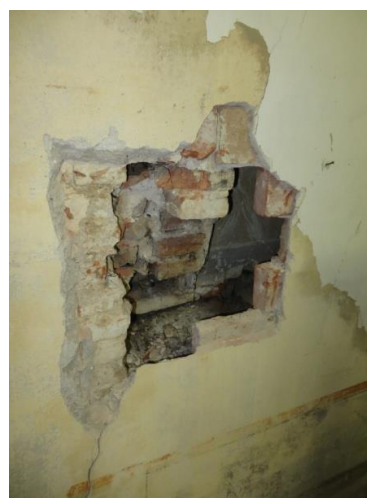
Figura 2.47: piano ammezzato – vano A.06.a: a sinistra lesione rilevata sulla parete ovest, in prossimità della facciata su corso Palladio; a destra dettaglio del saggio che ha consentito di comprendere come la lesione interessasse in realtà una controparete in foglio
