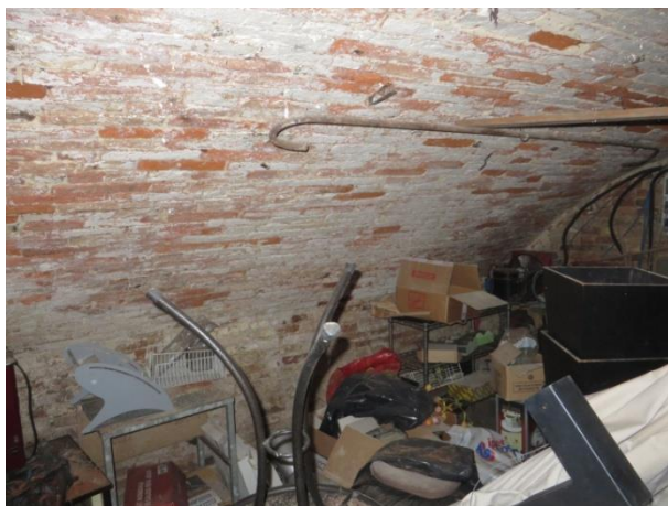
Figura 2.64: estradosso della volta sottostante il pavimento dell'ex bar-caffetteria
