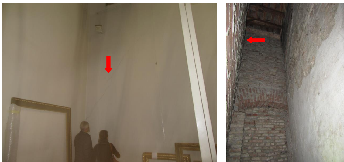
Figura 2.53: piano nobile – vano N.03.b: la lesione visibile sull'intonaco della parete ovest risulta riguardare la controparete in bimattoni (cfr foto a destra)
