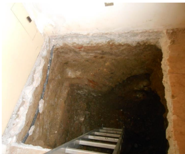
Figura 2.6: saggio in fondazione eseguito all'interno del vano T.09, all'angolo sud-ovest
