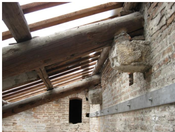
Figura 3.14: esempio di tirantature in acciaio inox realizzate con barre (a sx) o piatto ancorato in modo diffuso alla muratura (a dx)
