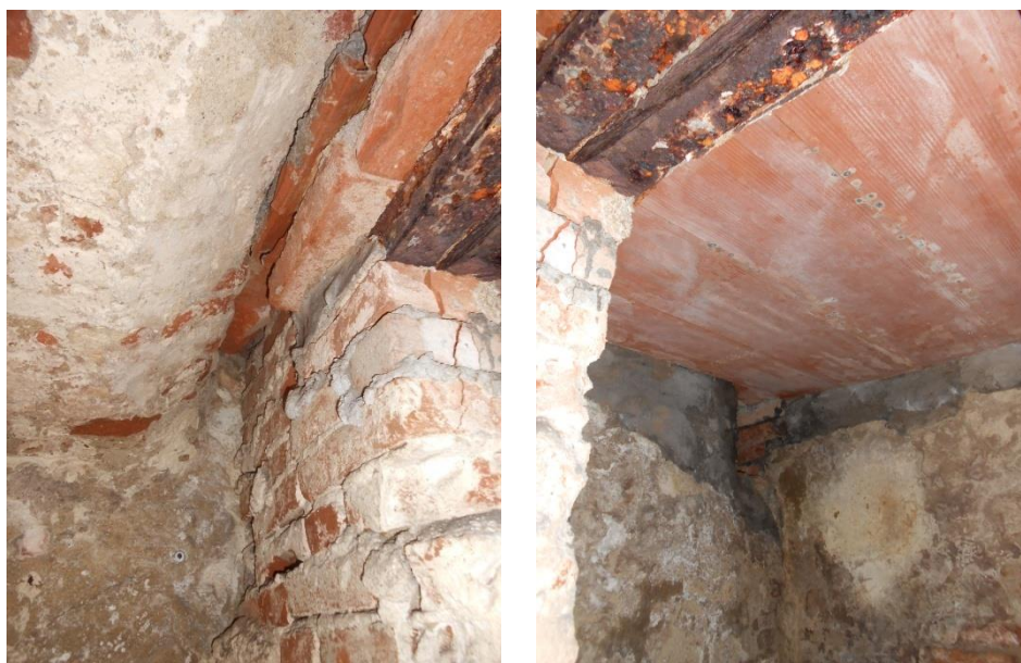
Figura 2.10: dettaglio della spalletta ad una testa che costituisce l'appoggio del solaio posto a chiusura della scala di pertinenza dell'interrato I.02
