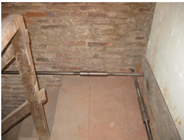
Figura 3.14: esempio di tirantature in acciaio inox realizzate con barre (a sx) o piatto ancorato in modo diffuso alla muratura (a dx)
