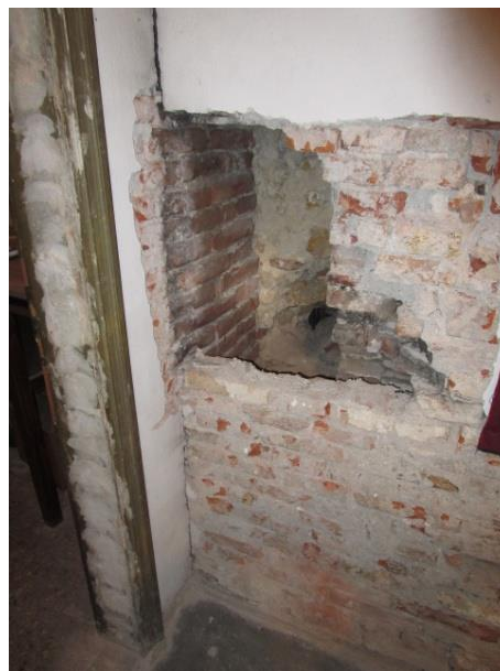
Figura 2.48: piano ammezzato – vano A.06.b: a sinistra lesione rilevata sulla parete ovest, in prossimità della porta comunicante con l'ambiente A.06.c; a destra dettaglio del saggio che ha consentito di comprendere come la lesione interessasse in realtà una controparete ad una testa
