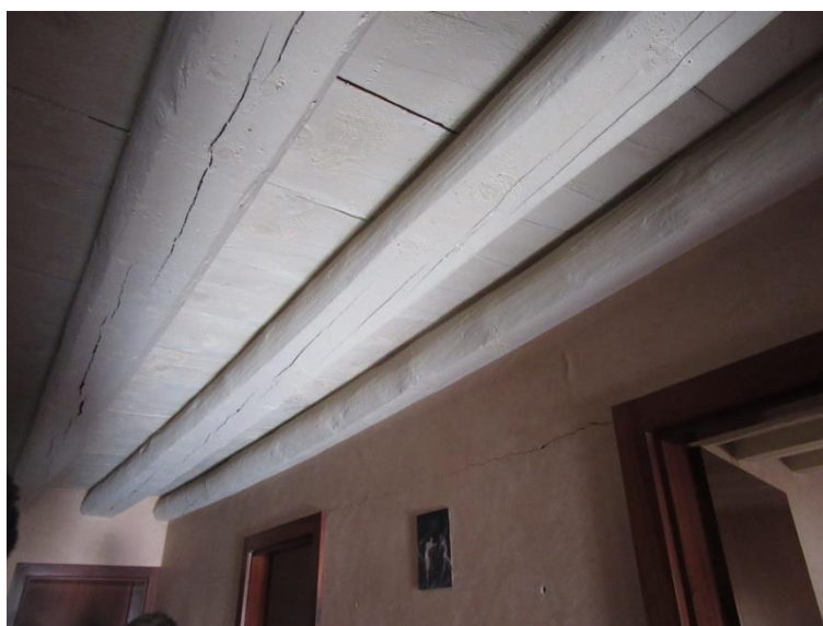
Figura 2.88: solaio a soffitto del vano A.10, interessato da un'evidente inflessione delle travi lignee
