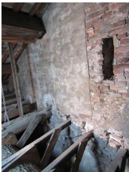
Figura 2.43: sottotetto S.02.a-b: parete lato ovest, confinante con l'altra proprietà – estremità del lato sud. Nella foto 4 è evidente la scarsa qualità della tessitura muraria all'appoggio delle travi lignee di controsoffitto
