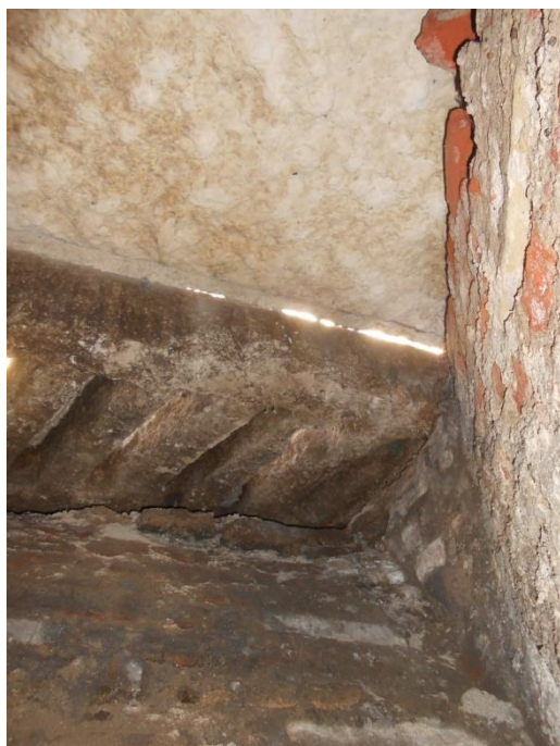
Figura 2.67: vista dell'intradosso delle lastre in pietra che costituisce la soglia della porta di accesso all'ex sanitaria da corso Palladio e foto delle soglie presa da corso Palladio
