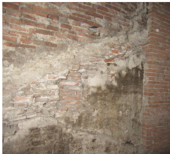
Figura 2.42: sottotetto S.02.a-b: parete lato ovest, confinante con l'altra proprietà: sul lato sud (a sinistra nella foto 1) è visibile il paramento murario vero e proprio, interessato da una sopraelevazione, denunciata dal segno di una precedente linea di falda (cfr foto 2). Il paramento murario sul lato nord (a destra nella foto 1) risulta invece nascosto da una rifoderia in mattoni pieni ad una testa, che dal verso di tessitura dei mattoni risulta poco o per nulla ammorsata con la muratura retrostante
