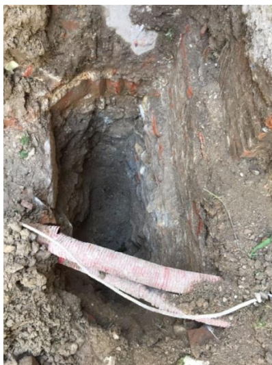
Figura 2.5: saggio in fondazione eseguito sul cortile, in corrispondenza dell'angolo N-E del vano T.09
