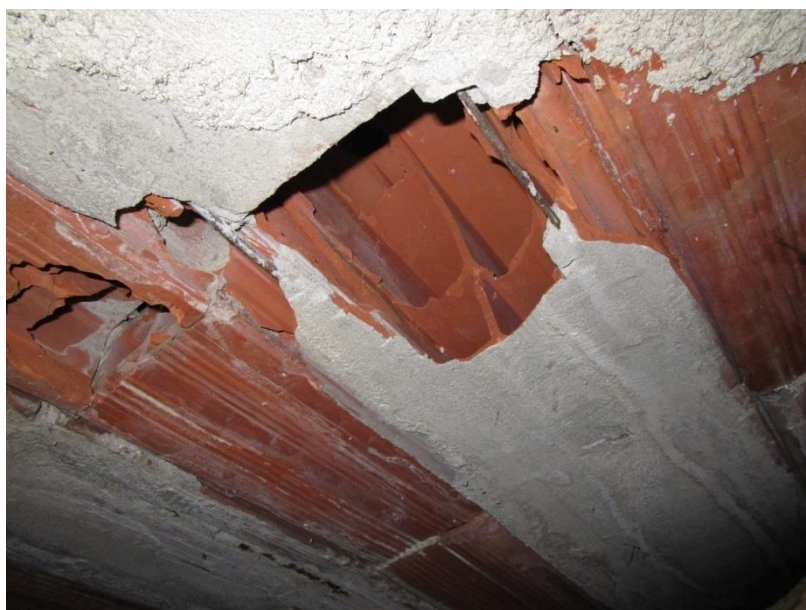
Figura 2.117: copertura S.06: dettaglio delle armature
