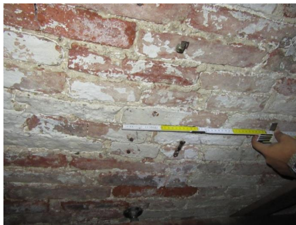
Figura 2.64: estradosso della volta sottostante il pavimento dell'ex bar-caffetteria
