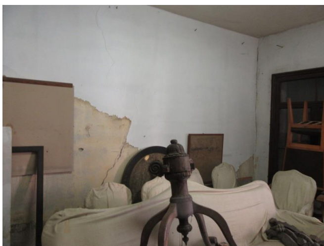
Figura 2.47: piano ammezzato – vano A.06.a: a sinistra lesione rilevata sulla parete ovest, in prossimità della facciata su corso Palladio; a destra dettaglio del saggio che ha consentito di comprendere come la lesione interessasse in realtà una controparete in foglio
