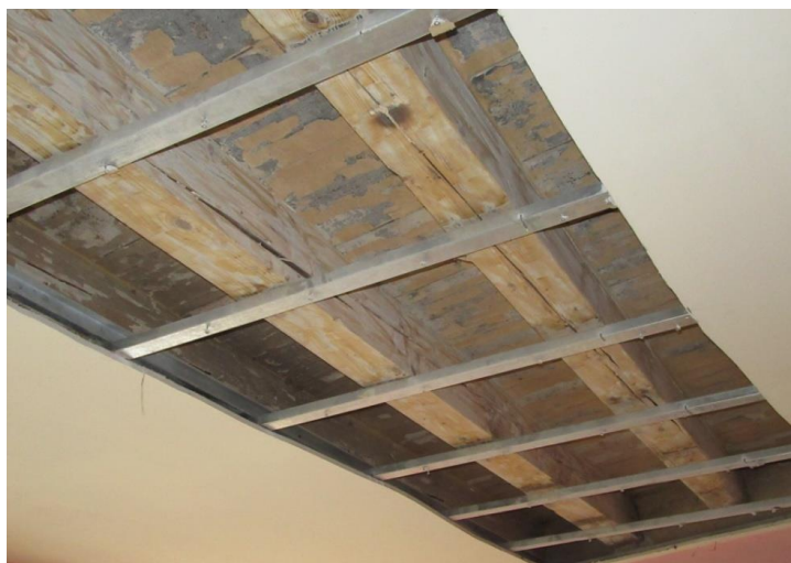
Figura 2.70: intradosso del solaio T.03 (area predisposta per la classificazione a vista del legno) Immagine tratta dalla relazione di Expin srl
