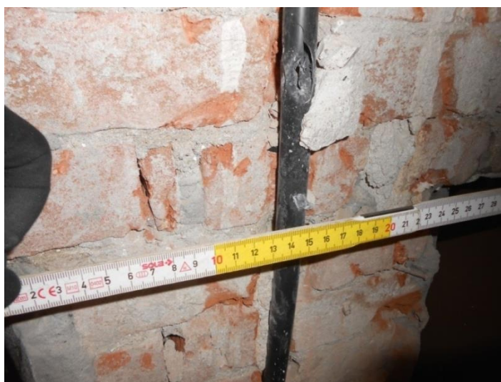
Figura 2.19: pilastrini in muratura all'ingresso dell'ex negozio di sanitaria, in corso Palladio
