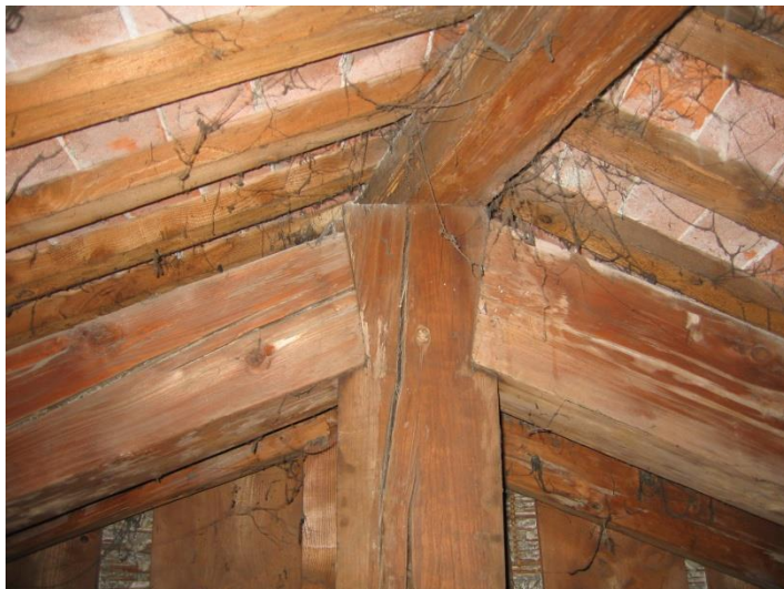
Figura 2.103: copertura S.01.b (foto arch. Alberti): nodo puntoni-monaco (a sx) e puntone-catena (a dx)
