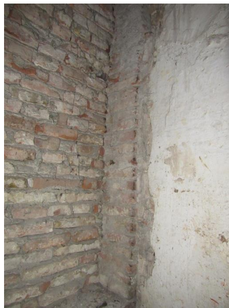
Figura 2.37: vano N.03.b: apertura tamponata in corrispondenza della parete che chiude a sud il cavedio
