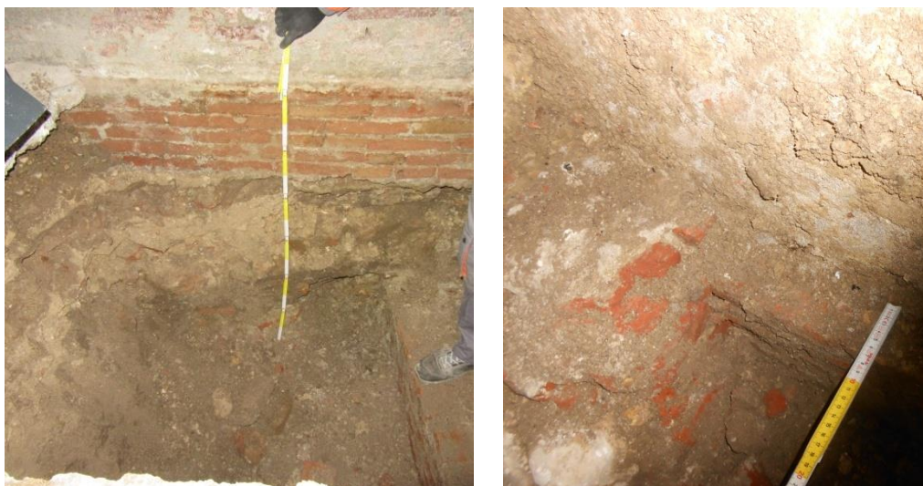
Figura 2.8: saggio in fondazione eseguito all'interno del vano T.10, all'angolo nord-ovest. A sinistra: fondazione della parete ovest confinante con l'altra proprietà. A destra: dettaglio della fondazione della parete nord, che presenta caratteristiche simili a quelle già illustrate per i precedenti saggi sulle fondazioni ottocentesche
