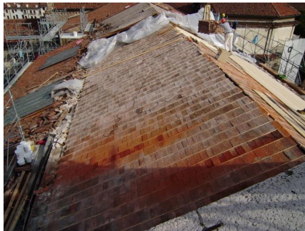
Figura 3.13: a sx: esempio di irrigidimento della falda di copertura mediante posa di listelli sagomati, tabelle e tavolato
