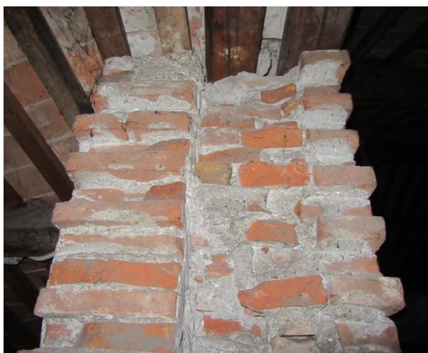
Figura 2.46: sottotetto S.02.a-b: parete lato est: dettaglio della sezione trasversale della parete in corrispondenza dell'apertura comunicante con il sottotetto S.01.b, ove è evidente la rifodera ad una testa, per nulla ammorsata con la parete retrostante, che appare a sua volta scarsamente ammorsata
