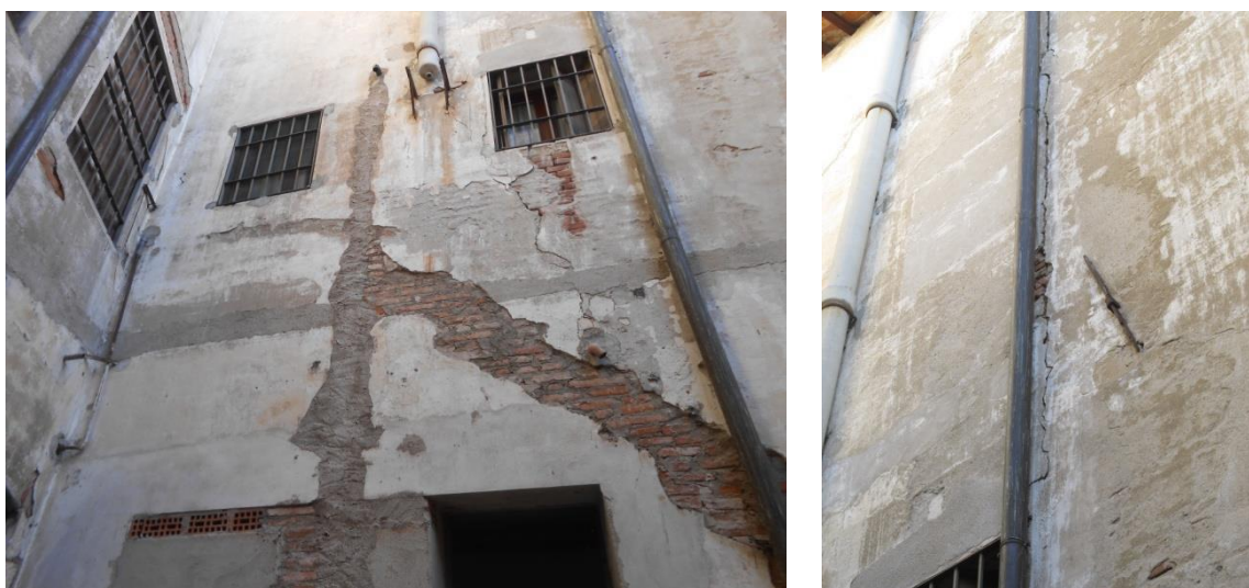
Figura 2.25: prospetto ovest sul cortile interno T.12: a sx traccia di lesioni e di un vecchio intervento di scuci-cuci; a dx segno di discontinuità della tessitura muraria visibile tra il prospetto esterno del vano T.07 e quello del vano T.09.
