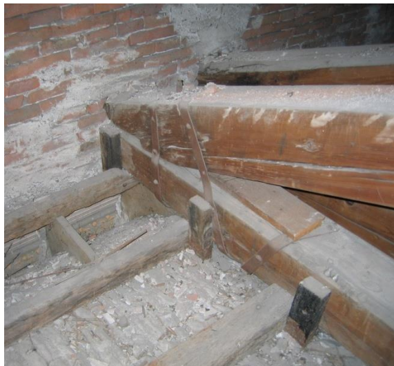
Figura 2.103: copertura S.01.b (foto arch. Alberti): nodo puntoni-monaco (a sx) e puntone-catena (a dx)
