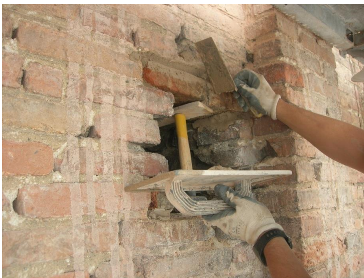
Figura 3.1: a sinistra esempio di intervento di riparazione di lesione mediante risarcitura (1), nuove morse in mattoni (2), legature in acciaio inox di piccolo diametro (3), iniezioni di miscela a base di calce idraulica naturale (4); a destra esempio di intervento di riparazione mediante scuci-cuci
