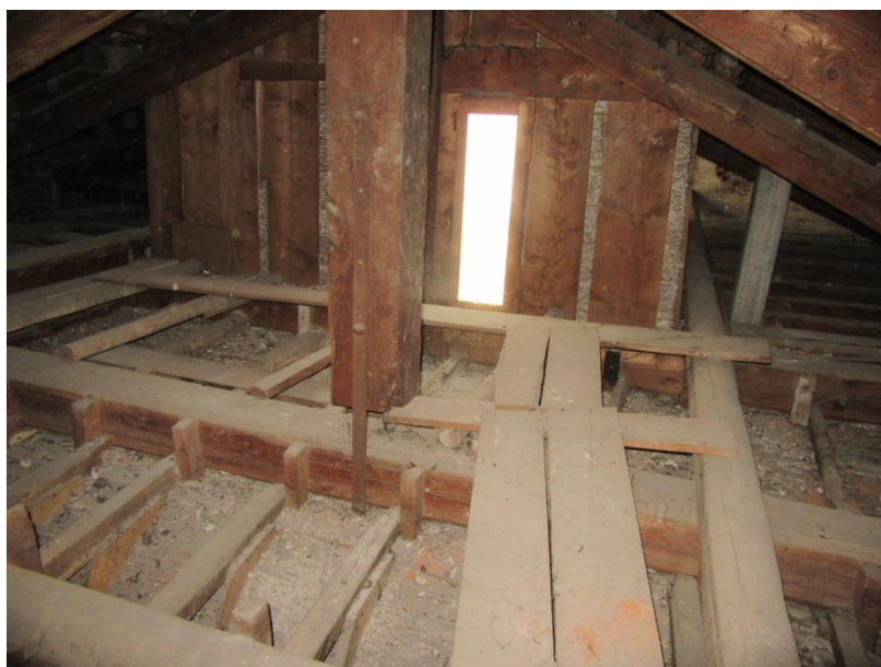
Figura 2.95: particolare dell'estradosso del controsoffitto nel sottotetto S.01.b
