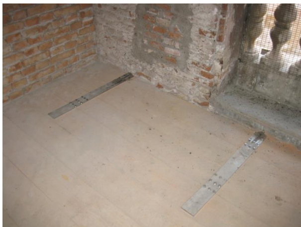
Figura 3.10: esempi di collegamento di strutture lignee alla muratura mediante piatto-barra in acciaio inox (a sx: caso di piastra ancorata alle travi lignee tramite il tavolato; a dx: caso di piastra ancorata direttamente sul fianco di una trave)
