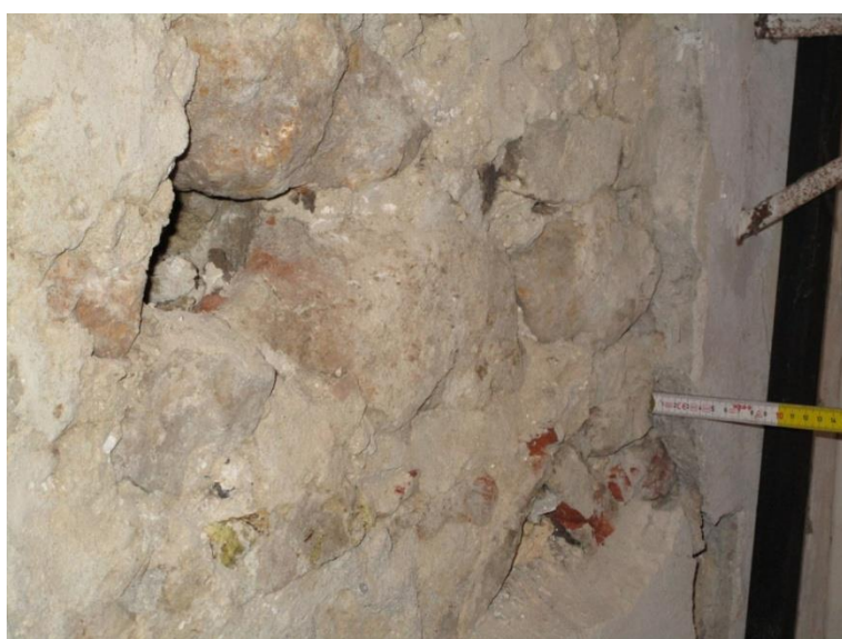
Figura 2.31: esito dei saggi eseguiti al piano ammezzato sulla parete confinante con la proprietà privata: vano A.06.c – lato ovest
