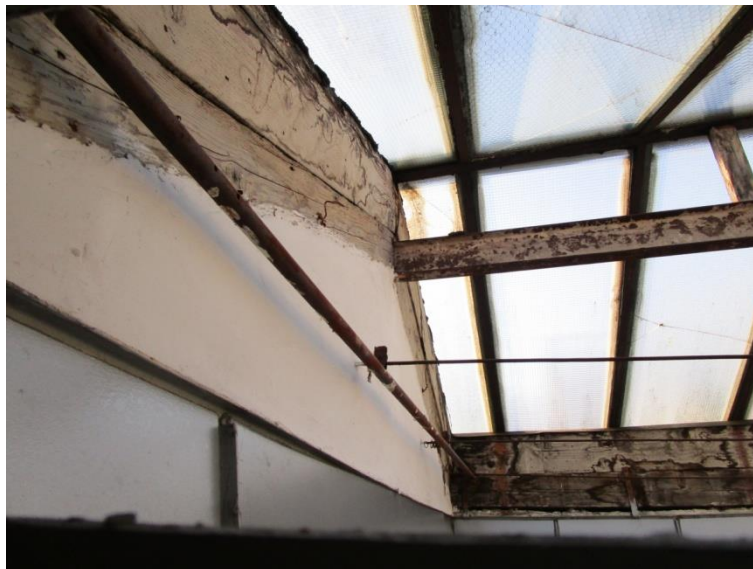
Figura 2.112: copertura S.06: dettaglio della catena visibile in corrispondenza della testata sud del lucernario
