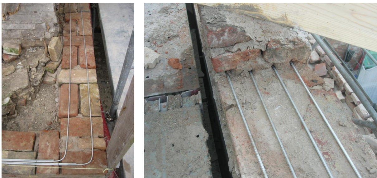
Figura 3.11: esempi di legatura della cresta muraria a livello di copertura con inserimento di barre inox a.m. entro i giunti di malta
