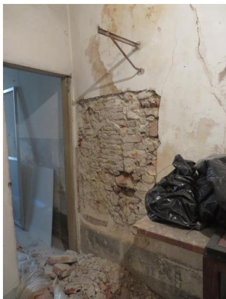
Figura 2.49: piano ammezzato – vano A.06.c: lesioni visibili sull'intonaco della parete ovest ed esito delle scarifiche, che hanno evidenziato una muratura in mattoni mista a pietrame dalla tessitura molto irregolare e rimaneggiata
