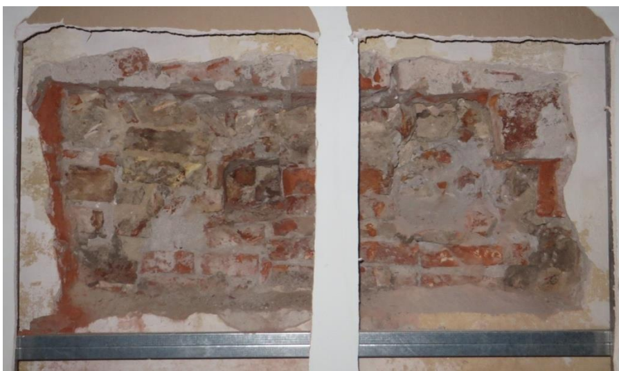
Figura 2.17: scarifica SC7 eseguita all'interno dell'ex negozio di sanatoria
