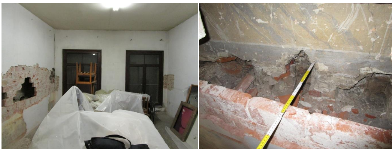
Figura 2.28: vano A.06.a: esito del saggio eseguito al piano ammezzato sulla parete ovest confinante con la proprietà privata (il saggio è quello a sinistra nella prima foto)
