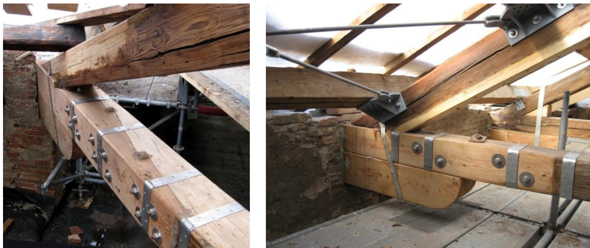
Figura 3.8: esempi di protesi di catena lignea e puntone (sx) e di protesi di catena lignea e rinforzo di puntone con accoppiamento di tavolone (dx)
