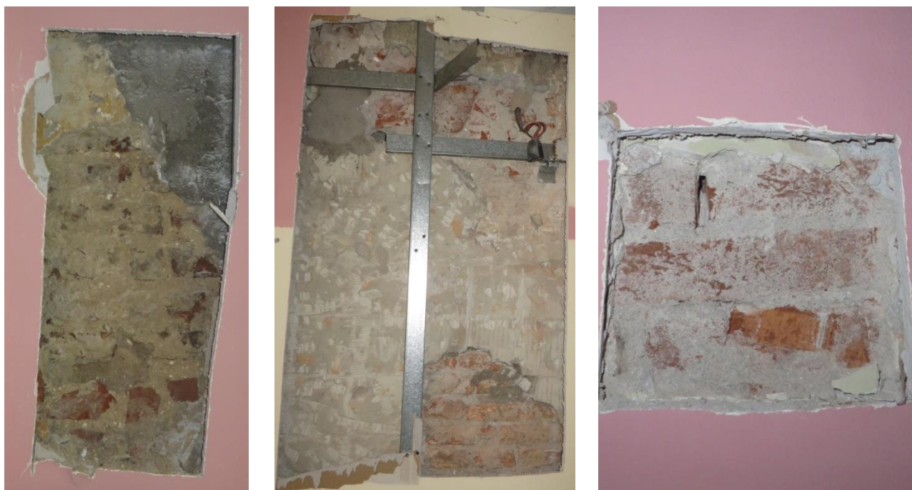
Figura 2.13: scarifiche SC1 (a sinistra), SC2 (al centro) e SC3 (a destra) eseguite all'interno dell'ex bar-caffetteria
