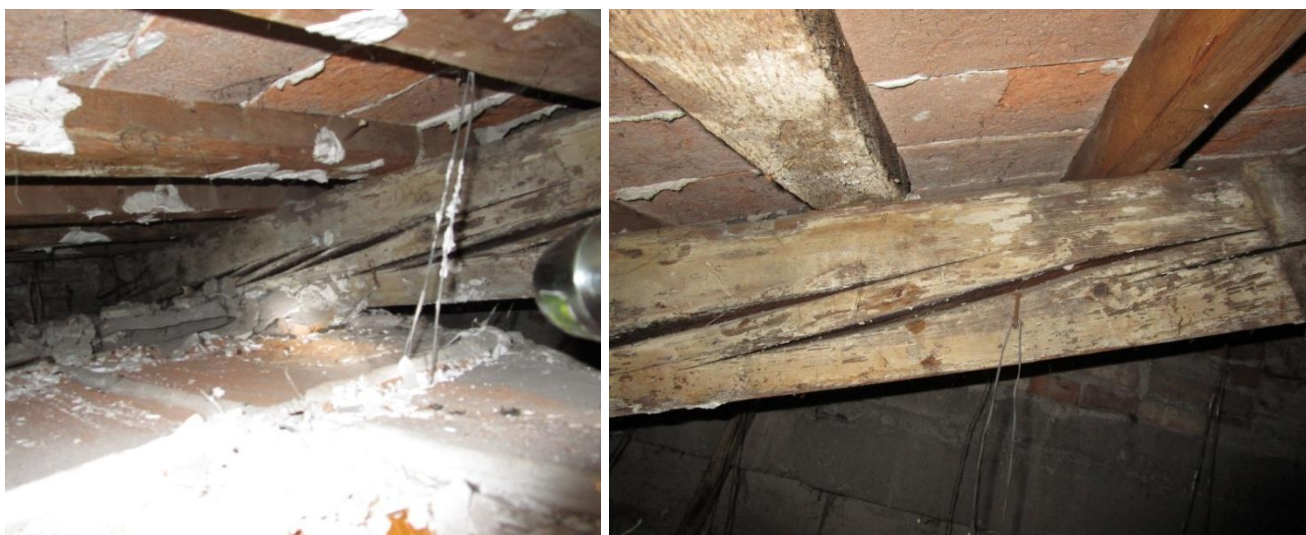
Figura 2.113: copertura S.06: a sx dettaglio della zona di appoggio alla muratura di una trave; a dx segni di degrado delle strutture lignee
