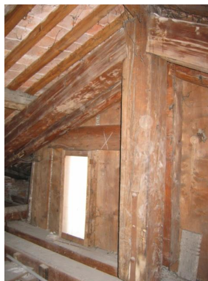
Figura 2.101: copertura S.01.b (foto arch. Alberti): capriate C4/C5 e (sullo sfondo) C6/C7
