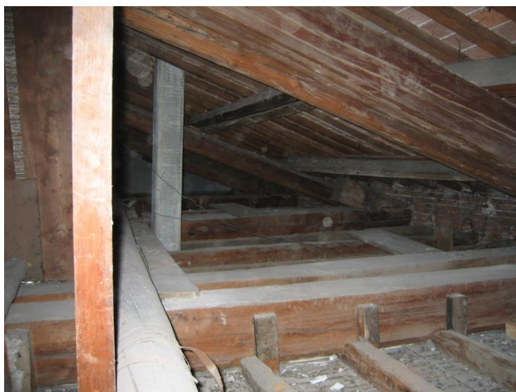
Figura 2.101: copertura S.01.b (foto arch. Alberti): capriate C4/C5 e (sullo sfondo) C6/C7
