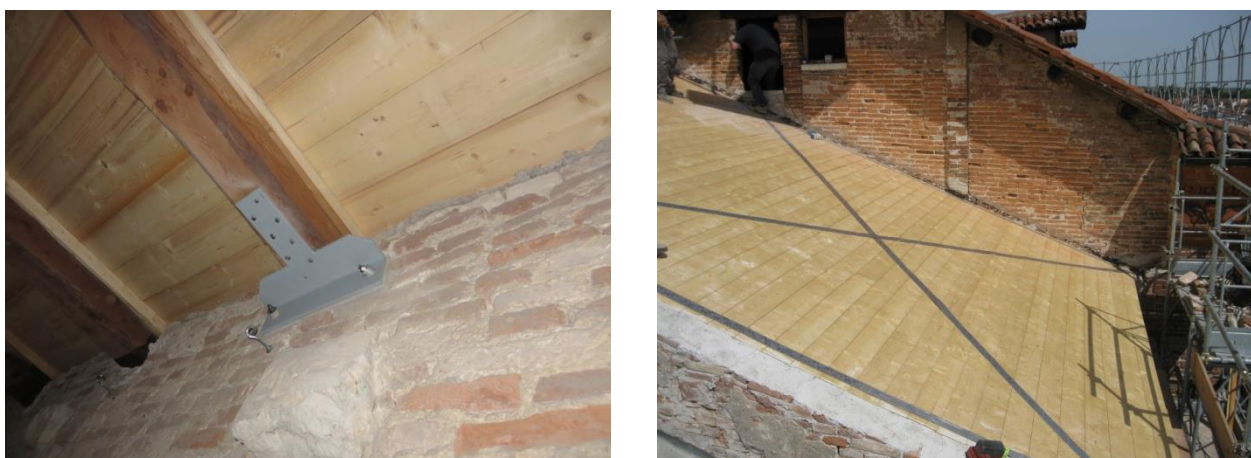
Figura 3.12: a sx: esempio di collegamento delle strutture lignee di copertura con la muratura mediante piastre in acciaio; a dx: esempio di controventamento con nastri forati in acciaio zincato all'estradosso del tavolato
