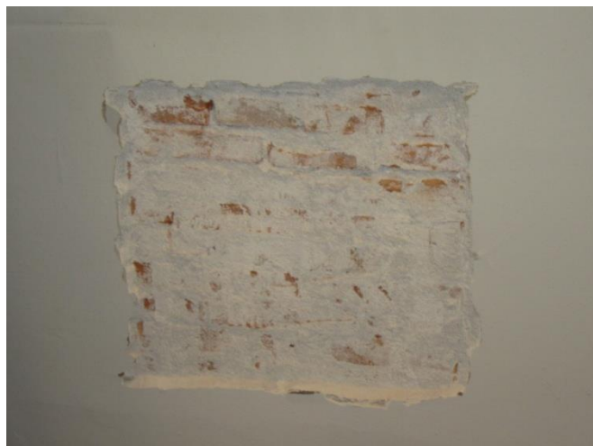
Figura 2.38: vano N.08: scarifica eseguita sulla parete ovest
