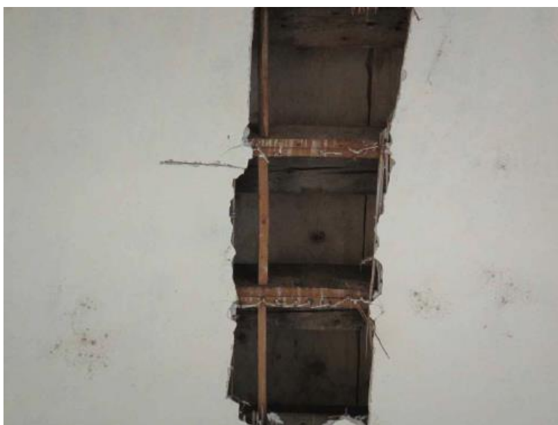
Figura 2.77: intradosso del solaio del piano nobile a soffitto del loggiato a doppia altezza
