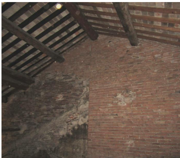
Figura 2.42: sottotetto S.02.a-b: parete lato ovest, confinante con l'altra proprietà: sul lato sud (a sinistra nella foto 1) è visibile il paramento murario vero e proprio, interessato da una sopraelevazione, denunciata dal segno di una precedente linea di falda (cfr foto 2). Il paramento murario sul lato nord (a destra nella foto 1) risulta invece nascosto da una rifoderia in mattoni pieni ad una testa, che dal verso di tessitura dei mattoni risulta poco o per nulla ammorsata con la muratura retrostante
