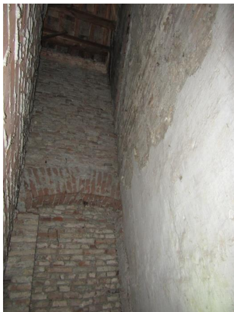
Figura 2.37: vano N.03.b: apertura tamponata in corrispondenza della parete che chiude a sud il cavedio
