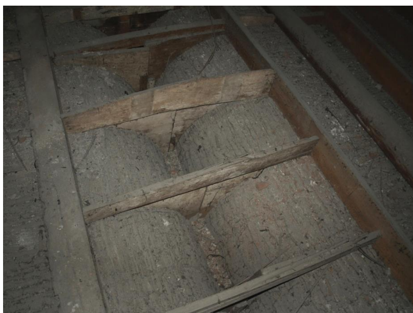
Figura 2.96: particolare dell'estradosso del controsoffitto nel sottotetto S.02.a (foto arch. Alberti)
