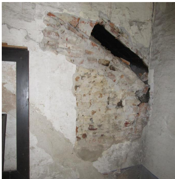
Figura 2.34: esito dei saggio eseguito in corrispondenza dello spigolo nord-ovest del vano A.04.b
