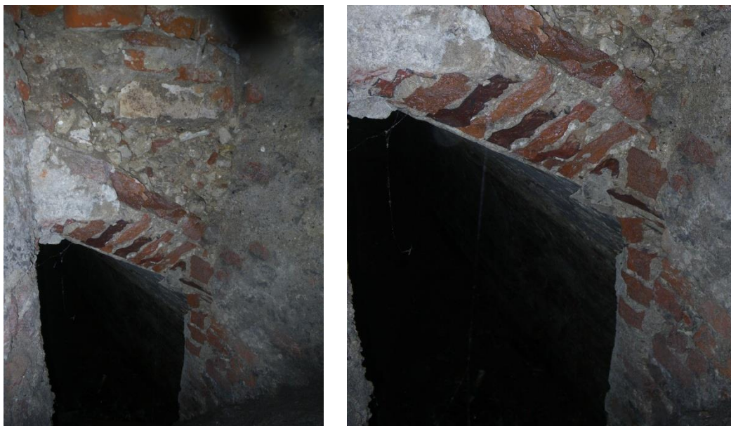
Figura 2.65: immagini di quanto è stato possibile fotografare della volta sottostante il pavimento dell'ex negozio di sanitaria tramite la bocca di lupo esistente lungo corso Palladio
