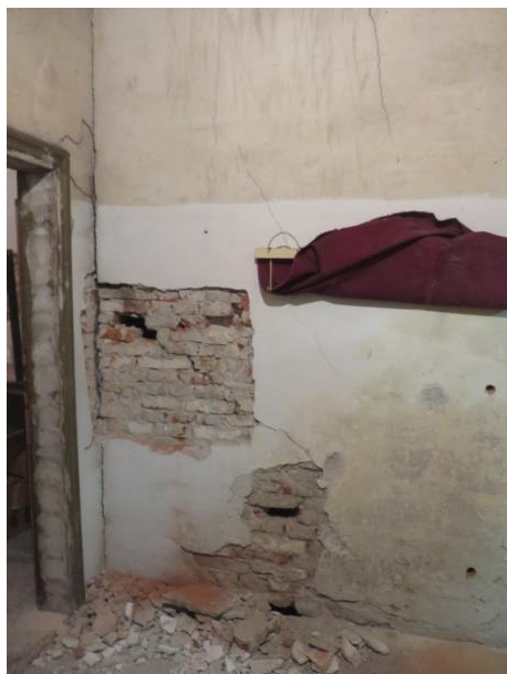
Figura 2.48: piano ammezzato – vano A.06.b: a sinistra lesione rilevata sulla parete ovest, in prossimità della porta comunicante con l'ambiente A.06.c; a destra dettaglio del saggio che ha consentito di comprendere come la lesione interessasse in realtà una controparete ad una testa
