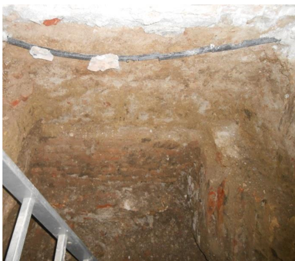
Figura 2.6: saggio in fondazione eseguito all'interno del vano T.09, all'angolo sud-ovest
