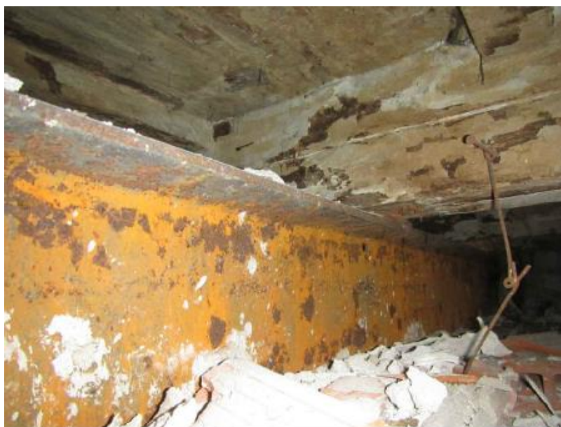
Figura 2.73: intradosso del solaio T.01, con particolare delle travi in legno disposte in direzione nord-sud e di una delle travi rompitratta IPN200 disposte in direzione est-ovest (immagine tratta dalle relazioni di Expin srl)
