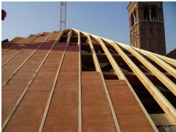
Figura 3.13: a sx: esempio di irrigidimento della falda di copertura mediante posa di listelli sagomati, tabelle e tavolato
