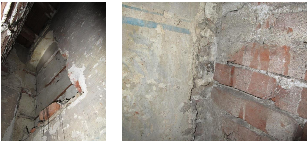
Figura 2.29: vano A.06.a: esito del saggio eseguito al piano ammezzato sulla parete ovest confinante con la proprietà privata. A destra dettaglio dell'angolo tra facciata e parete ovest (non ammortato)
