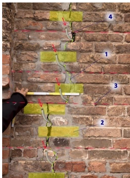
Figura 3.1: a sinistra esempio di intervento di riparazione di lesione mediante risarcitura (1), nuove morse in mattoni (2), legature in acciaio inox di piccolo diametro (3), iniezioni di miscela a base di calce idraulica naturale (4); a destra esempio di intervento di riparazione mediante scuci-cuci
