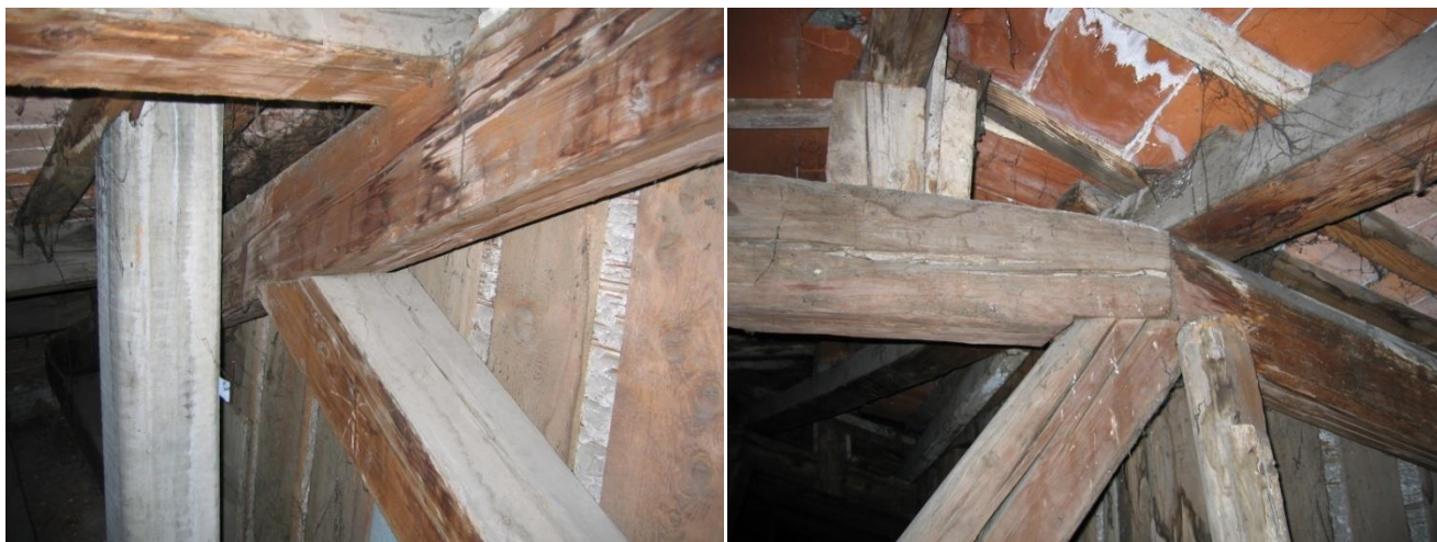
Figura 2.99: copertura S.01.a (foto arch. Alberti): dettaglio di due nodi (a sx saetta-puntone; a dx saetta-puntone-trave di colmo)
