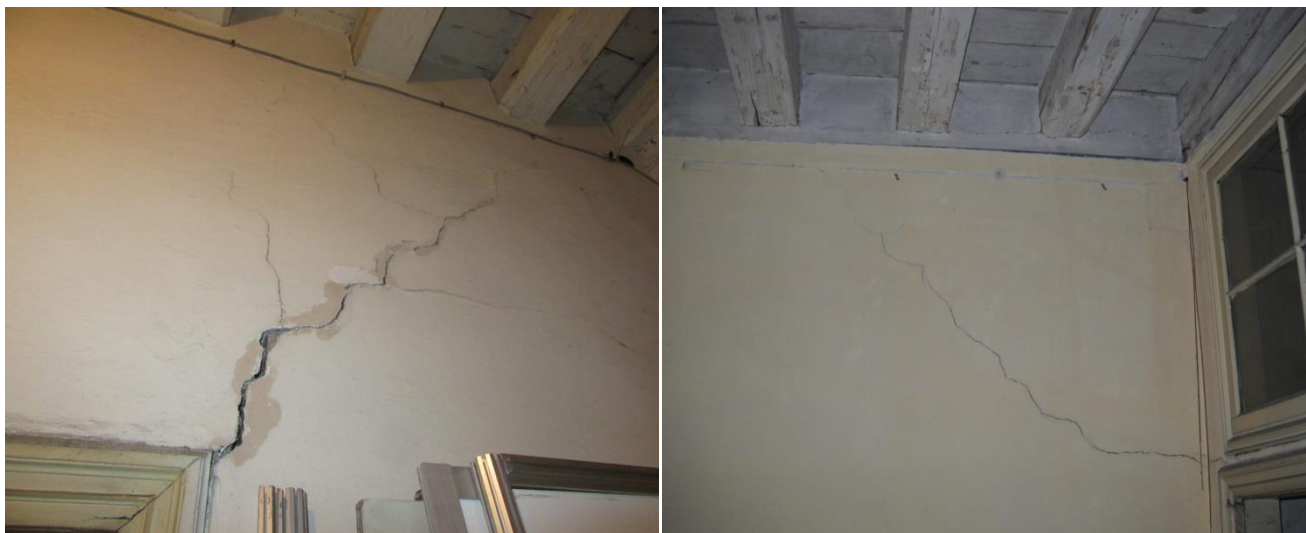
Figura 2.50: piano ammezzato: a sinistra vano A.06.c: lesione visibile in corrispondenza della parete non strutturale di separazione dal vano A.06.f; a destra vano A.06.e: lesione visibile in corrispondenza della parete non strutturale di separazione dal vano A.06.d
