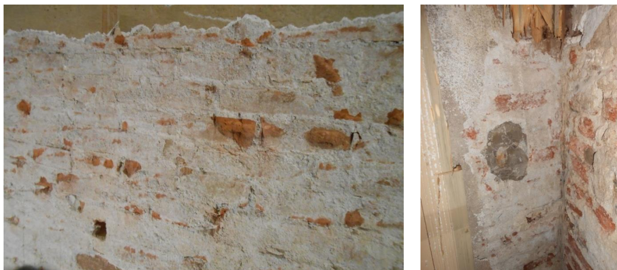
Figura 2.22: vano T.01: a sx scarifica eseguita in corrispondenza della parete di fondo; a dx scarifica eseguita in corrispondenza dell'angolo tra la facciata su corso Palladio e la parete dell'ala cinquecentesca
