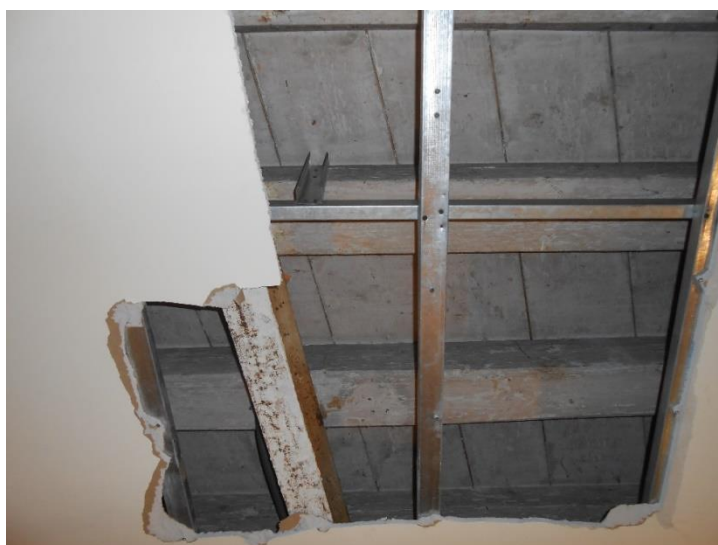
Figura 2.71: intradosso del solaio T.02, con particolare delle travi in legno disposte in direzione est-ovest e di una delle travi rompitratta IPN200 disposte in direzione nord-sud. Immagine tratta dalla relazione di Expin srl
