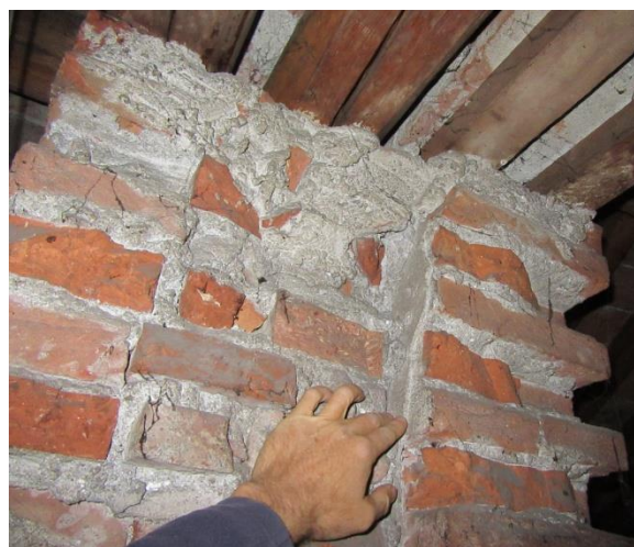
Figura 2.46: sottotetto S.02.a-b: parete lato est: dettaglio della sezione trasversale della parete in corrispondenza dell'apertura comunicante con il sottotetto S.01.b, ove è evidente la rifodera ad una testa, per nulla ammorsata con la parete retrostante, che appare a sua volta scarsamente ammorsata
