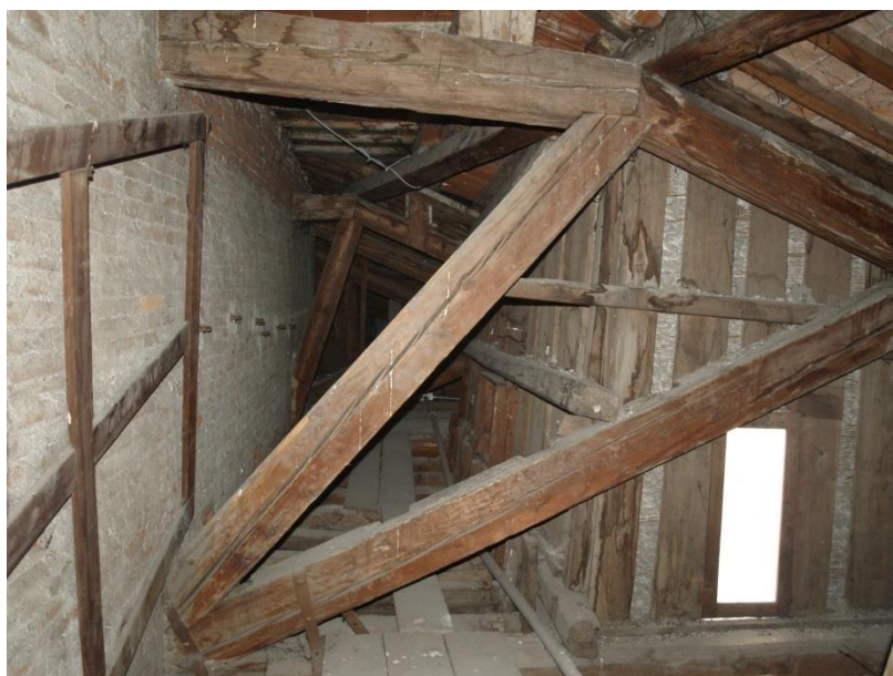
Figura 2.97: copertura S.01.a (foto arch. Alberti): in primo piano è ripresa la semicapriata C1, sul fondo la semicapriata C2
