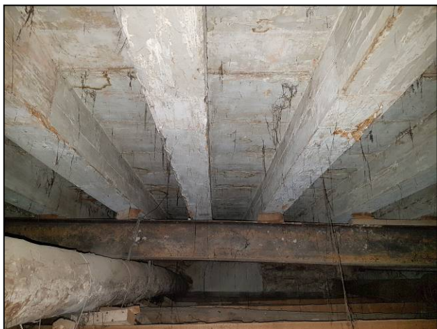
Solaio in legno con trave tipo IPN (1). Si osserva l'assenza di alcuni elementi interposti per l'appoggio della trave in legno sulla trave in acciaio.
