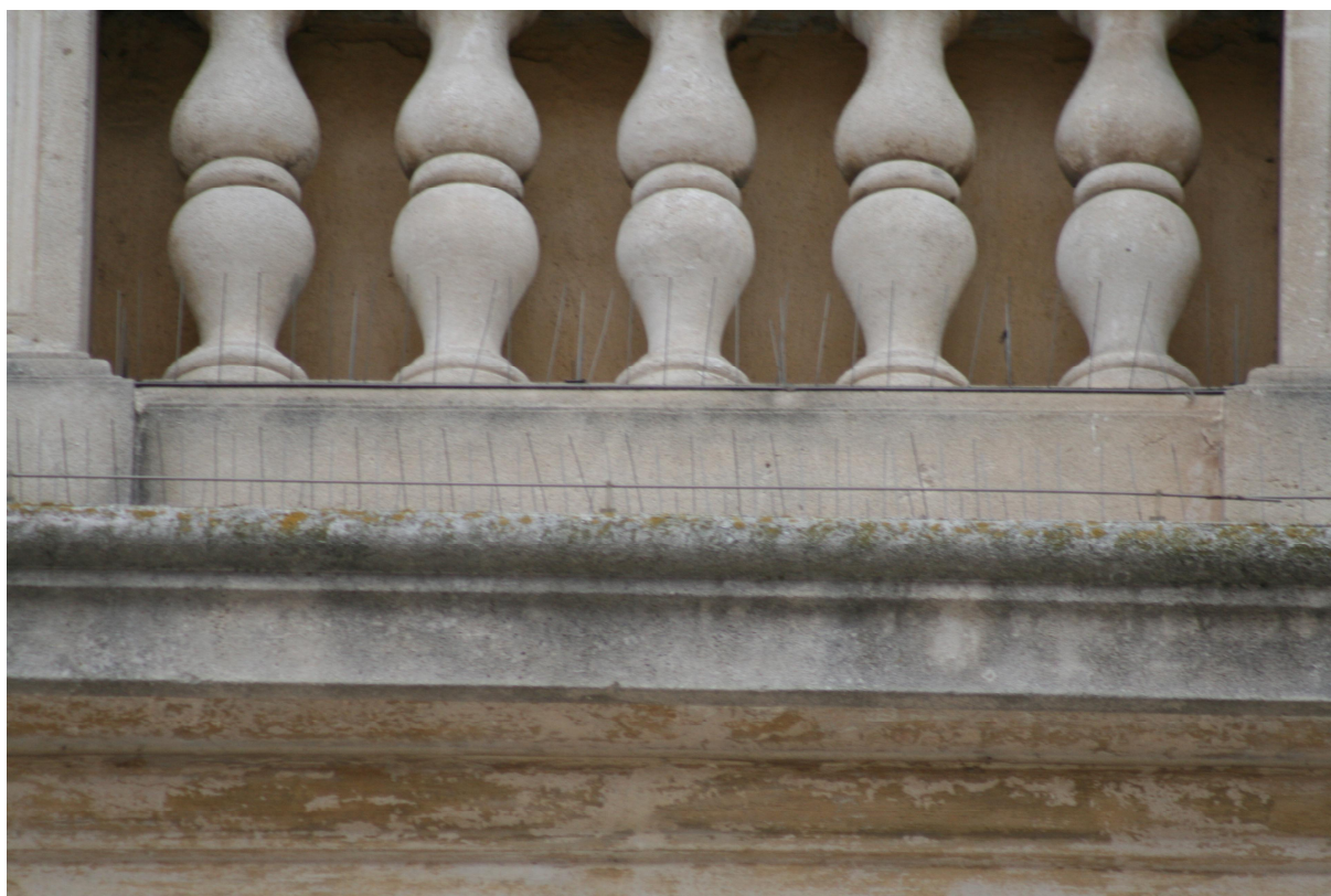
Dettaglio del terrazzino dell'edificio a sinistra; evidente la patina biologica che insiste sulle aree maggiormente esposte alle acque meteoriche.
