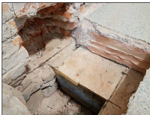
Appoggi delle travi sulla muratura con piatti metallici inchiodati trasversalmente inseriti nella tessitura muraria
