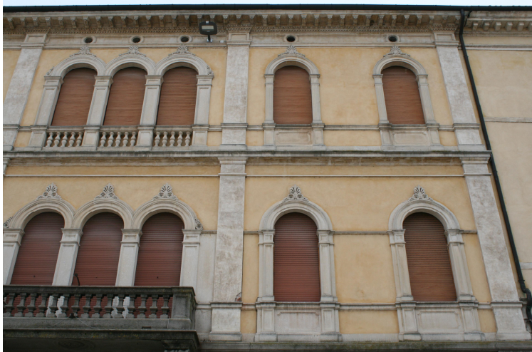
Intonaco dell'edificio di destra giallo negli sfondati, trattato a imitazione della pietra nelle lesene
