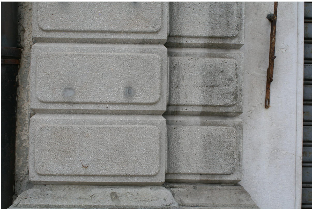
Pilaastro bugnato; evidenti le stuccature, le macchie superficiali, le lacune.
