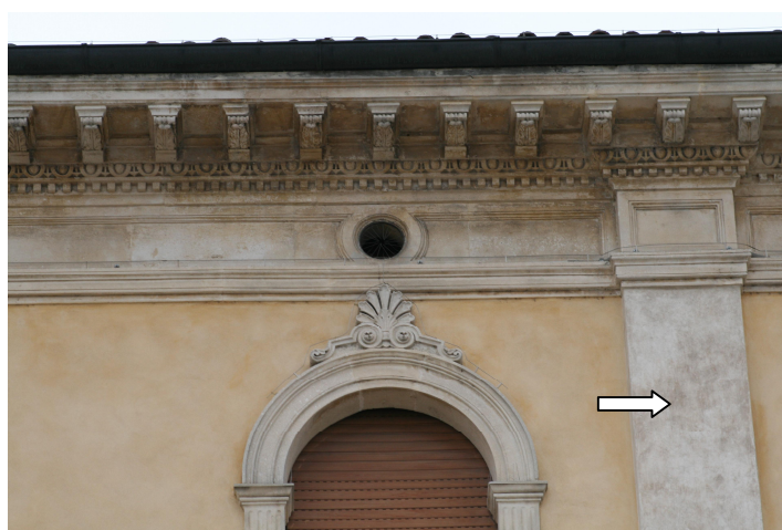
Dettaglio del trattamento superficiale della lesena in intonaco.
