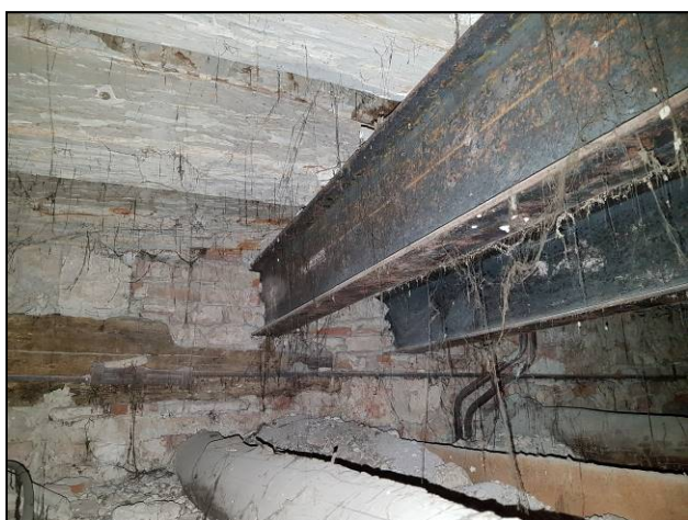
Appoggio delle travi tipo IPN (2) e (3)
