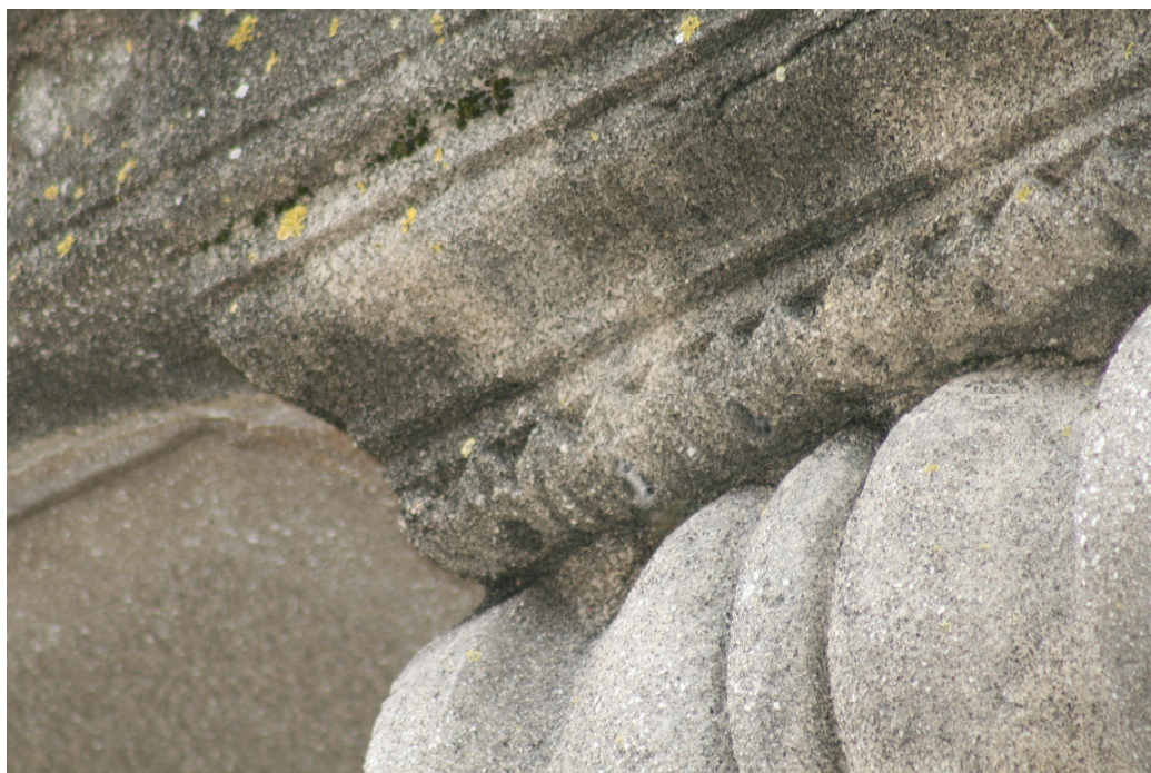
Dettagli della pietra artificiale; è visibile la composizione dell'impasto e l'accumulo di depositi nelle aree non dilavate dalle acque meteoriche.
