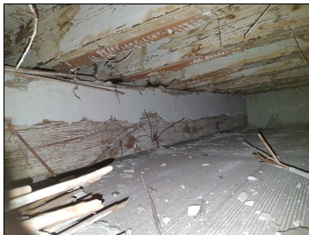
Solaio I e trave in legno a sostegno del controsoffitto con tavelloni in laterizio
