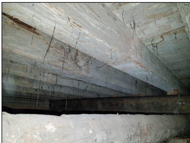
Solaio in legno con trave tipo IPN (1). Si osserva l'assenza di alcuni elementi interposti per l'appoggio della trave in legno sulla trave in acciaio.
