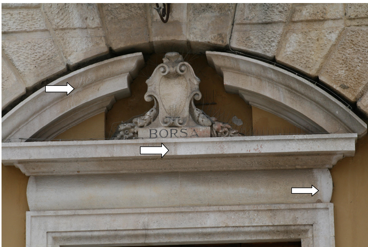
Le frecce indicano in dettaglio le colature che hanno intaccato la patina di deposito
