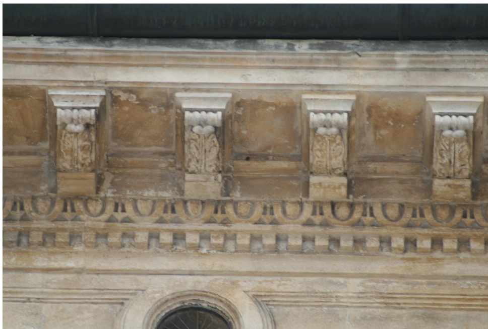
Sottogronda in pietra di Vicenza; dettaglio del modellato e delle patine di ossalati.
