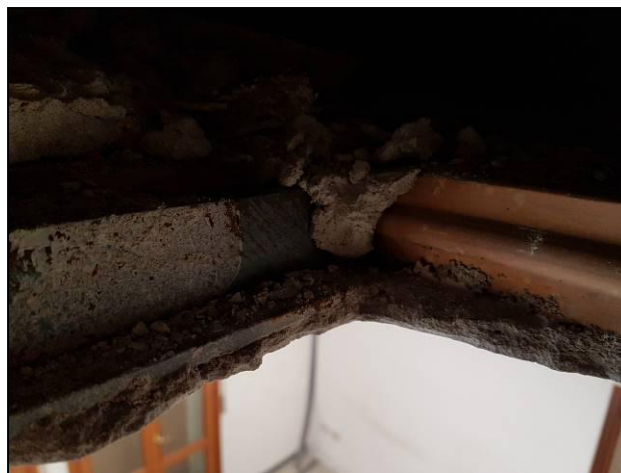
Appoggio del tavellone sul profilo a T rovescio in acciaio
