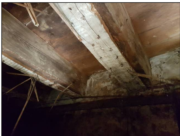
Saggio 9 - Appoggio delle travi
