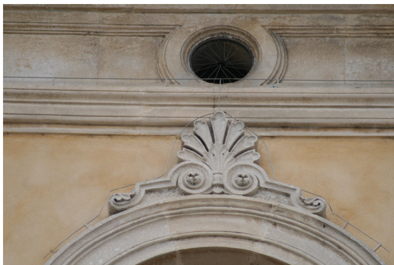
Dettaglio del sistema di dissuasione dei volatili
