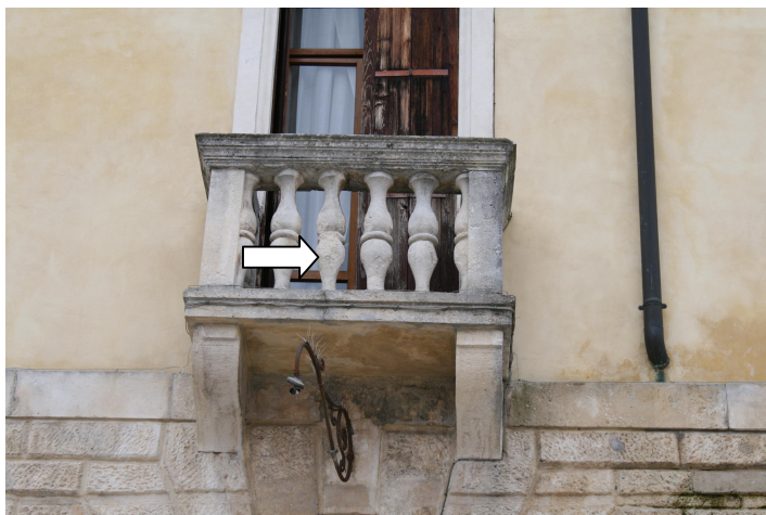
Dettaglio terrazzino prospetto sud; erosione di una balaustra, cavata da una vene più tenera.
