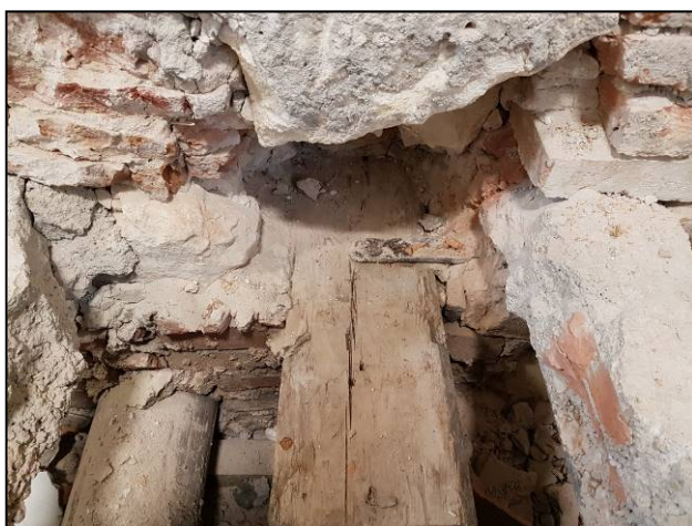
Appoggi delle travi sulla muratura con piatti metallici inchiodati trasversalmente inseriti nella tessitura muraria
