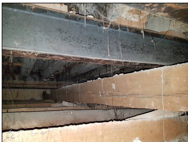
Solaio in legno con trave tipo IPN (3)
