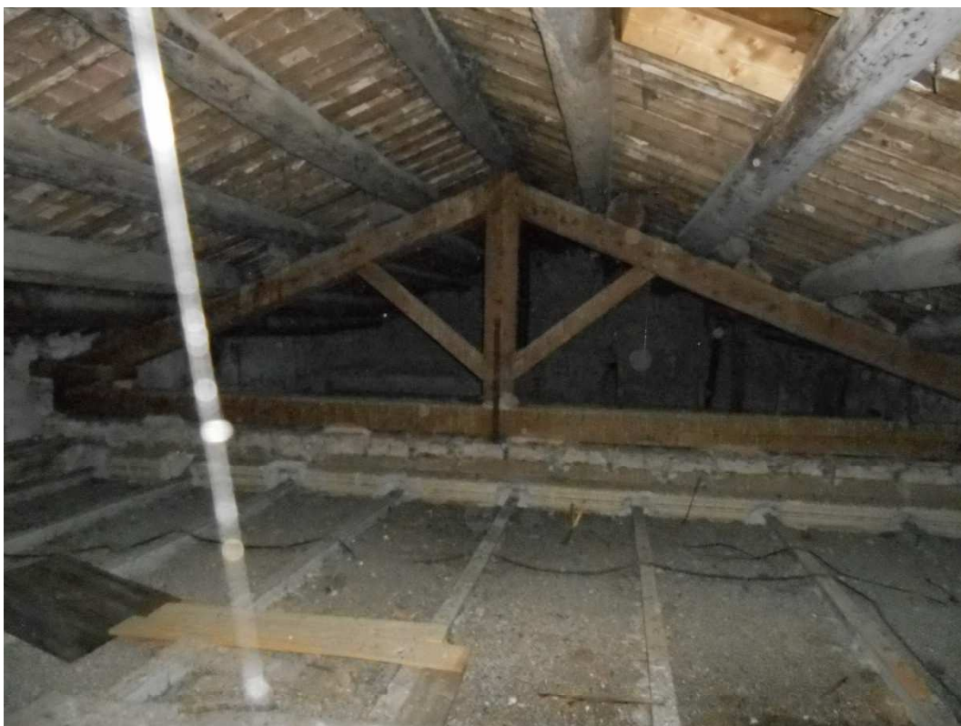
Foto 7 Particolare capriate in legno tetto parte alta
