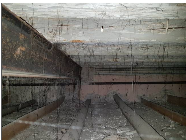
Solaio in legno con trave tipo IPN (2)
