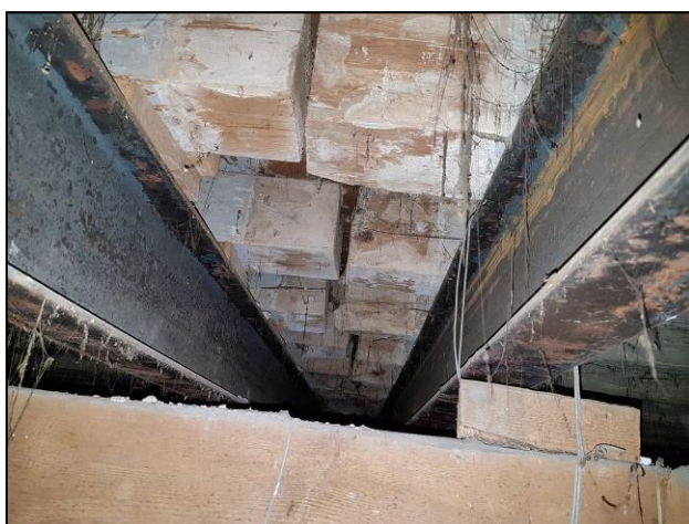
Interruzione delle travi in legno tra le travi tipo IPN (2) e (3)
