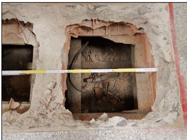
Controsoffitto C1 del solaio A
