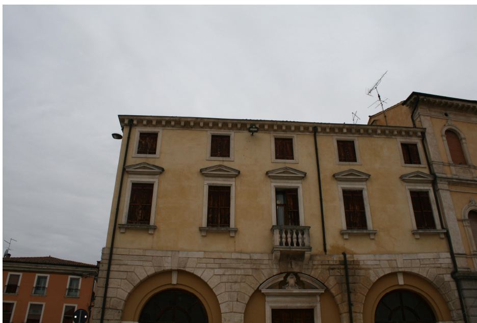
Intonaco dell' edificio a sinistra, nei sottoarchi l'intonaco è stato ridipinto in interventi manutentivi.
