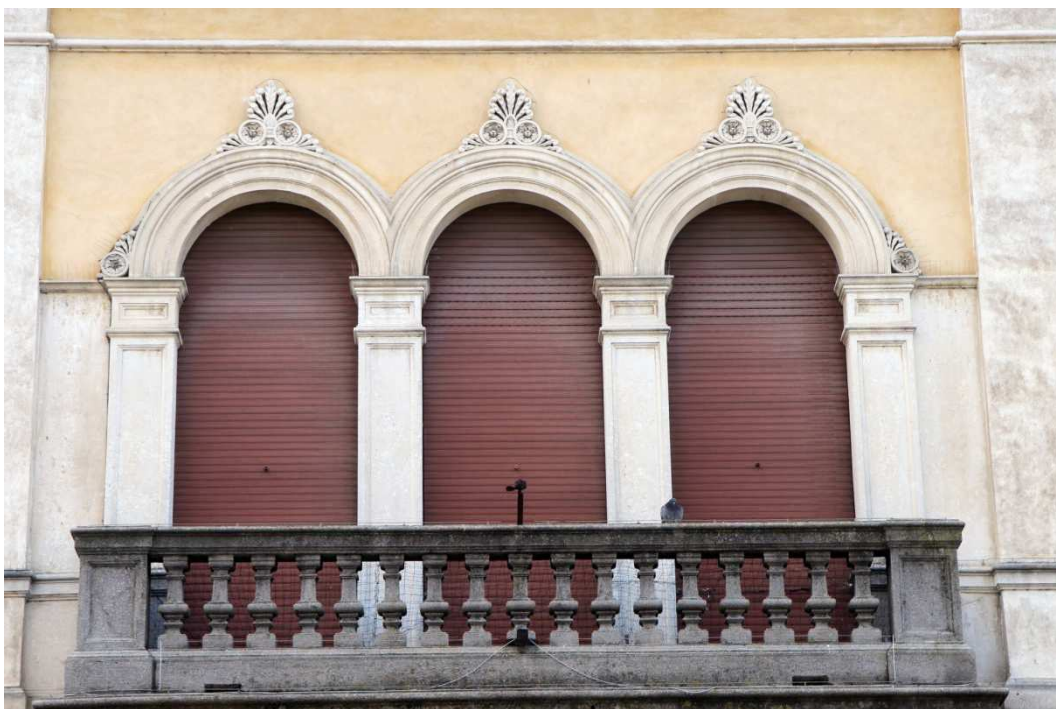
Foto 5 Particolare balcone con balastra in conglomerato cementizio
