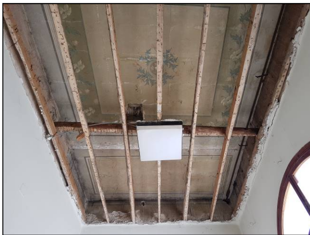
Vista intradosso del solaio D
