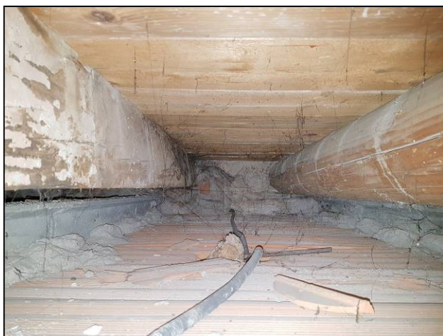
Solaio in legno H (saggio 11)
