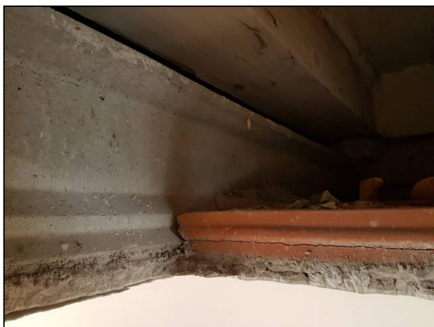
Controsoffitto C4 del solaio M con presenza di lesione corrente nel tavellone
