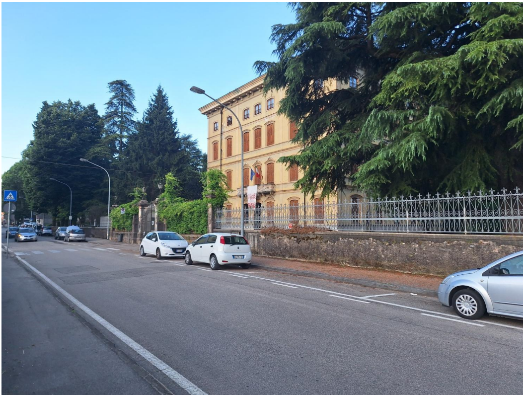
Foto 3 – Vista dell'edificio, accesso principale.
