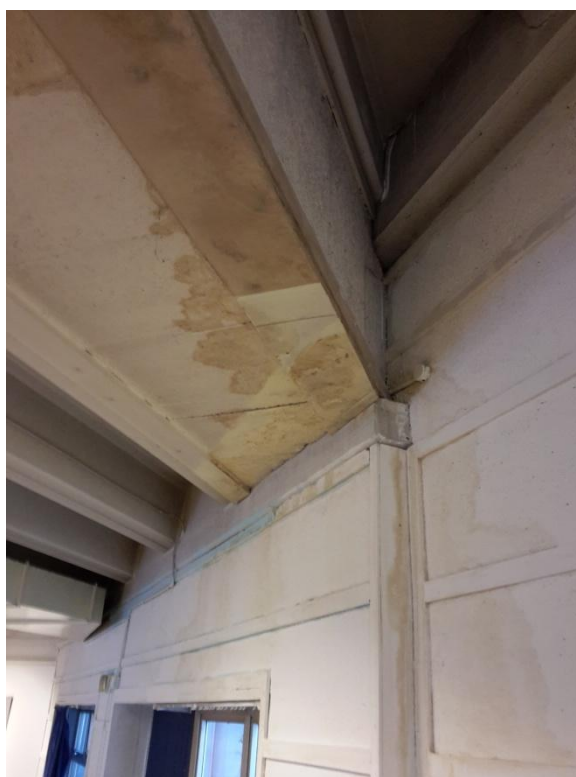
Dettaglio rivestimenti in lana di legno
