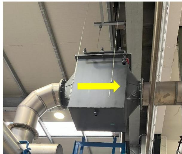
Figura 19: esempio di separatore a pacco lamellare
