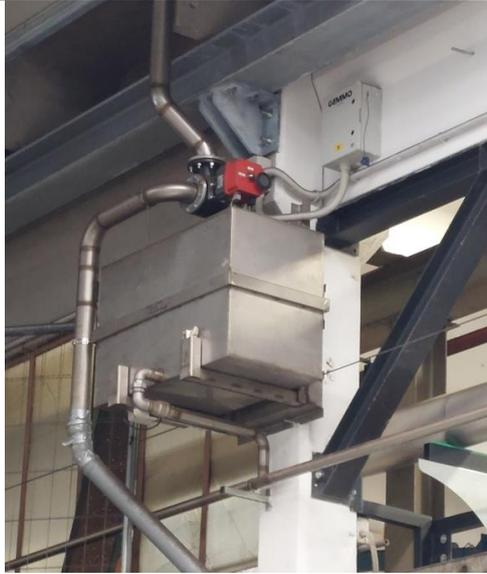
Figura 20: Cisternetta di raccolta delle meteoriche per l'invio all'anello delle acque di recupero
