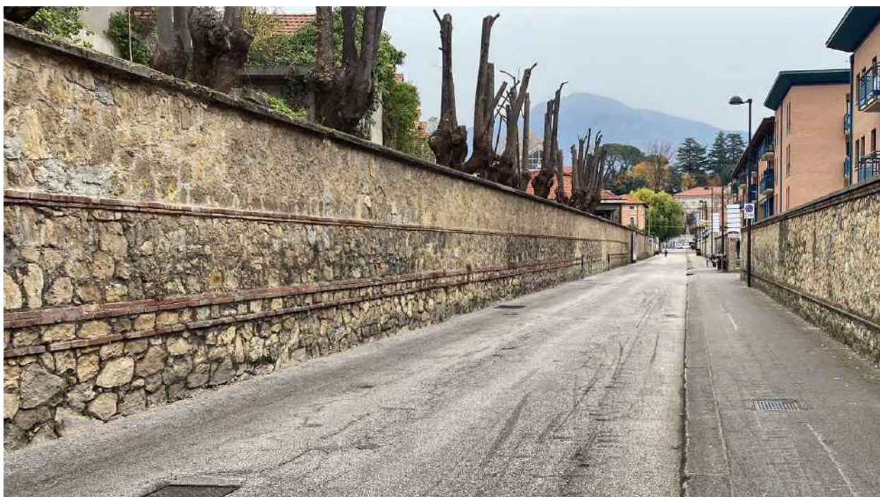
Figura 3.11 – Via XX Settembre
