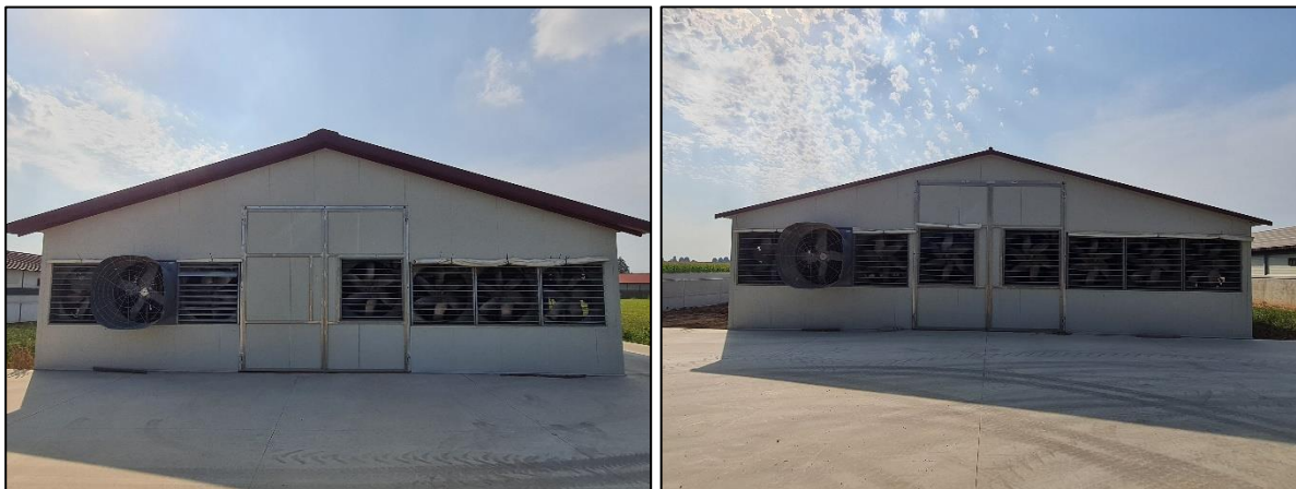
Fotografie del sistema di ventilazione forzata installato nei capannoni avicoli.
