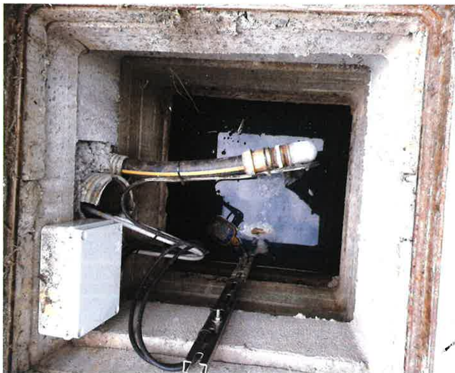
FOTO N° 7 : ispezione della vasca in corrispondenza della pompa di sollevamento per lo svuotamento entro le 48 ore dall'evento, o meglio dal riempimento del manufatto
