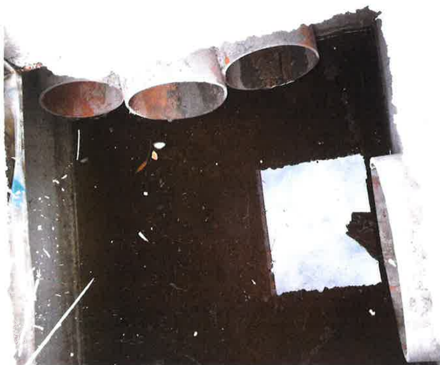
FOTO N° 4 - 5 : interno del pozzetto selezionatore e/o scolmatore con visibili, la condotta di arrivo dei piazzali, il by – pass della "seconda pioggia" (in destra foto n° 4) e l'alimentazione della vasca di "prima pioggia" (in alto foto n° 5, unitamente agli arrivi della nuova linea bianca posta al limite di proprietà con via Cà Berta e della nuova canaletta grigliata)
