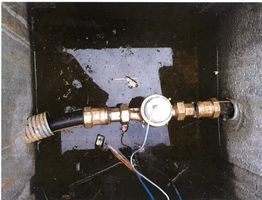
FOTO N° 9 : veduta dell'ispezione che precede il disoleatore di cui alla foto n° 8, in corrispondenza del contatore del tipo con emettitore di impulsi, posto lungo la mandata della pompa
