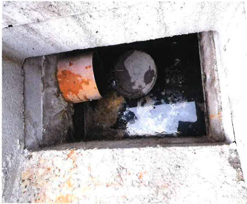
FOTO N° 6 : ispezione della vasca all'altezza dell'alimentazione della stessa, con osservabile la valvola antiriflusso, che blocca l'ingresso dell'acqua una volta raggiunto il massimo livello di accumulo
