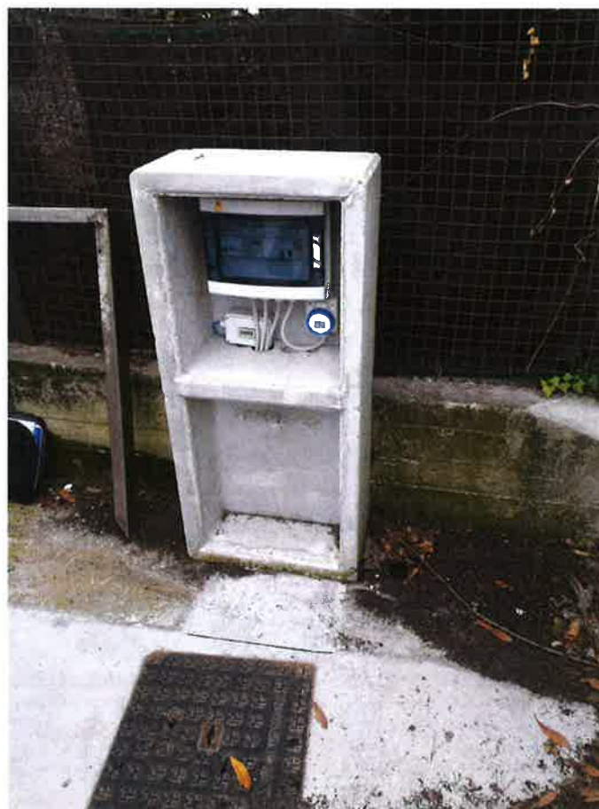
FOTO N° 11 : quadro elettrico di comando e di controllo della pompa, posto in apposito box prefabbricato in c.a.v., sito nei pressi dell'impianto.
