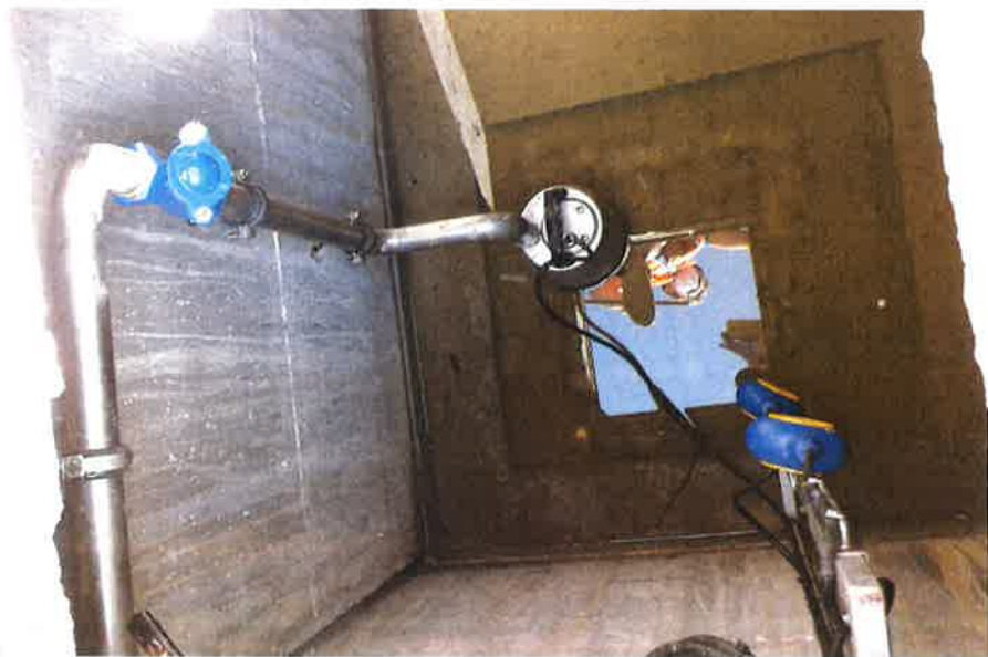
FOTO N° 13 : ispezione della vasca in opera in corrispondenza della pompa di sollevamento per lo svuotamento entro le 48 ore dall'evento, con visibili anche i galleggianti di regolazione
