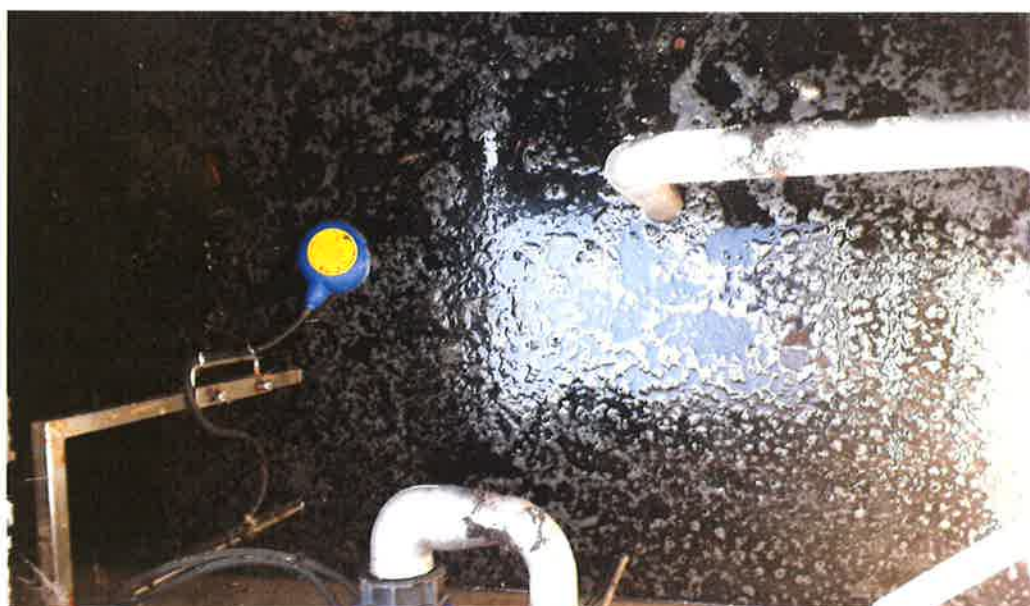
FOTO N° 18 : ispezione della vasca all'altezza della pompa di sollevamento per lo svuotamento entro le 48 ore dalla fine dell'evento
