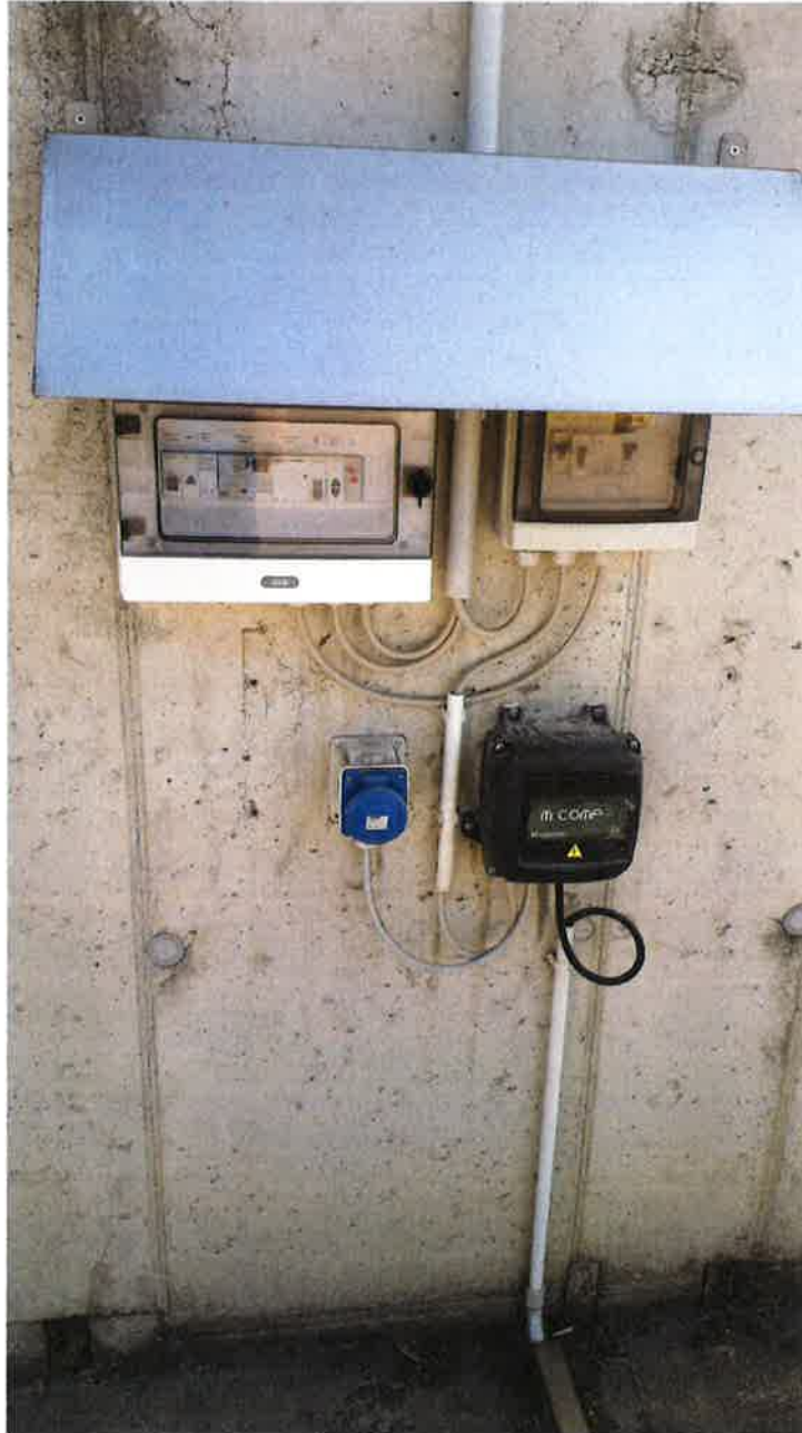
FOTO N° 16 : quadro elettrico di comando e di controllo della pompa di sollevamento, posizionato sul muro che delimita la proprietà lungo via Mottolo, nei pressi dell'impianto specifico.
