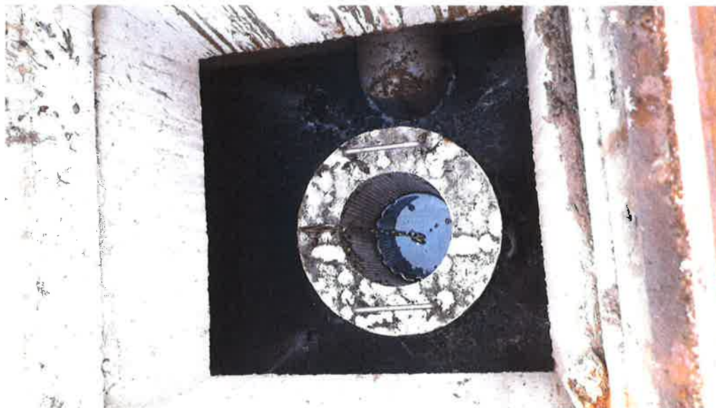
FOTO N° 19 : veduta dell'ispezione del disoleatore in corrispondenza del filtro a coalescenza.
