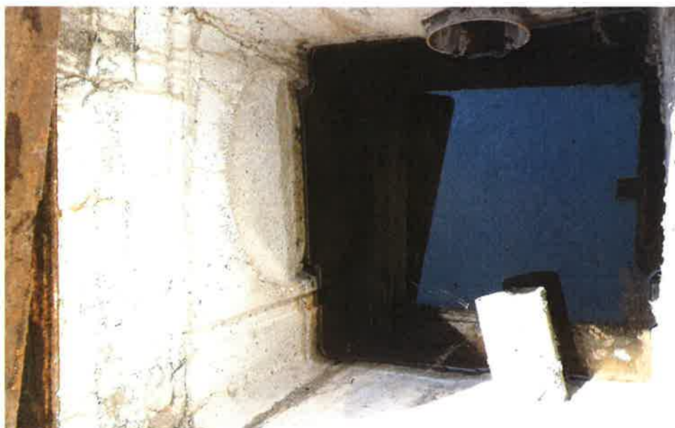
FOTO N° 3 : pozzetto di campionamento della "prima pioggia" trattata
