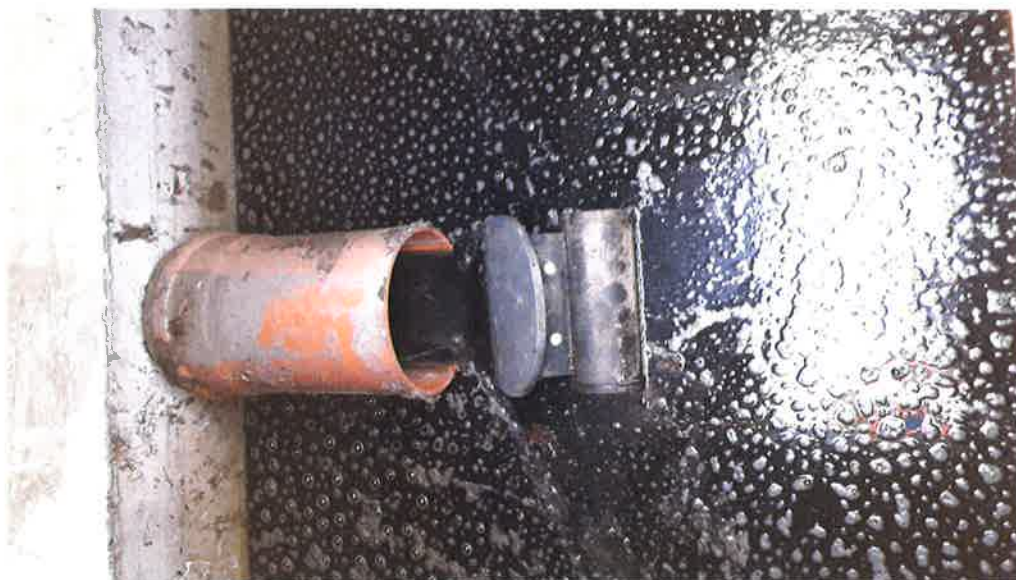
FOTO N° 17 : alimentazione della vasca di "prima pioggia" in opera con valvola antiriflusso per il blocco dell'ingresso dell'acqua una volta raggiunto il livello di massimo accumulo
