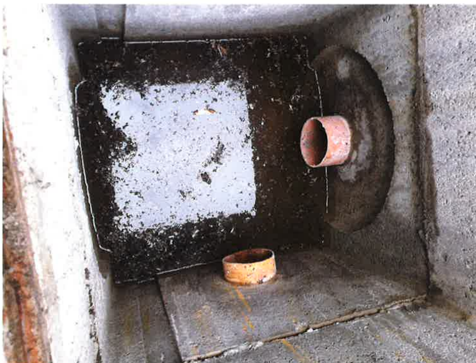
FOTO N° 10 : pozzetto di campionamento della "prima pioggia" trattata a monte dell'innesto con il by - pass della "seconda pioggia".
