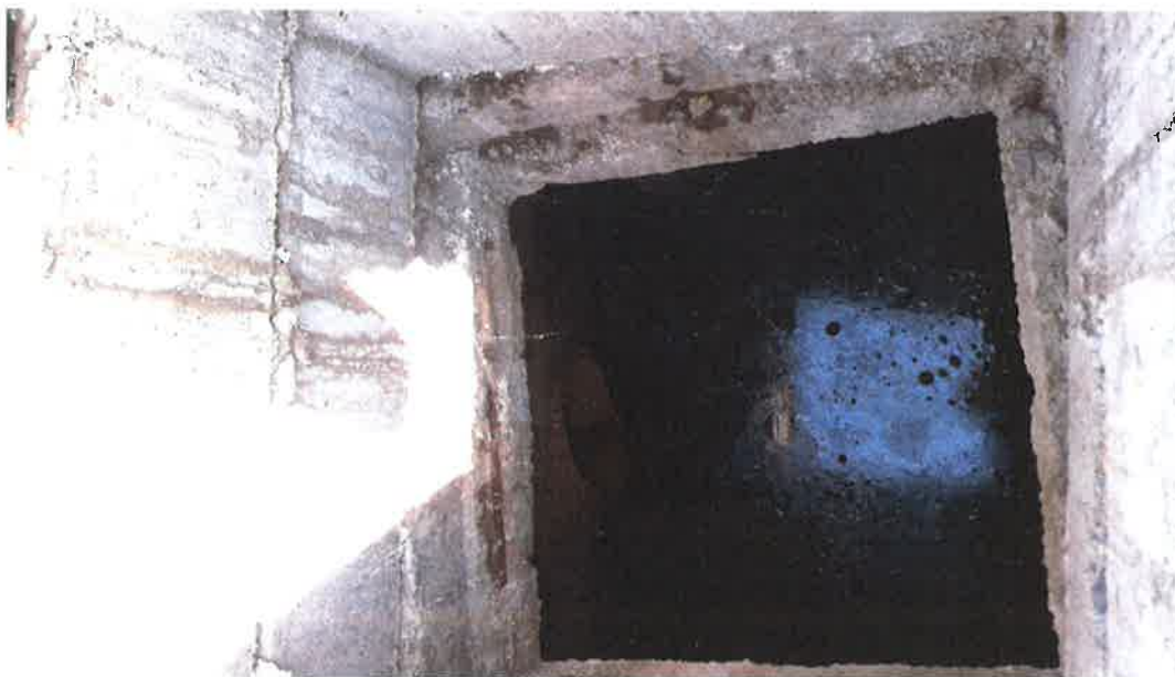
FOTO N° 20 : interno dell'ispezione di confluenza della linea della "prima pioggia" trattata e del by – pass della "seconda pioggia", dal quale si diparte la tubazione finale di recapito allo Scolo Frassenella.
