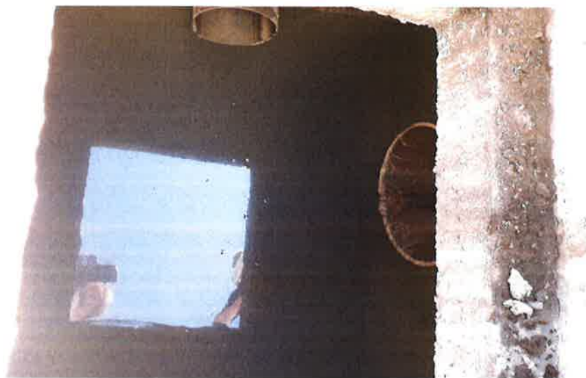
FOTO N° 1 : interno del pozzetto selezionatore – scolmatore che separa la "prima" dalla "seconda pioggia", con visibile il by – pass e l'alimentazione del monoblocco prefabbricato in c.a.v. di trattamento.
