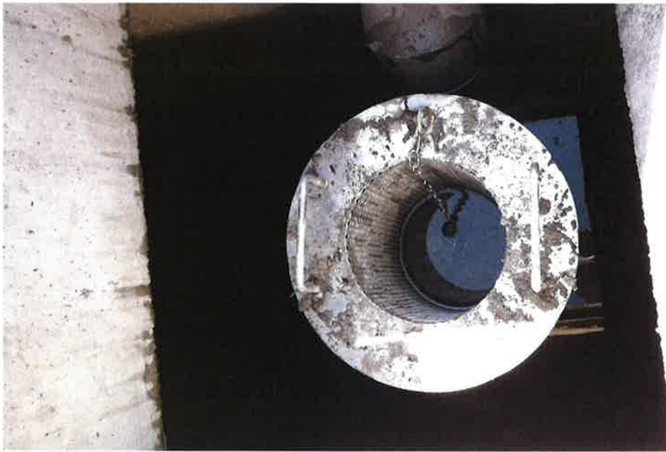
FOTO N° 14 : ispezione del disoleatore con in primo piano il filtro a coalescenza
