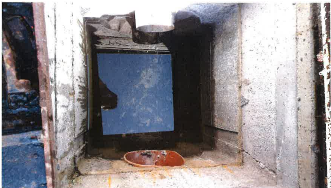
FOTO N° 15 : pozzetto di campionamento della "prima pioggia" trattata
