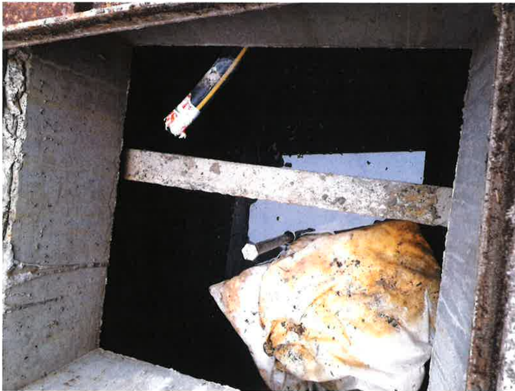
FOTO N° 8 : interno del disoleatore con visibili i filtri oleoassorbenti ed il tubo per la periodica pulizia del filtro a coalescenza con aria compressa
