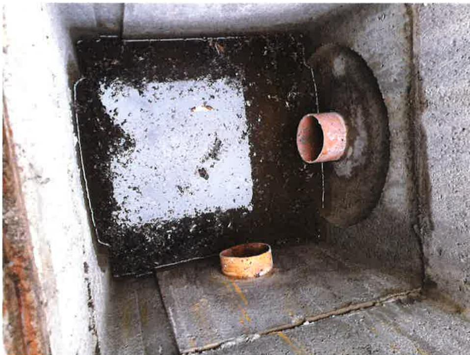
FOTO N° 10 : pozzetto di campionamento della "prima pioggia" trattata a monte dell'innesto con il by - pass della "seconda pioggia".
