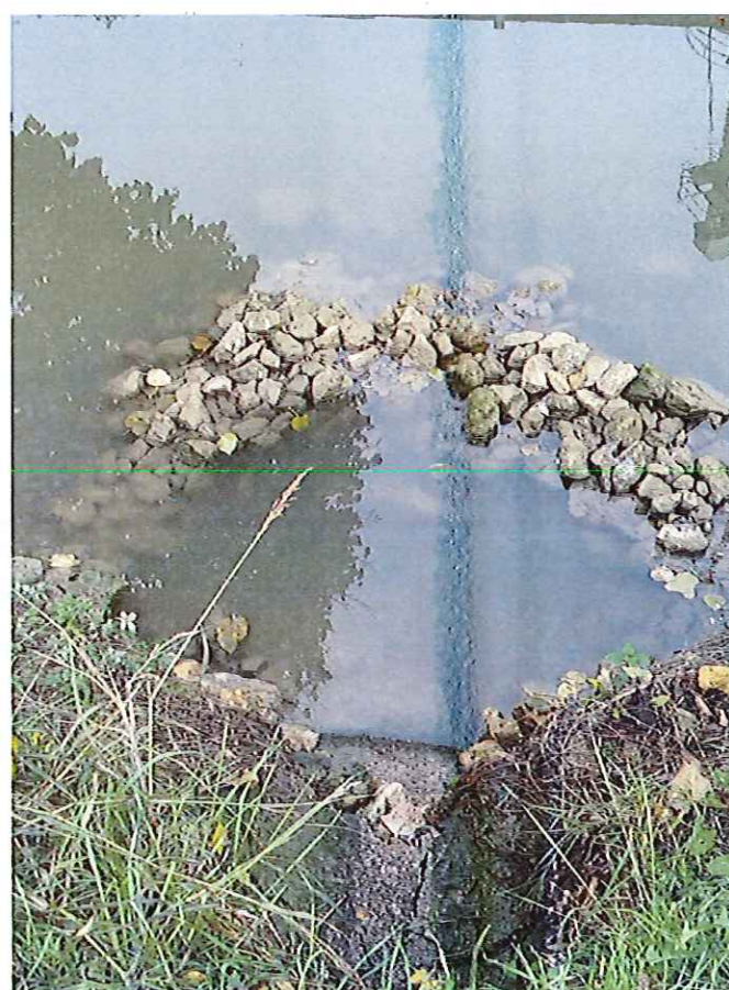
FOTO N° 24 : dettaglio scogliera alla base scarico meteorico
