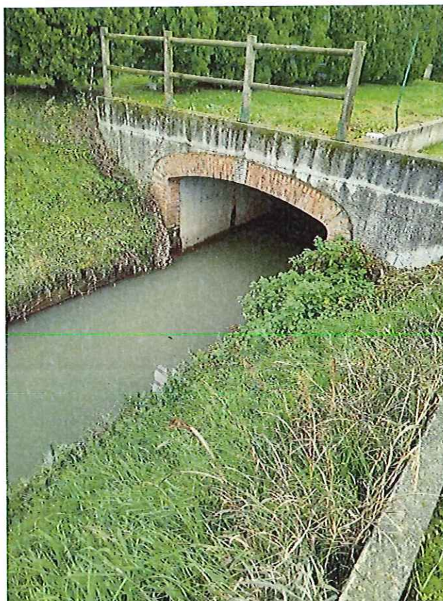
FOTO N° 11 : veduta del ponticello in corrispondenza del passaggio fra il settore tombinato a monte proveniente dal ponte di via S. Sepolcro ed il successivo tratto a cielo aperto con sponde in terra e parte basale sempre con canale prefabbricata delle dimensioni di 3.5 m x 1.5 m.
