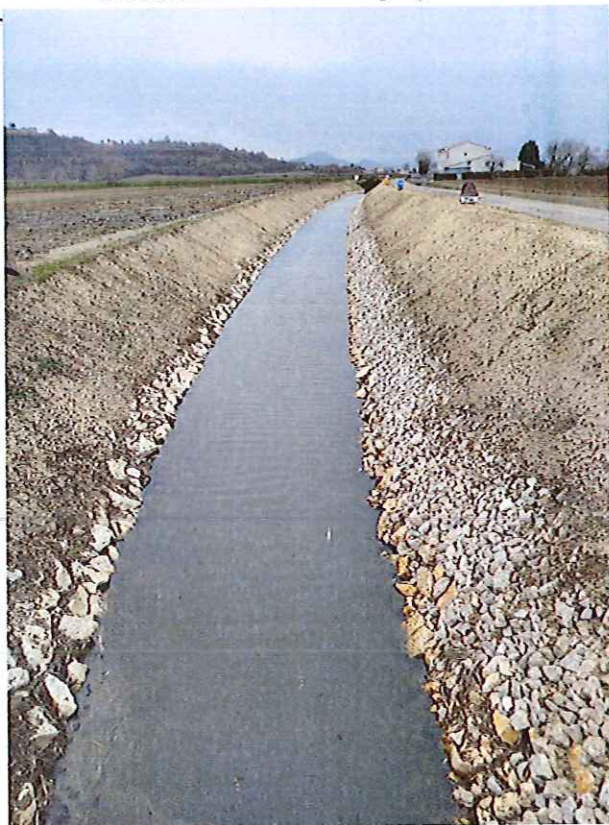
FOTO N° 6 : panoramica del ramo del corso d'acqua che si sviluppa a monte di via Palù, oggetto di un recente intervento di risezionamento, pulizia del fondo e di sistemazione.
