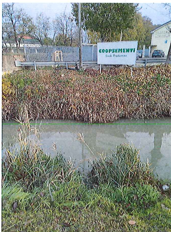
FOTO N° 15 : panoramica della sezione n° 1 di rilievo.
