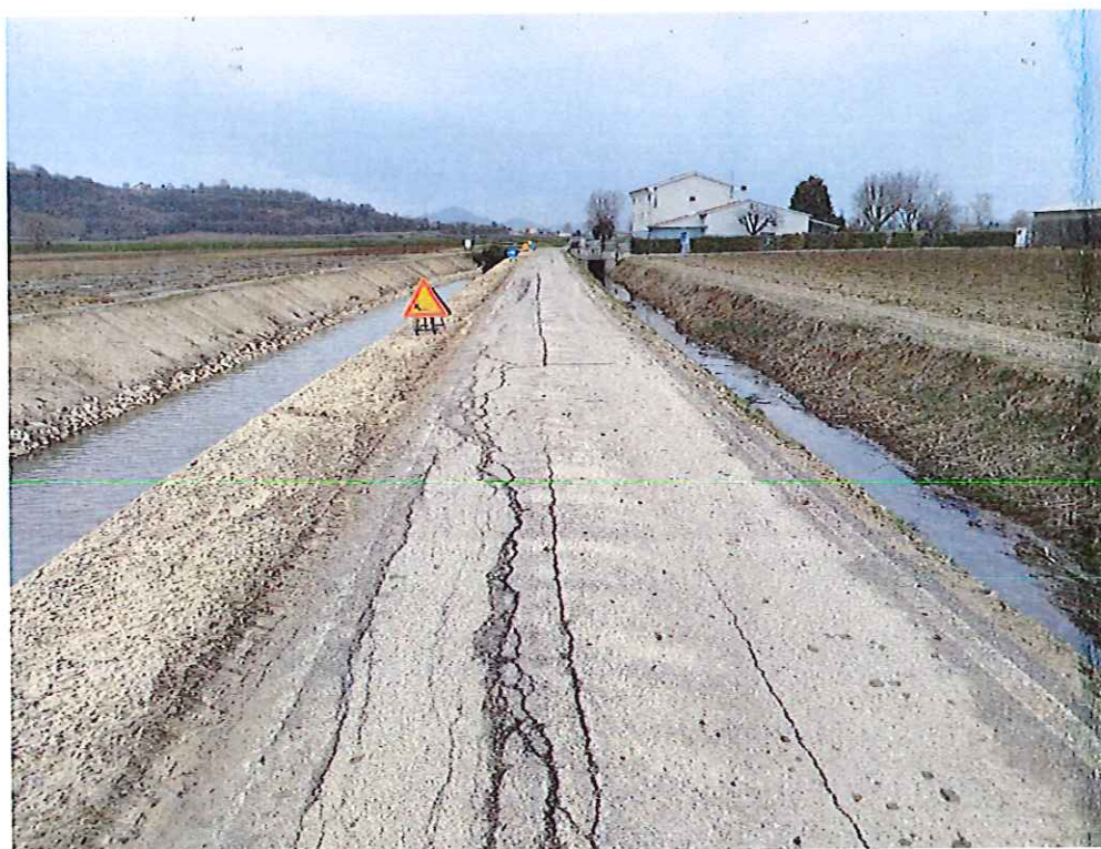
FOTO N° 7 : veduta dei due rami dello Scolo Frassenella che proseguono parallelamente alla strada comunale succitata verso est.
