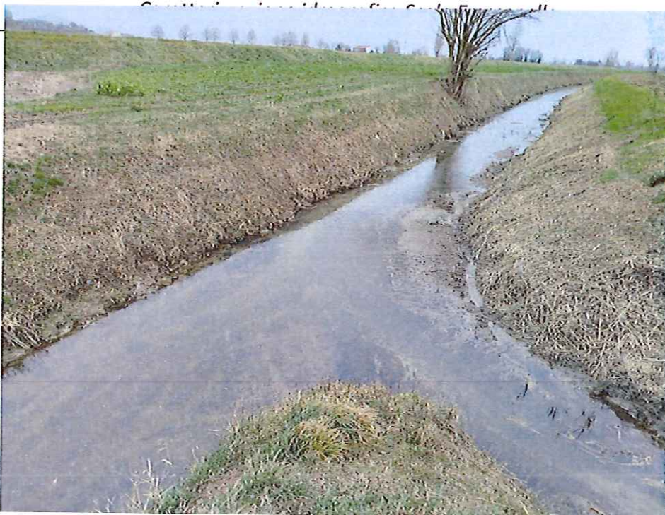
FOTO N° 8 : confluenza dei due rami di cui alla foto precedente in un unico tracciato a circa 150 m ad est dal termine di via Palù; in sinistra foto è visibile il rilevato arginale del vicino Scolo Lione.
