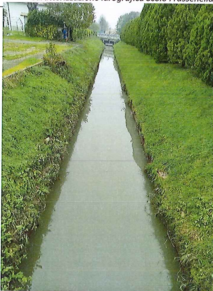
FOTO N° 12 : panoramica verso valle del tratto canalizzato di cui alla foto precedente, con visibile sullo sfondo il ponte lungo la S.P. "Berico – Euganea".
