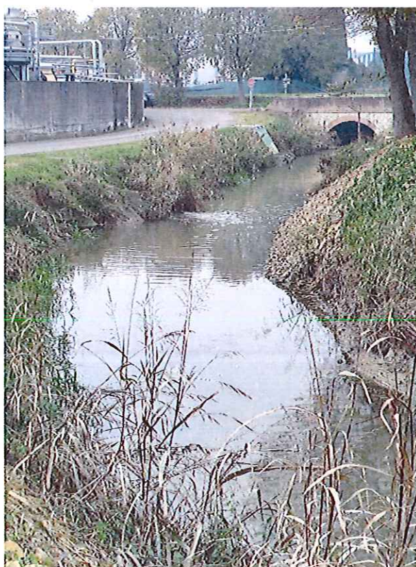
FOTO N° 36 : panoramica dello Scolo Frassenella con osservabili, sullo sfondo il ponte di via Liona, sulla sponda sinistra (destra idrografica) l'opera di presa e lo scarico produttivo della Ditta Coelsanus S.p.A., nonché lo scarico posto nelle vicinanze di un'altra Ditta limitrofa.
