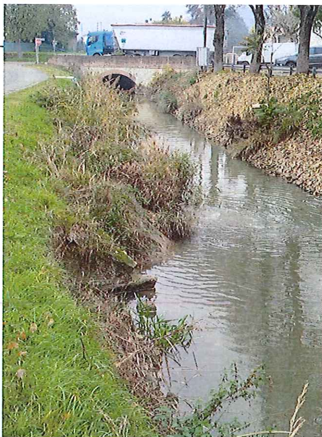
FOTO N° 19 : panoramica dello Scolo Frassenella all'altezza dei due scarichi, quello più lontano di natura produttiva della Ditta Coelsanus S.p.A., quello più vicino proveniente da altra Azienda.
