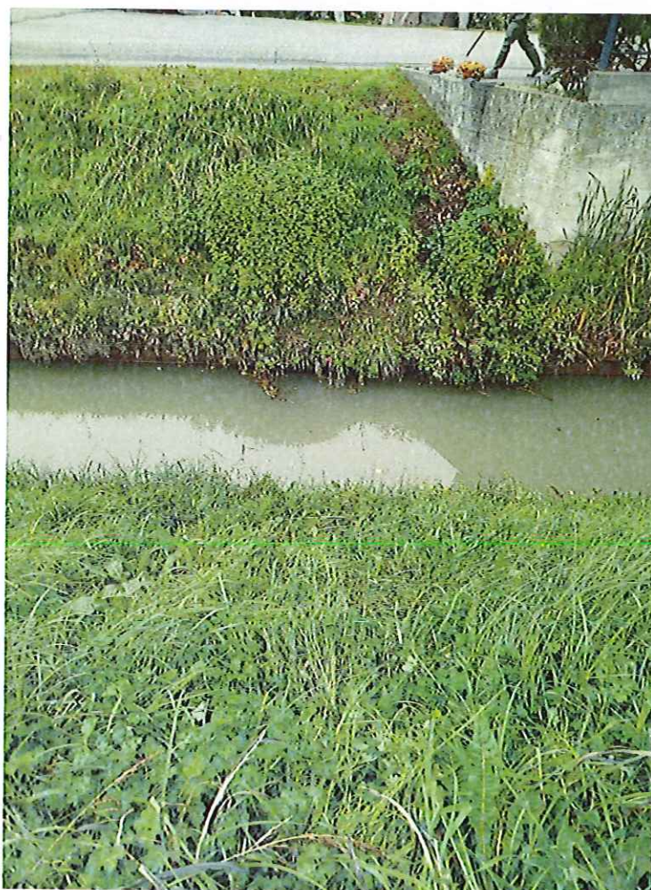
FOTO N° 9 : tratto dello Scolo in attraversamento dell'abitato di Sossano oggetto di intervento di sistemazione nel 2005, con inserimento alla base di una sezione canalizzata prefabbricata delle dimensioni interne di 3.5 m x 1.5 m (h), e sponde laterali in terra.
