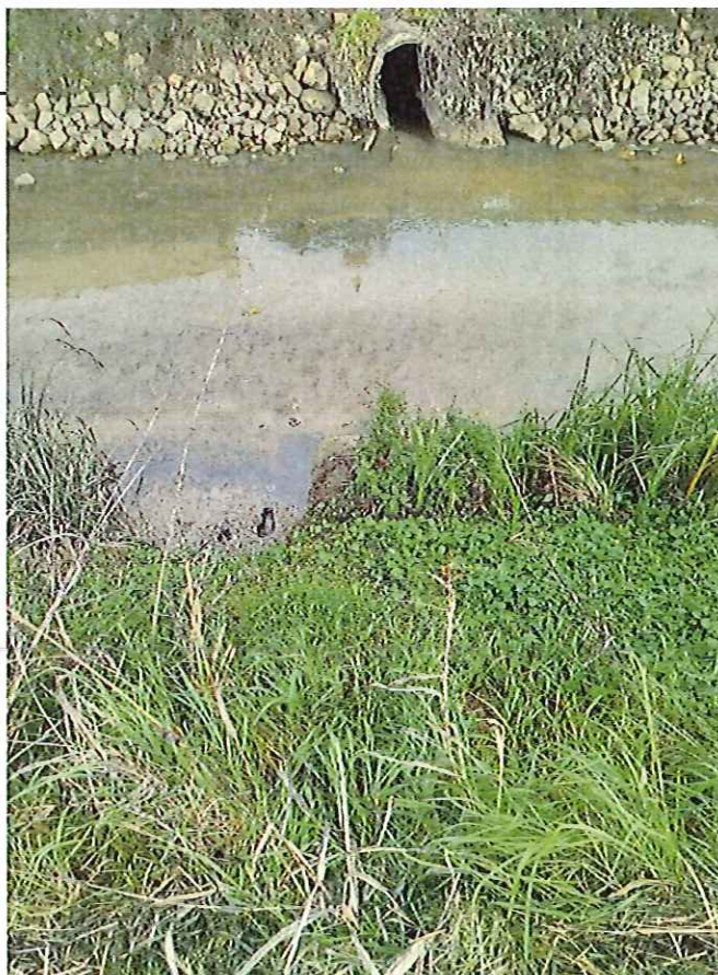
FOTO N° 33 : panoramica della sezione n° 14 di rilievo con osservabili, in sinistra idrografica la condotta D = 1000 mm di recapito dalla Ditta insediata sul lato opposto del corso d'acqua, e in destra idrografica, la condotta D = 600 mm in cls che rappresenta l'ultimo tratto intubato del fossato posto immediatamente ad est della proprietà Coelsanus S.p.A.
