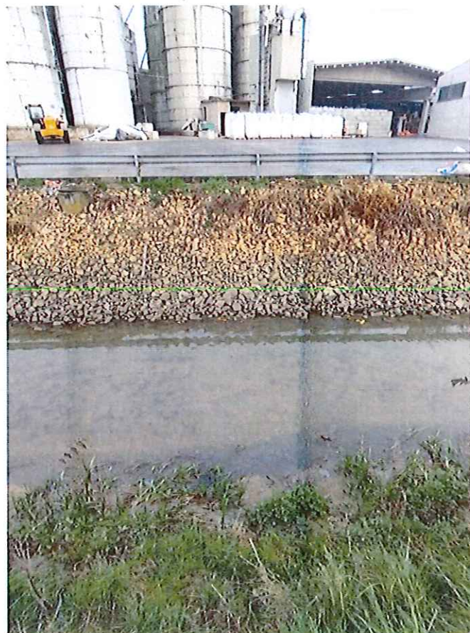
FOTO N° 28 : panoramica della sezione n° 9 di rilievo.
