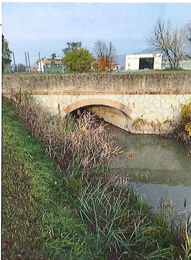
FOTO N° 14 : panoramica del ponte di via Liona con rivestimento in lastre di pietrame e con parti in muratura di laterizio, costituente lo sbocco della botte a sifone di cui alla foto precedente.
