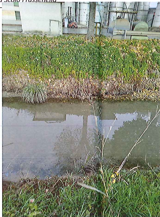
FOTO N° 22 : panoramica della sezione n° 4 di rilievo
