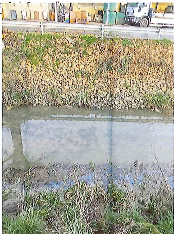
FOTO N° 26 : panoramica della sezione n° 7 di rilievo.
