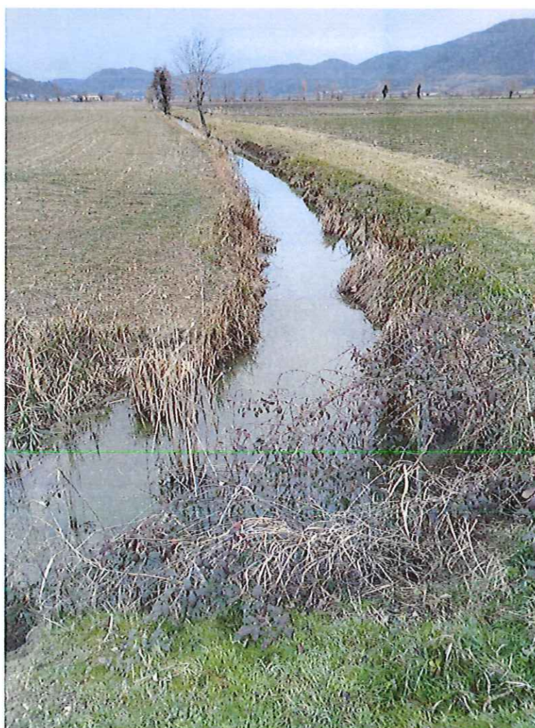
FOTO N° 3 : altro affluente da monte con deviazione all'altezza di via Palù verso il nodo idraulico di cui alla foto precedente.
