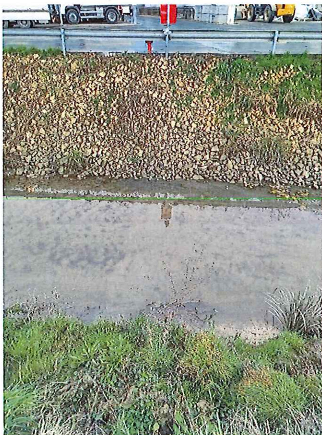
FOTO N° 27 : panoramica della sezione n° 8 di rilievo
