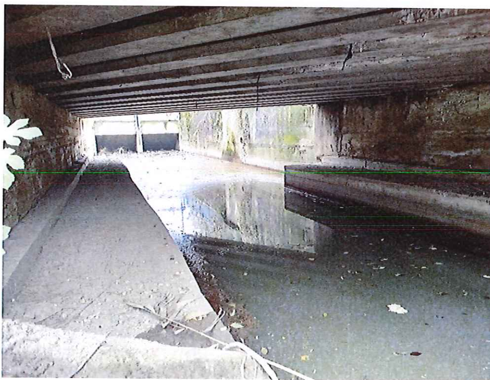
FOTO N° 13 : veduta della parte sottostante al ponte della S.P. "Berico – Euganea" oggetto di realizzazione di una platea di fondazione e di rinforzi basali delle spalle : sullo sfondo, la camera di "calma" e la paratoia di regolazione della botte a sifone che sottopassa il canale LEB.
