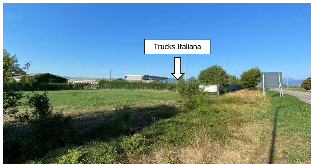
FIGURA 8. RIPRESA FOTOGRAFICA DALLA SP 111, PRESSO IL LATO NORD-EST. LA SIEPE DI CIPRESO DI LAWSON E IL FILARE DI BAGOLARO CONSENTONO DI MITIGARE IN MODO SIGNIFICATIVO LA PERCEZIONE VISIVA DEI VOLUMI AZIENDALI E DELL'ATTIVITA' DI AUTODEMOLIZIONE.
