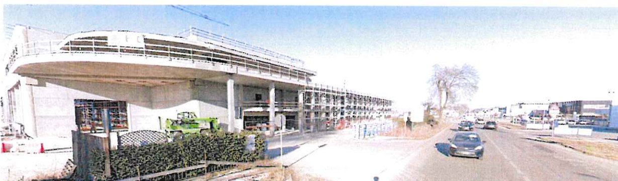
Figura 4 - Vista angolare esterna dell'accesso sud allo stabilimento dalla S.R. 11 "Padana Superiore"
