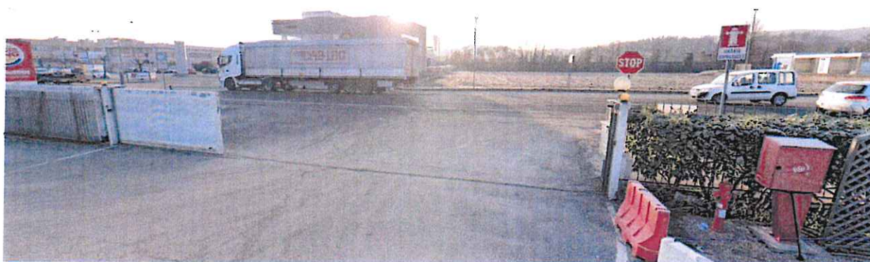
Figura 5 - Vista angolare interna dell'accesso sud allo stabilimento dall'area di pertinenza scoperta
