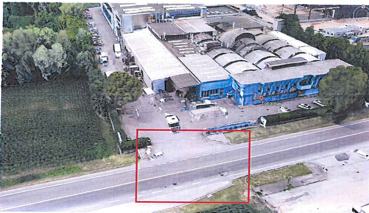
Figura 6 - Vista angolare dell'accesso sud allo stabilimento
