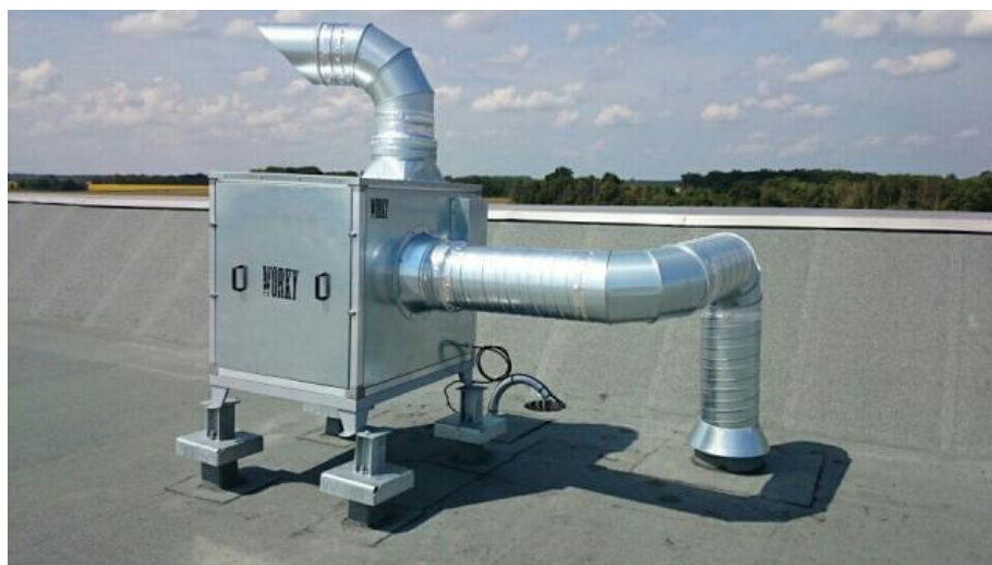
Figura 9: Esempio di Impianto di aspirazione.
