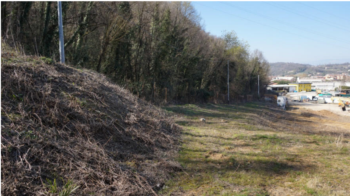
Figura 8 - Area di intervento - porzione ovest. Si noti la presenza dell'elettrodotto in area in disponibilità alla Ditta (marzo 2022).
