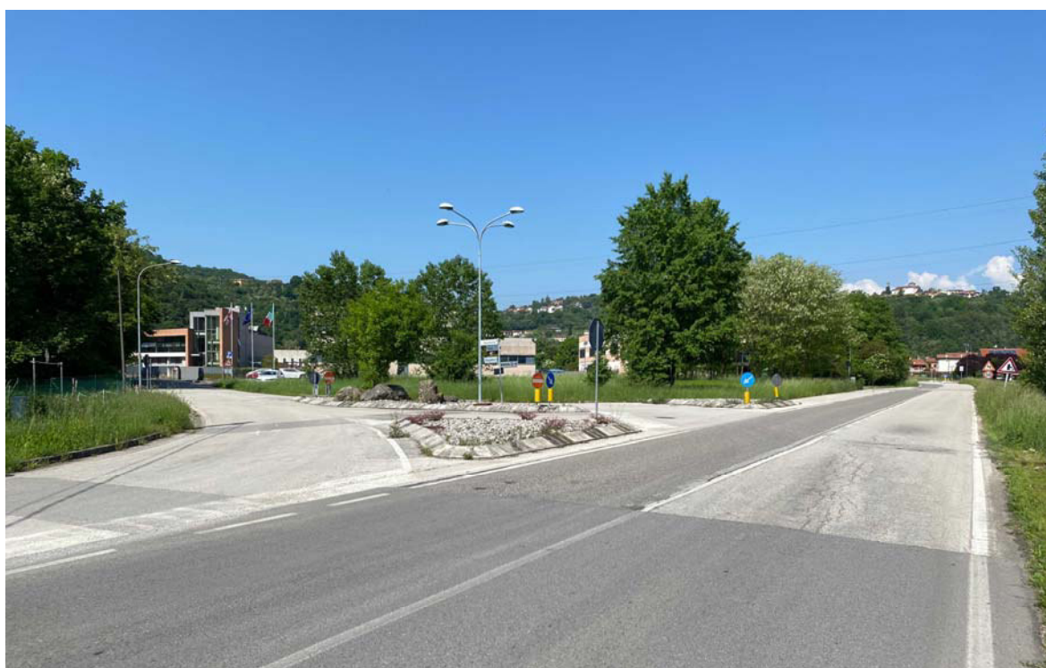
Figura 10 – intersezione SP36 – via Canestrello – vista da SP36
