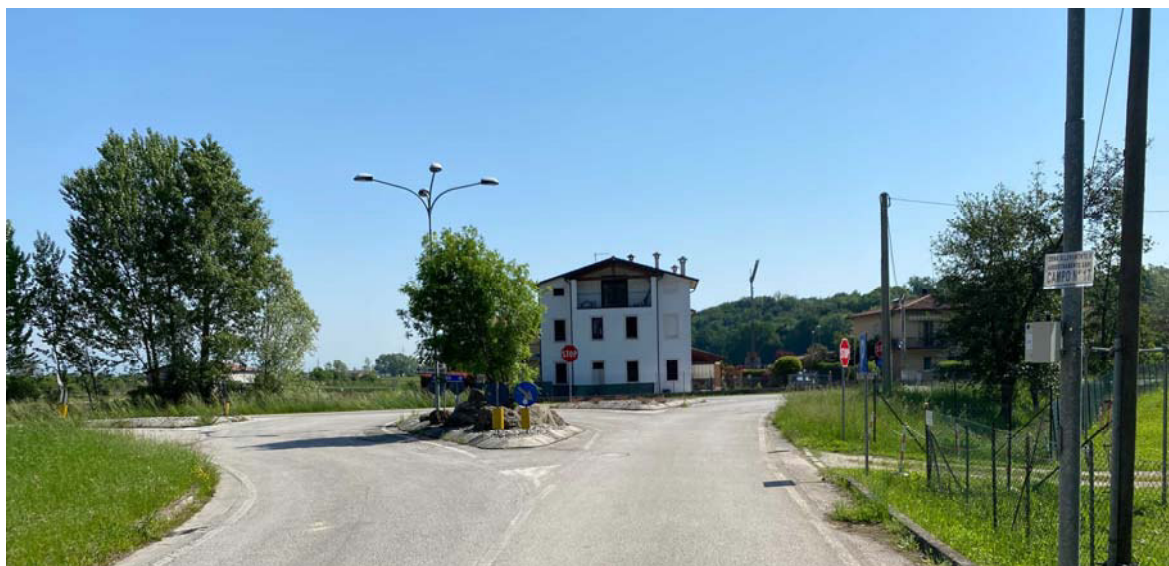
Figura 9 – intersezione SP36 – via Canestrello – vista da via Canestrello
