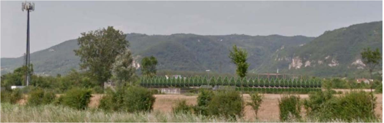
Figura 37: Vista 1 da via Ponte di Costozza: stato post-operam
