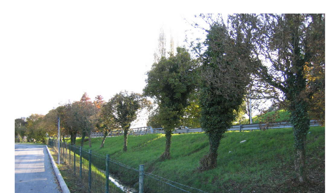
FOTO 5 QUINTA VEGETATIVA DI SEPARAZIONE CON RACCORDO AUTOSTRADALE
