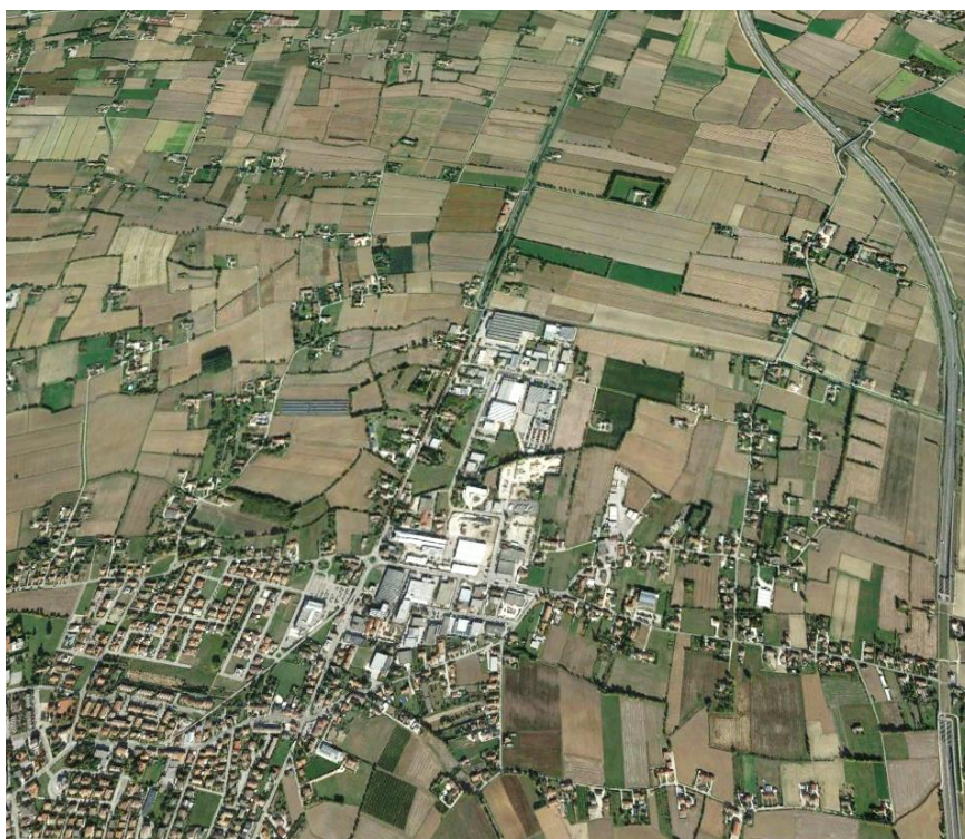
Inquadramento dell'ambito di intervento (area produttiva loc. Bergoncino), tra la A31 (Valdastico Sud) e la Provinciale n. 247 Riviera Berica .
