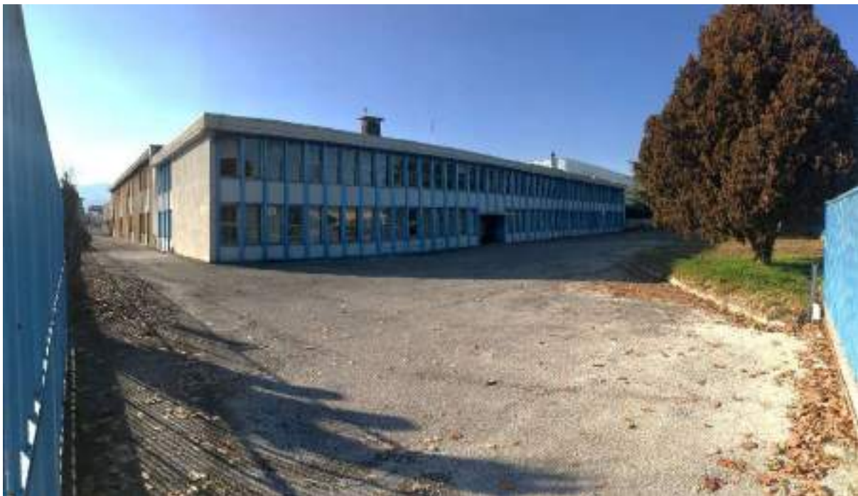
FIGURA 20. PIAZZALE EST (ACCESSO IN PROSSIMITA' DELLA SP46) E PALAZZINA UFFICI.
