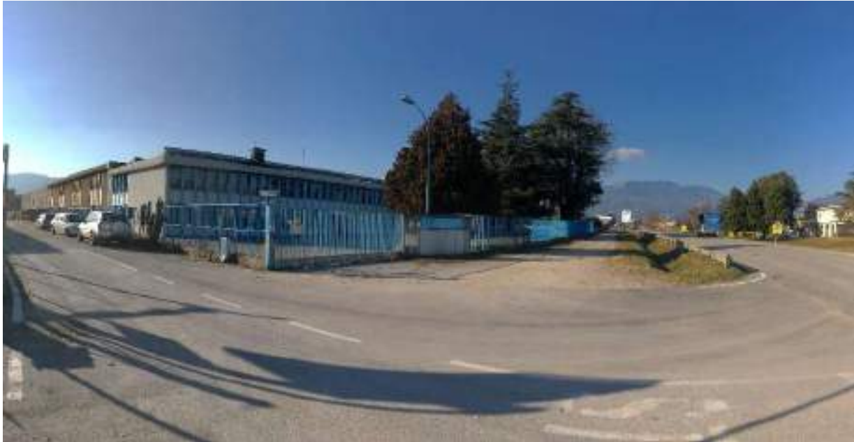
FIGURA 19. L'AREA AZIENDALE RIPRESA DALL'ACCESSO IN PROSSIMITA' DELLA SP46.
