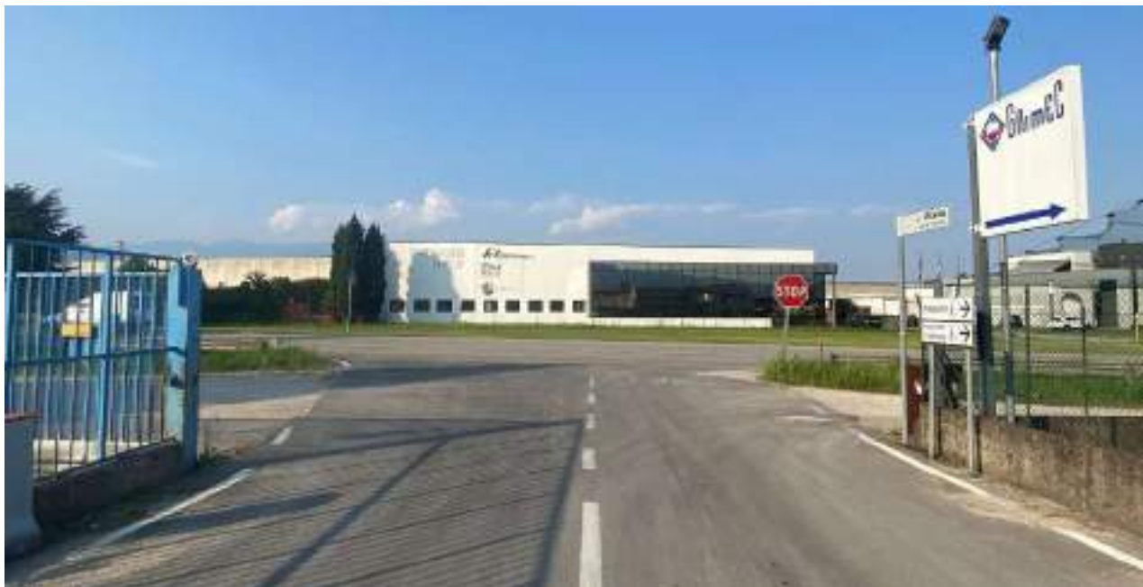
Figura 1.8 Vista Intersezione a raso tra la SP 46 “del Pasubio” e Via Vicenza
