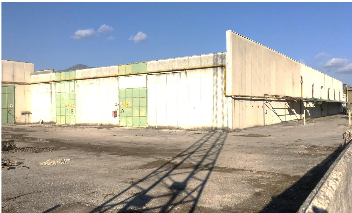
FIGURA 8. PIAZZALE OVEST DESTINATO AL TRANSITO DEI MEZZI CONFERENTI E AL RIMESSAGGIO DI CASSONI PULITI.
