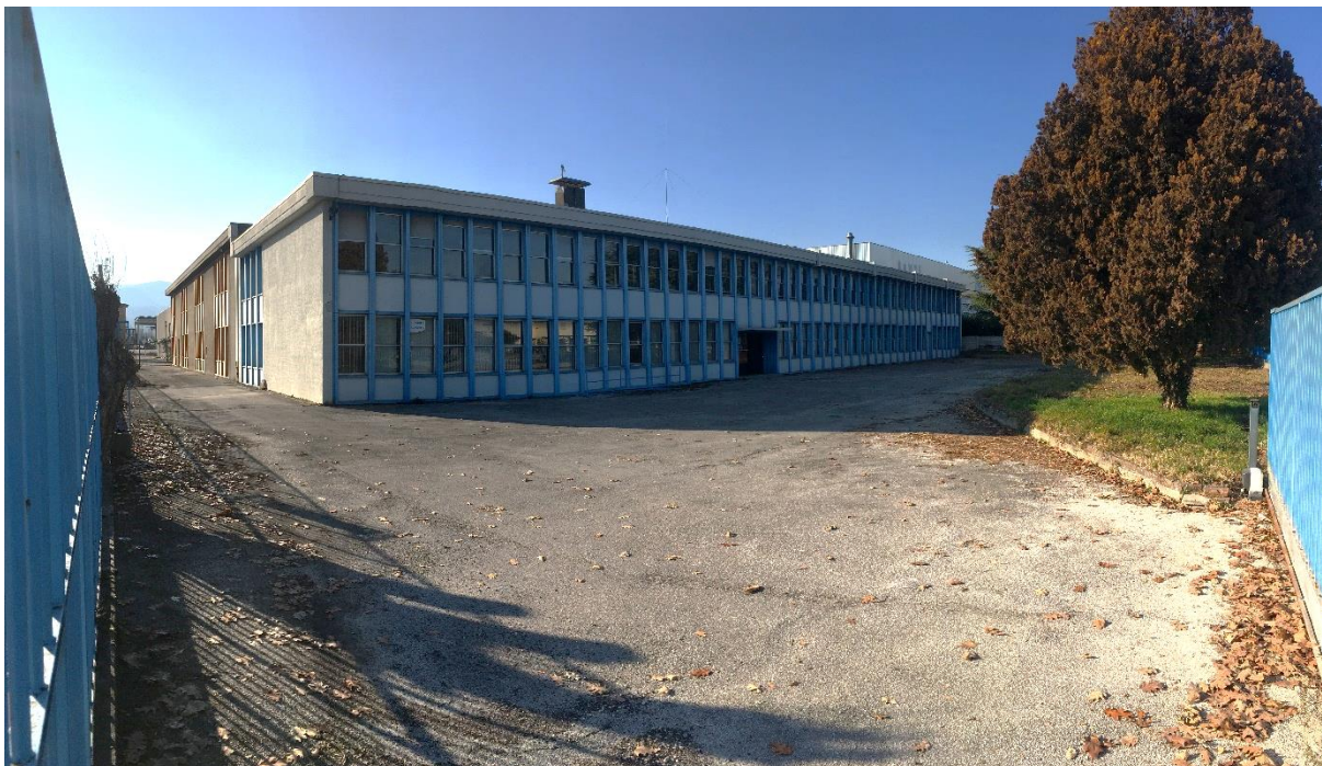
FIGURA 7. PIAZZALE EST (ACCESSO IN PROSSIMITA' DELLA SP46) E PALAZZINA UFFICI.
