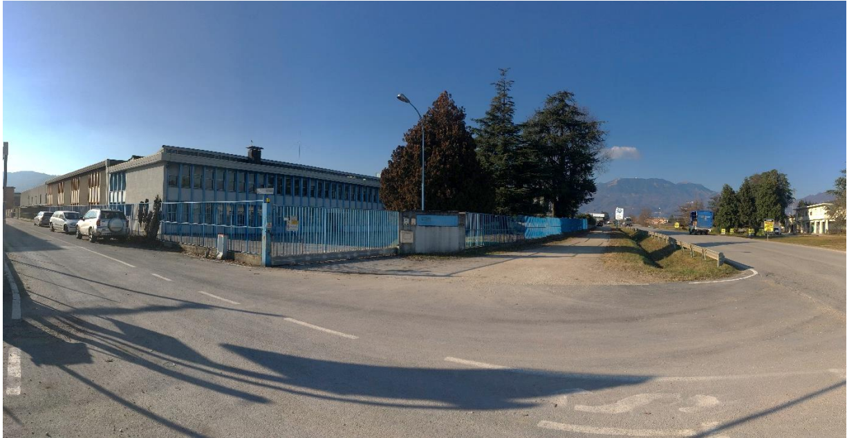
FIGURA 6. L'AREA AZIENDALE RIPRESA DALL'ACCESSO IN PROSSIMITA' DELLA SP46.
