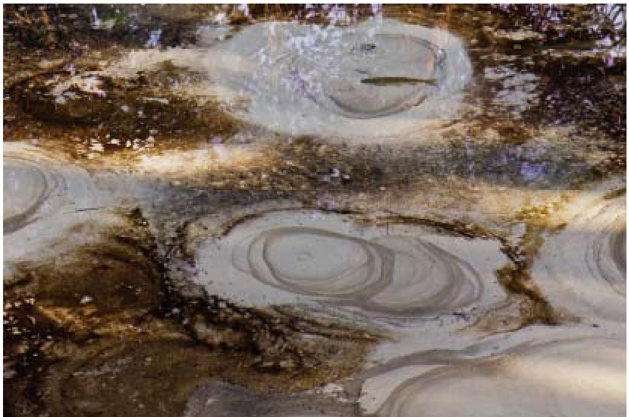
Figura 7 - Sifonamento conseguente al fenomeno di risorgenza
