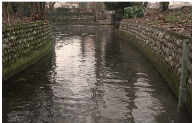
Figura 5 - Tubo idrometrico di calma installato presso R2
