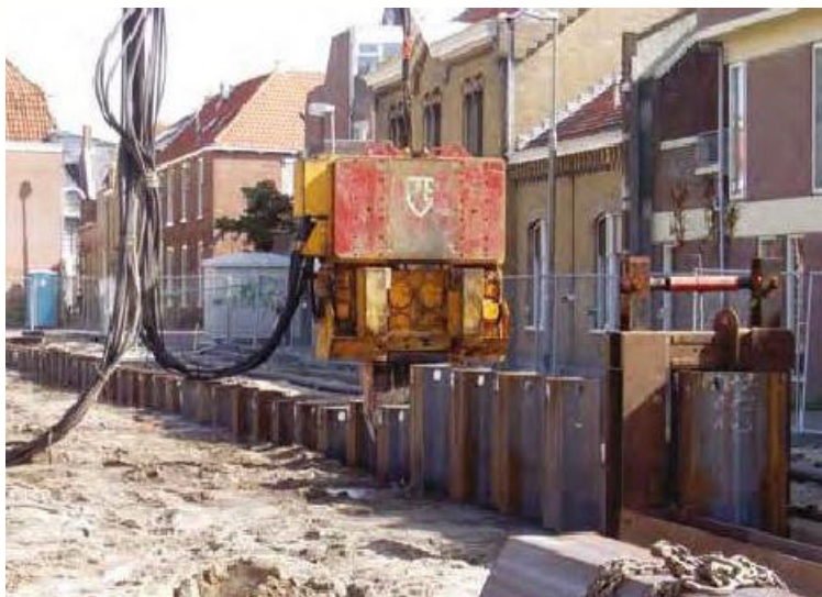
Figura 51 esempio di palancolata in fase di infissione
