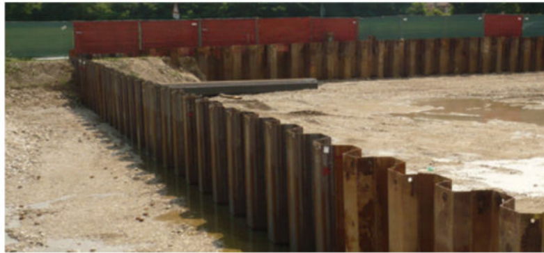
Figura 50 esempio di scavo in fase di esecuzione sostenuto da palancole
