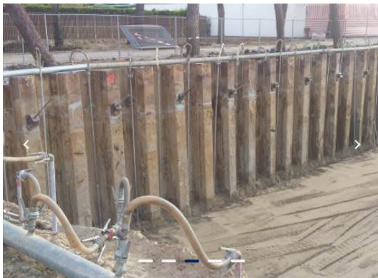
Figura 52 esempio di cantiere con palancolata e impianto well-point
