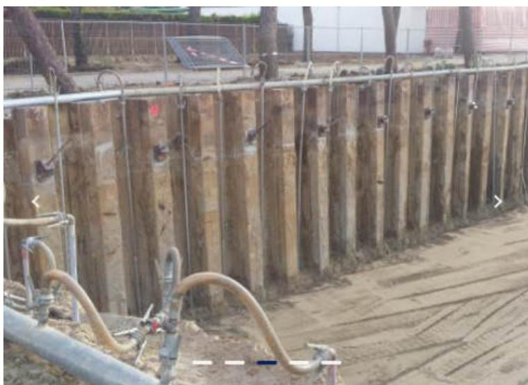
Figura 48 esempio di cantiere con palancolata e impianto well-point
