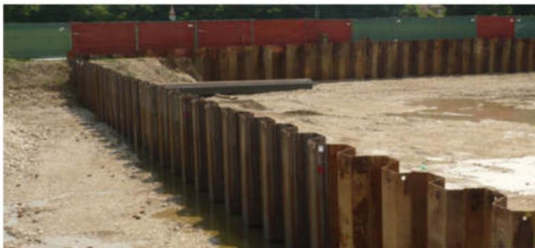
Figura 46 esempio di scavo in fase di esecuzione sostenuto da palancole
