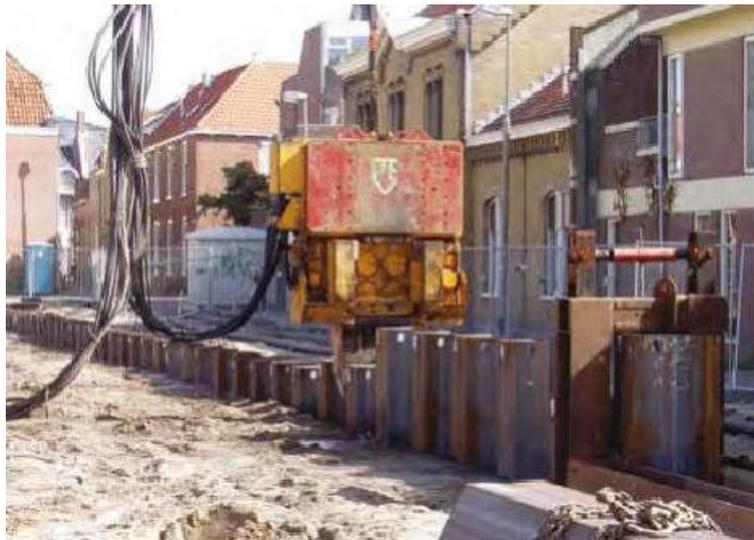
*Figura 47 esempio di palancole in fase di infissione*
