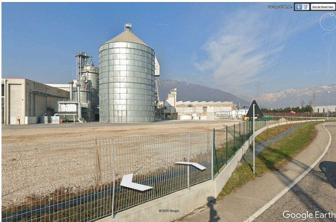
Figura 5 – Lo stabilimento – immagine street view. Si noti il filare arboreo arbustivo recentemente messo a dimora lungo il confine dell'area di proprietà.
