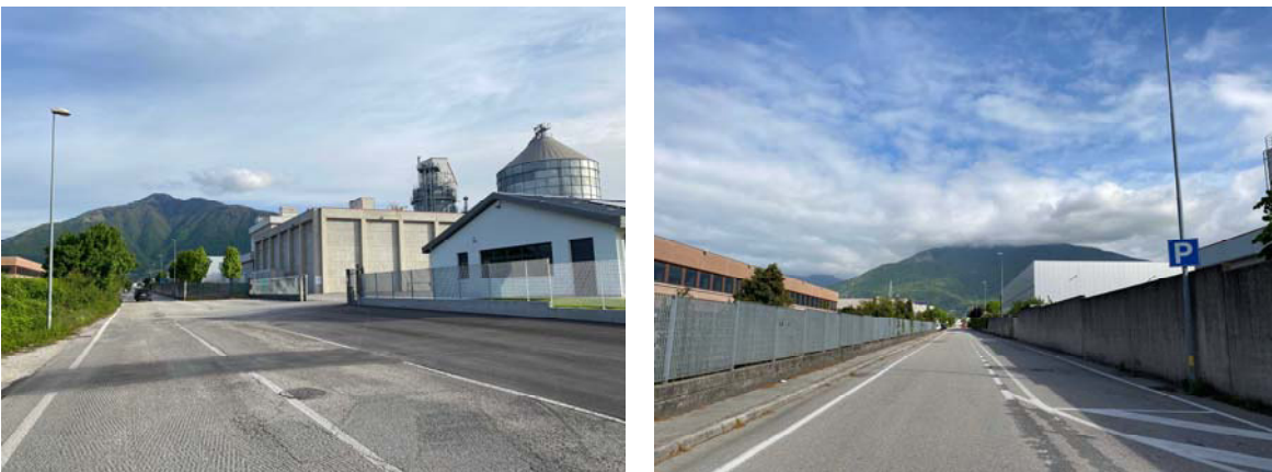
Figura 24 – Accesso impianto produttivo e tratto di via Lago di Lugano a senso unico
