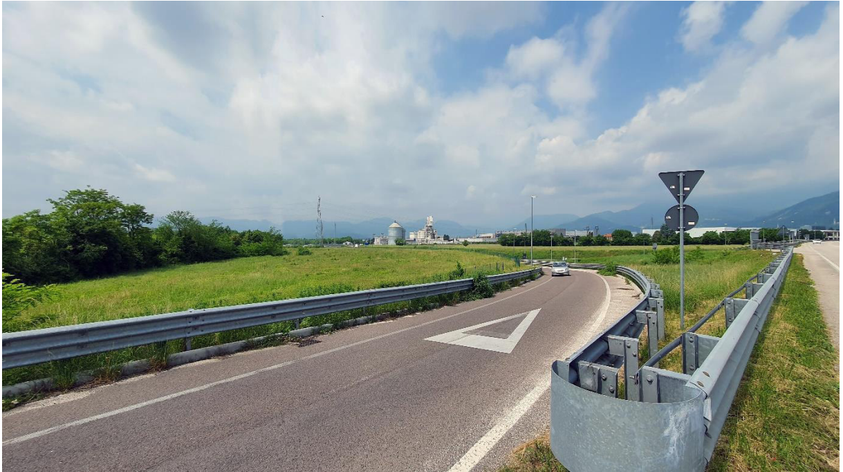
Figura 156: Vista da via dell'Autostrada ante e post intervento.
