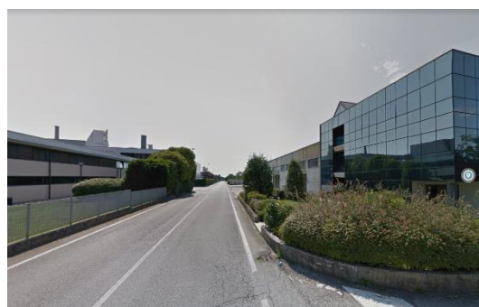
Vista da Via Lago di Alleghe incrocio via Lago di Costanza
