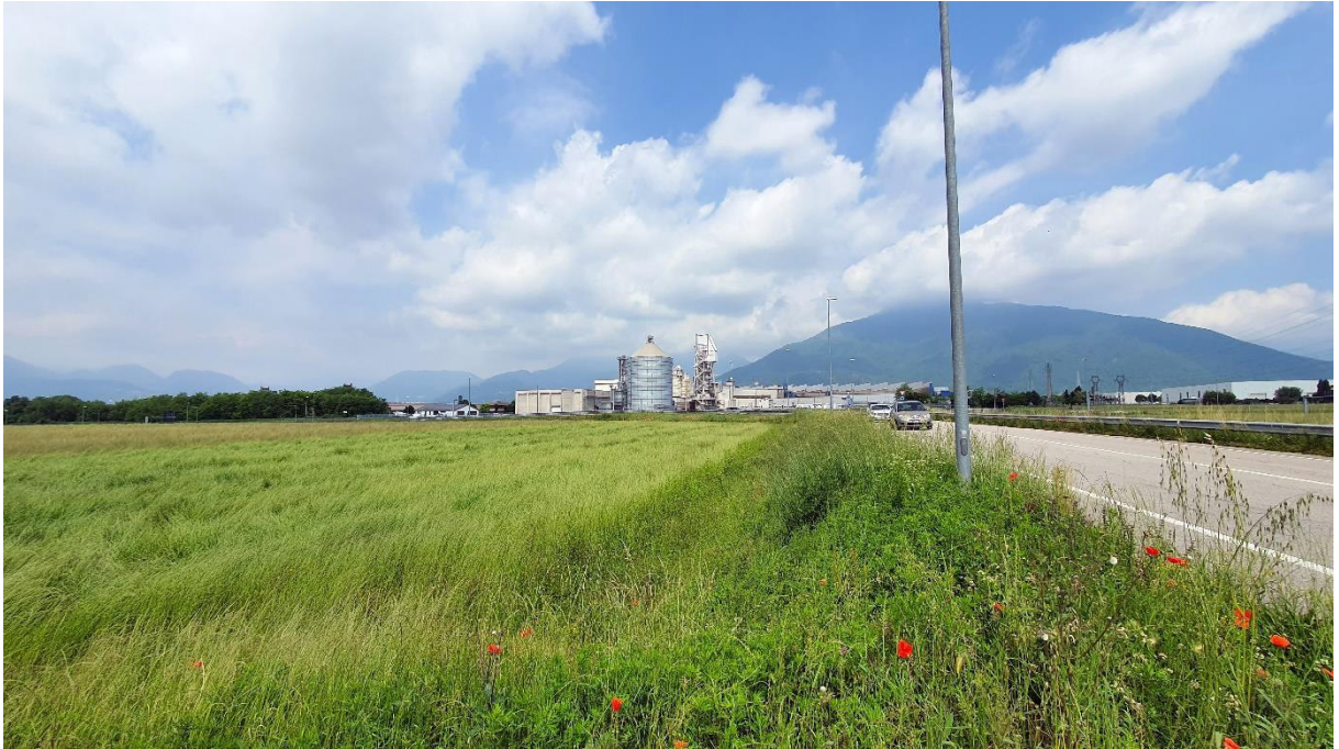
Figura 155: Vista da via Due Camini ante e post intervento.
