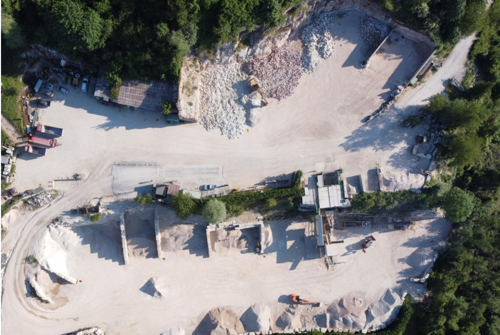
Foto n. 1 – Impianto esistente ripresa da sud
