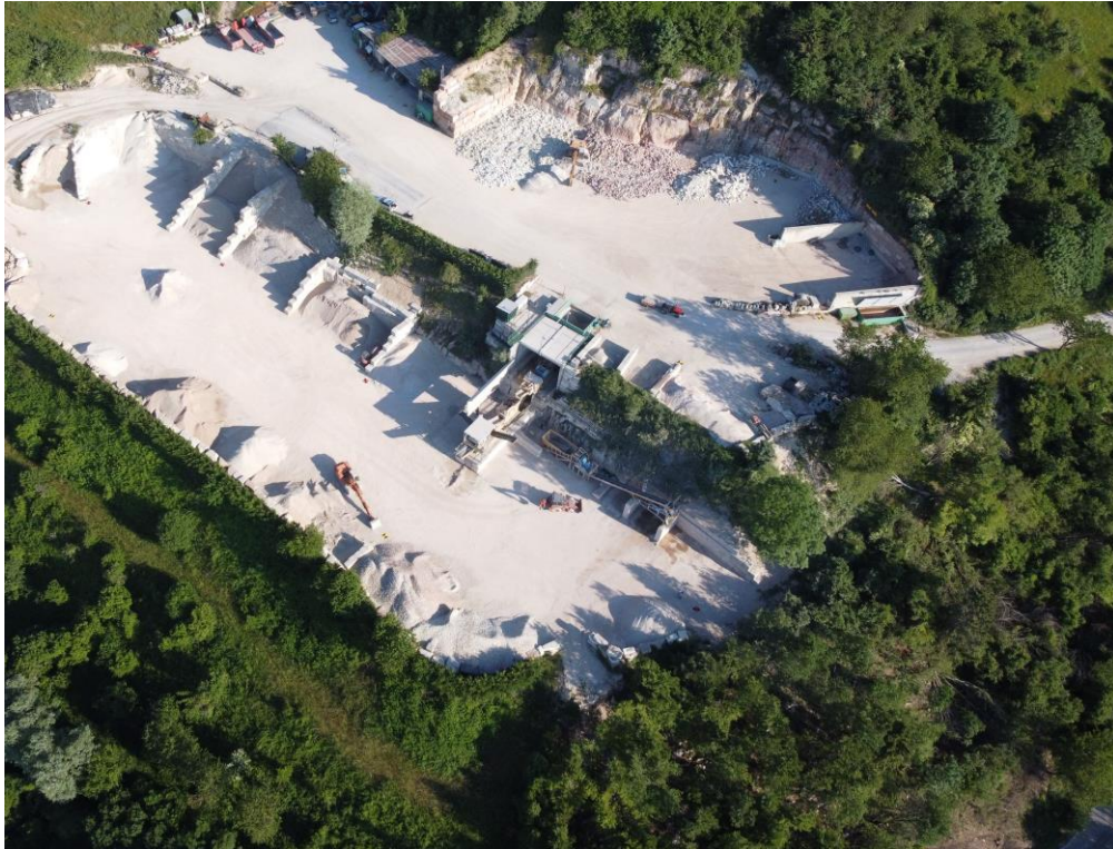
Foto n. 3 – Impianto esistente con area oggetto dell'ampliamento ripresa da sud/est
