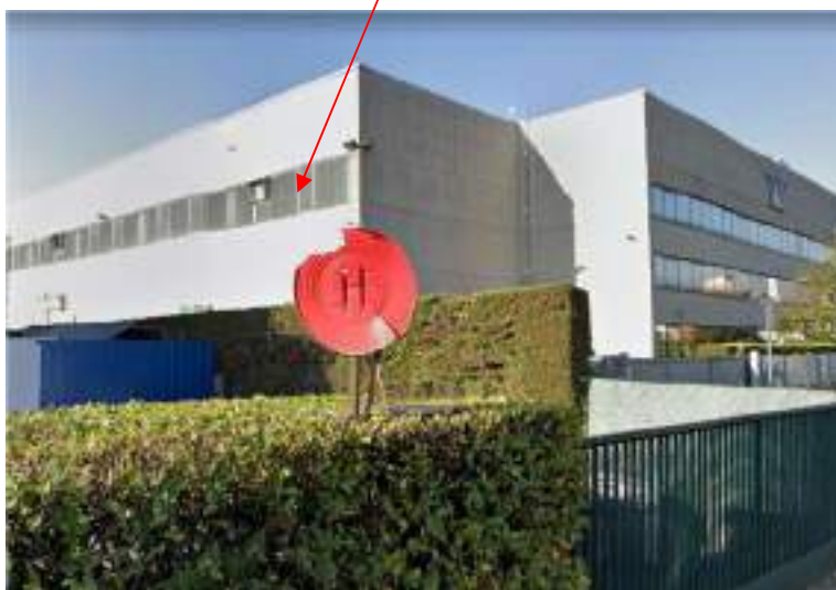
Finestrature lato sud
