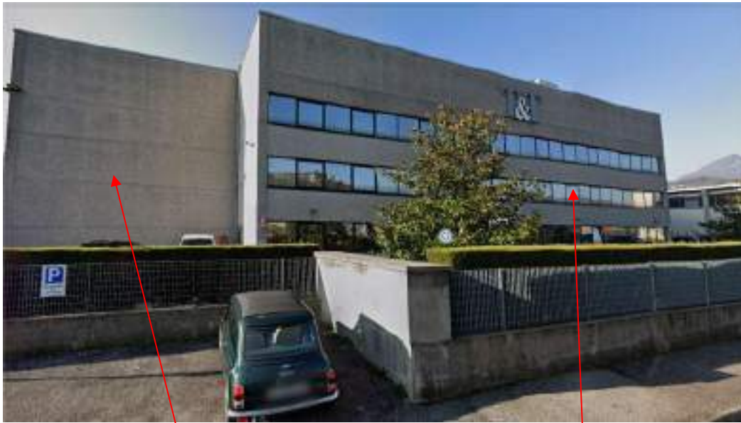
Pareti locali produttivi
