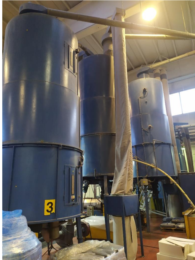
Figura 7. Silos di stoccaggio
