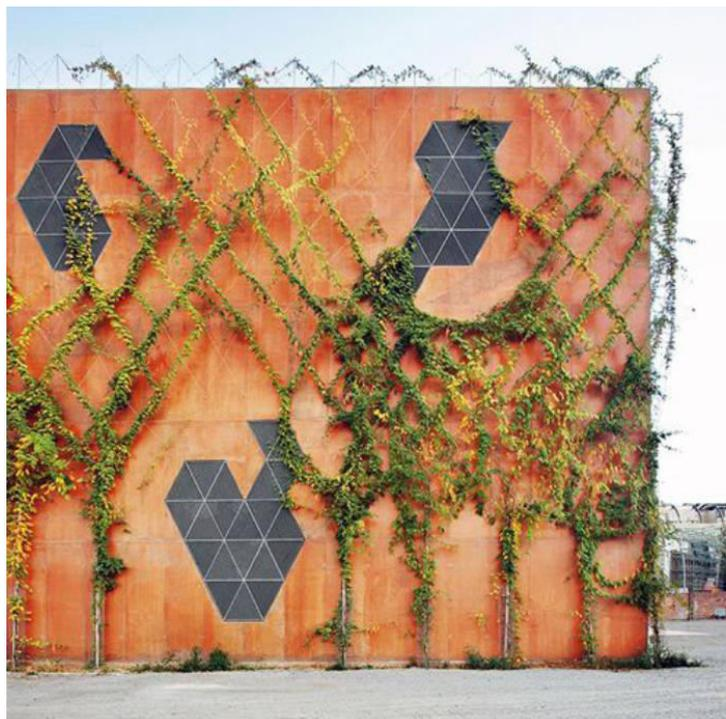
*Edificio della sottostazione elettrica di Barcellona, con l'applicazione del sistema a cavi tesi in acciaio.*
