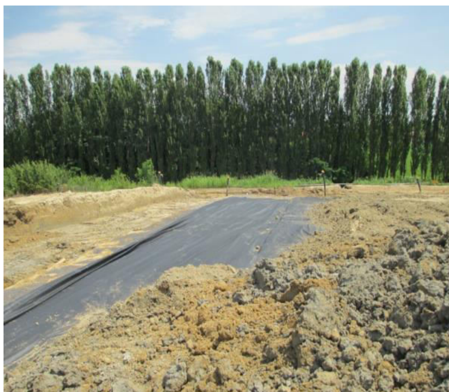
Lotto di copertura sede del campo prova
