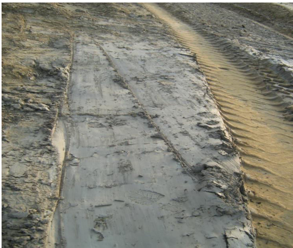
Terreno dopo la compattazione
