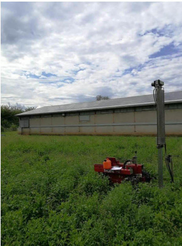
Foto 3: Esecuzione della prova penetrometrica n°3
