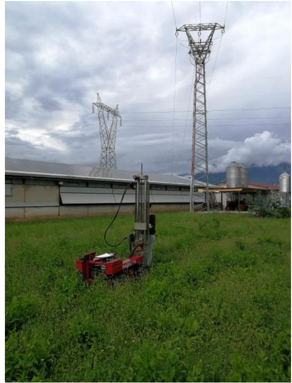
Foto 2: Esecuzione della prova penetrometrica n°2
