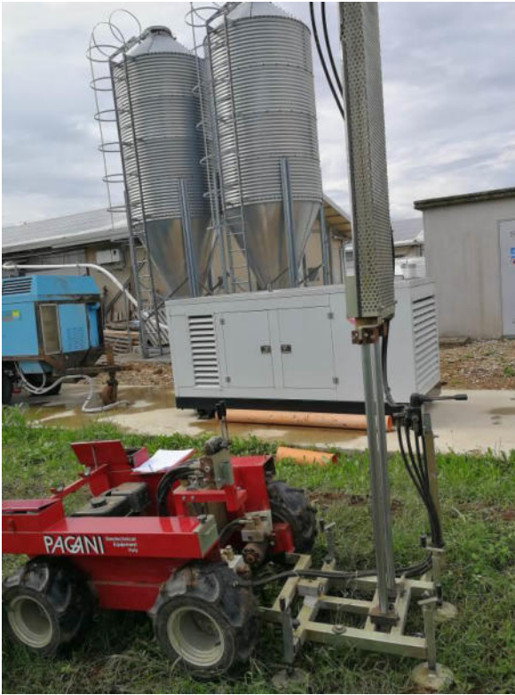
Foto 1: Esecuzione della prova penetrometrica n°1
