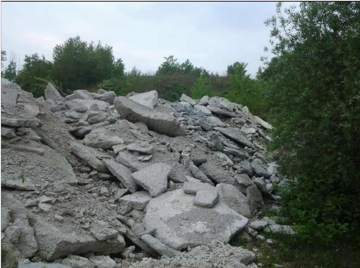
L'adeguamento volumetrico porterà ad una granulometria massima di 100 mm, compatibile con classificazione EoW e sarà eseguito in campagna mobile dalla ditta Mastrotto S.r.l., che opera con autorizzazione N° 107/2016 del 19/05/2016 (rilasciata dalla Provincia di Vicenza), in scadenza il 09/06/2021.
