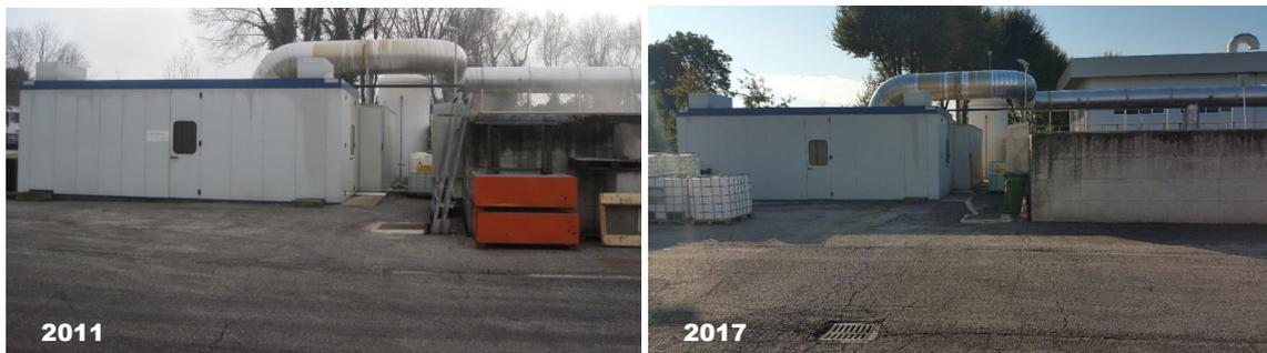
Figura 4-5-4: Sistema di trattamento arie mediante scrubber e biofiltro.
