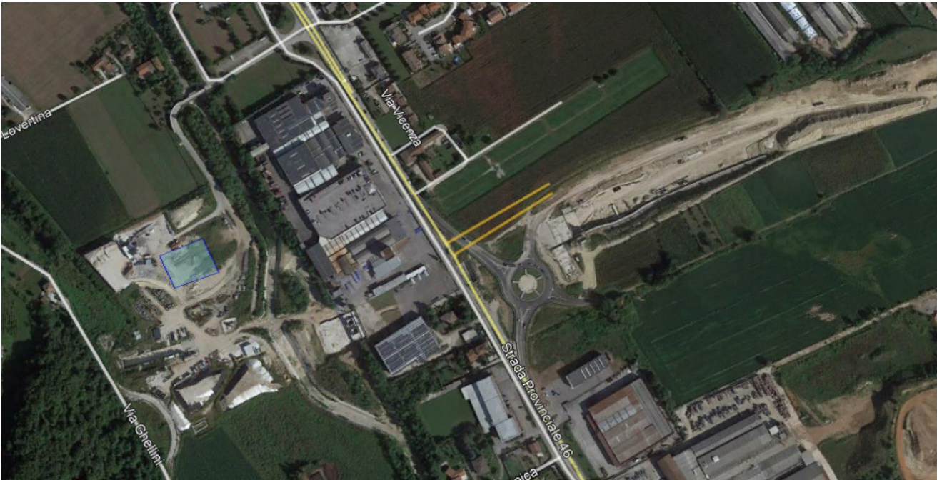
Figura 2: Localizzazione area campagna recupero rifiuti in comune di Malo (in azzurro l'area d'intervento)
