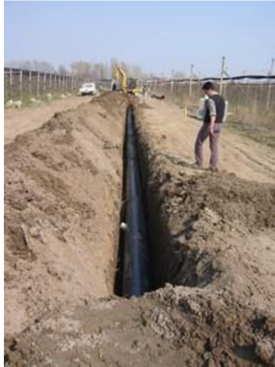
Foto 1: scavo per posa tubazione (foto di archivio)
