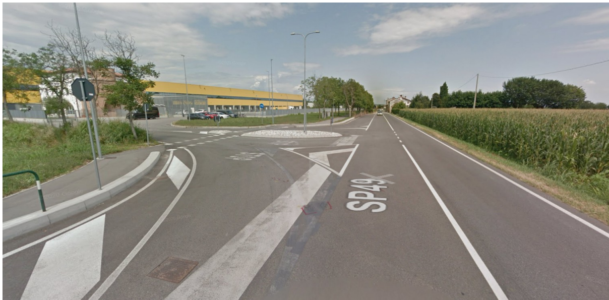
FIGURA 6. INNESTO DELLA STRADA PRIVATA CON LA SP49.
