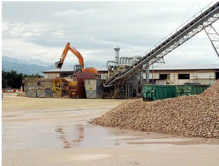
Impianto di frantumazione e soffiatore
