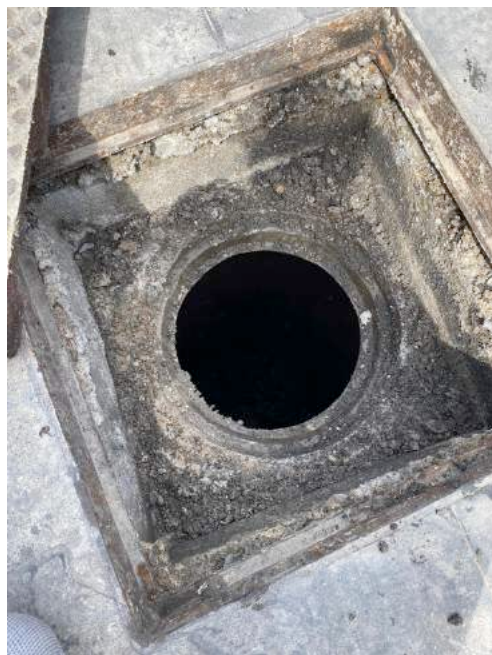
Riprese fotografiche del pozzo disperdente delle acque meteoriche dei pluviali del capannone esistente.
