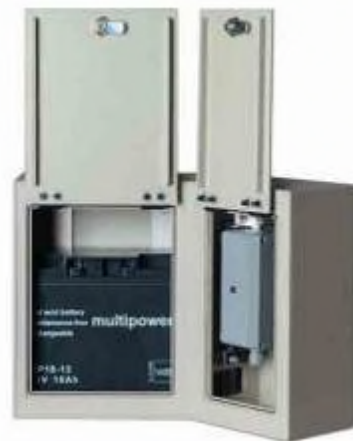
Figura 2.2 – Strumentazione radar ViaTraffic
