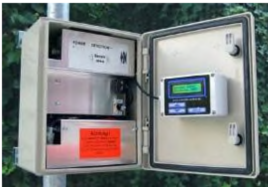
Figura 2.1 – Strumentazione radar Wavetech
