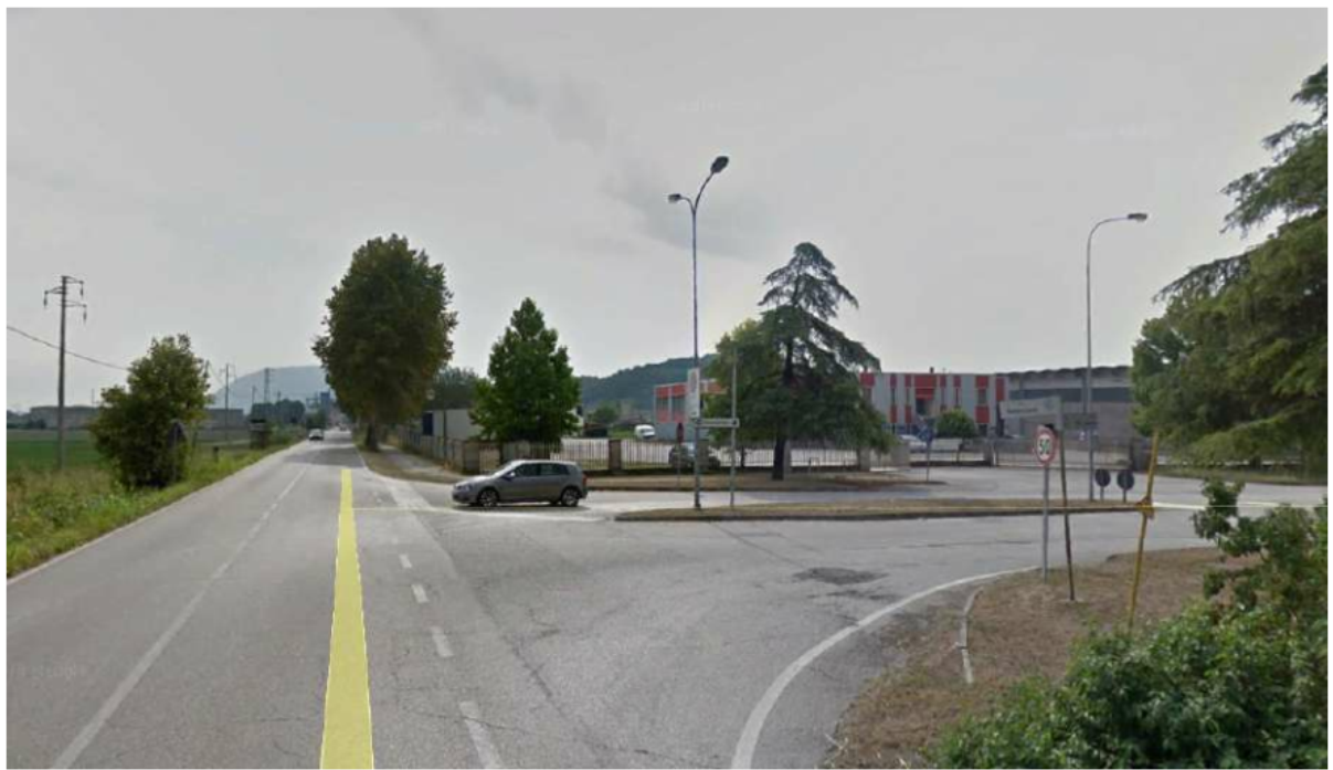
Figura 2: Inquadramento viabilistico dell'impianto di A.F. Bioenergie e foto (da ovest) dell'accesso da Via Rampezzana alla Z.A.I. di Ponte di Barbarano.
