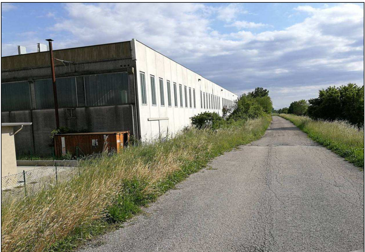
Foto n. 2: l'immagine rappresenta la vista percepibile lungo via Fornasette in direzione Sud (verso l'area di intervento), la strada scorre sulla sommità arginale del canale Bisatto sulla destra nella foto.
