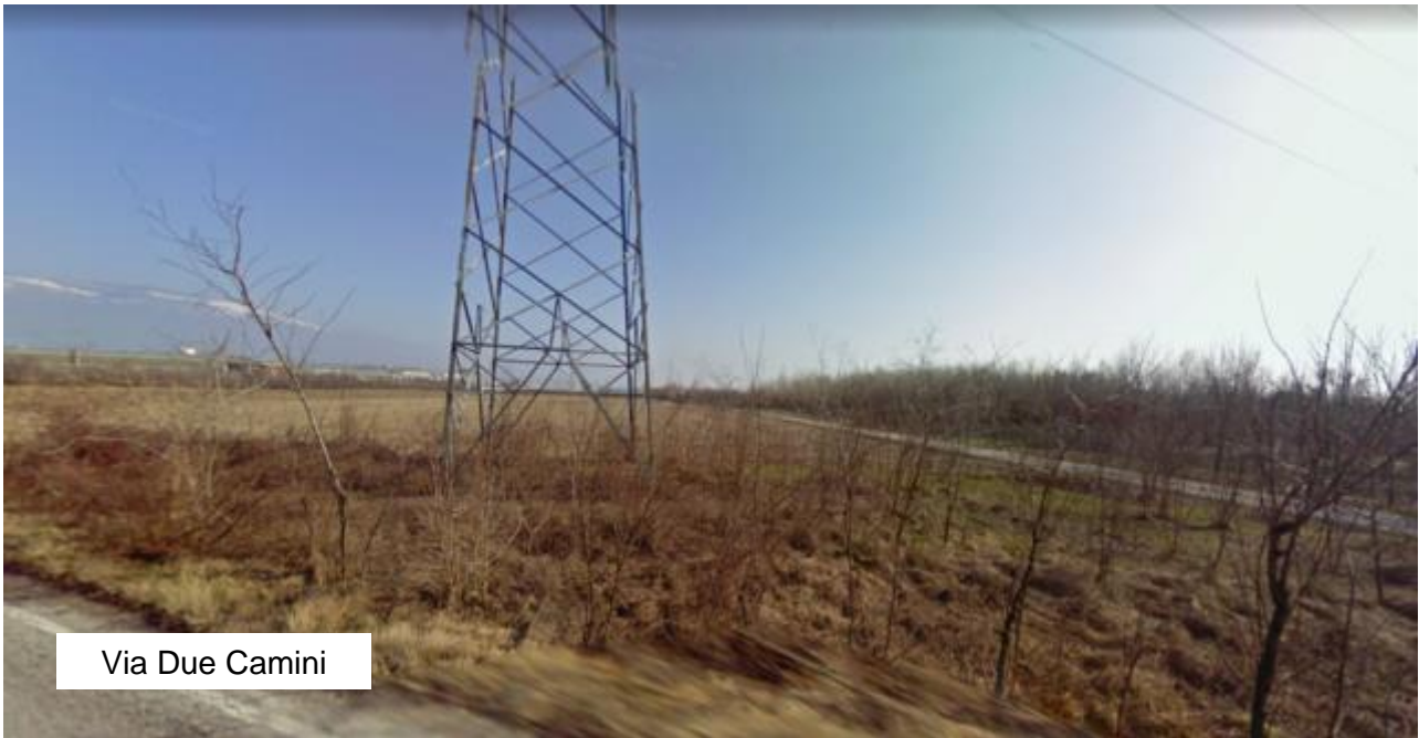
Figura 6: Foto della zona di progetto da via Due Camini, alla base del traliccio dell'elettrodotto ad alta tensione.
