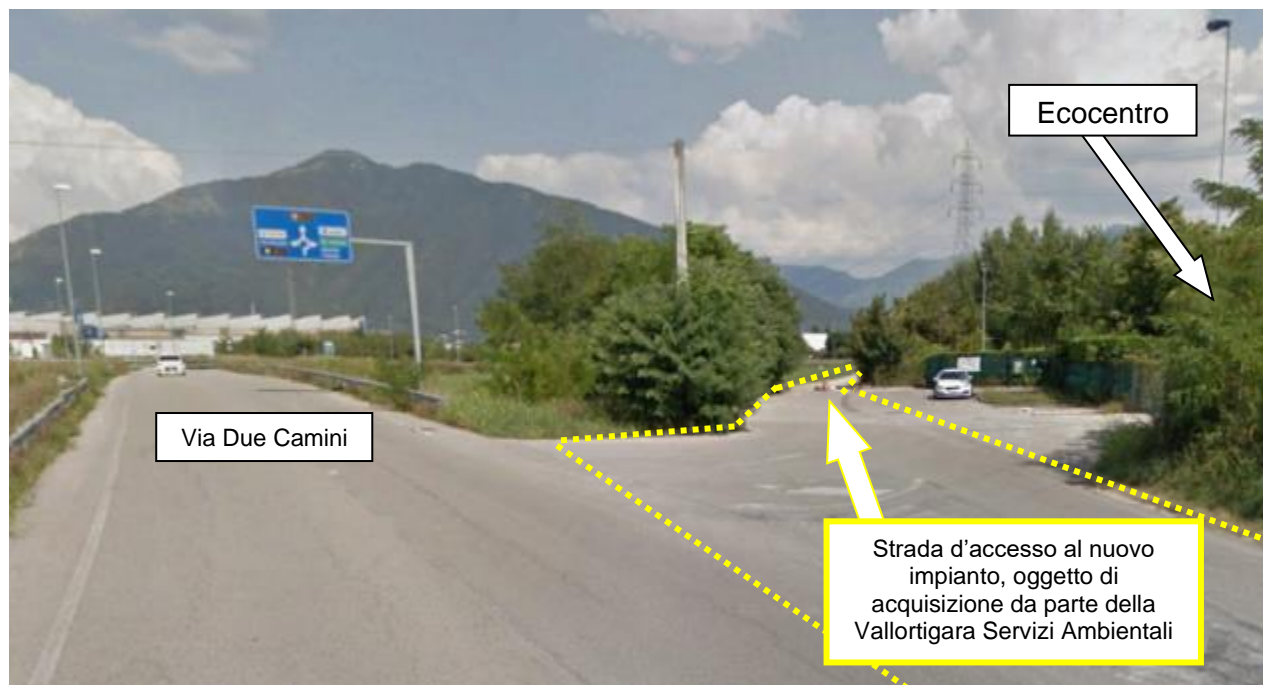
Figura 16: Bivio fra il recente tratto di via Due Camini di collegamento a via Maestri del Lavoro e il pregresso tratto di via Due Camini che costituirà l'ingresso al nuovo impianto.
