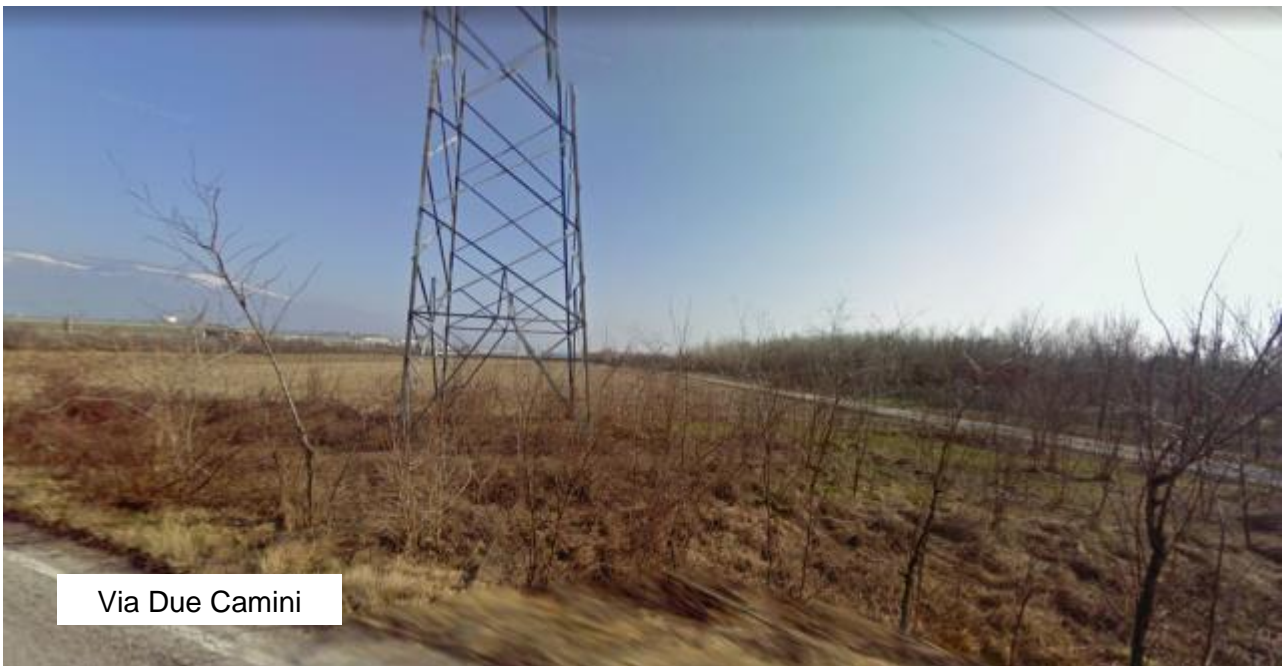
Figura 6: Foto della zona di progetto da via Due Camini, alla base del traliccio dell'elettrodotto ad alta tensione.
