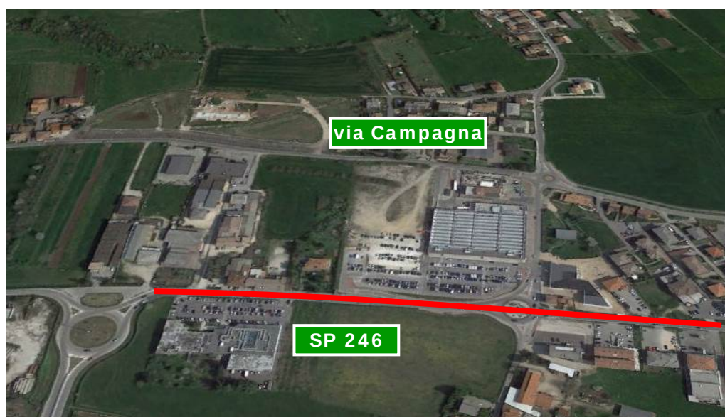
Figura 6 – Foto aerea SP 246 in corrispondenza della GSV
