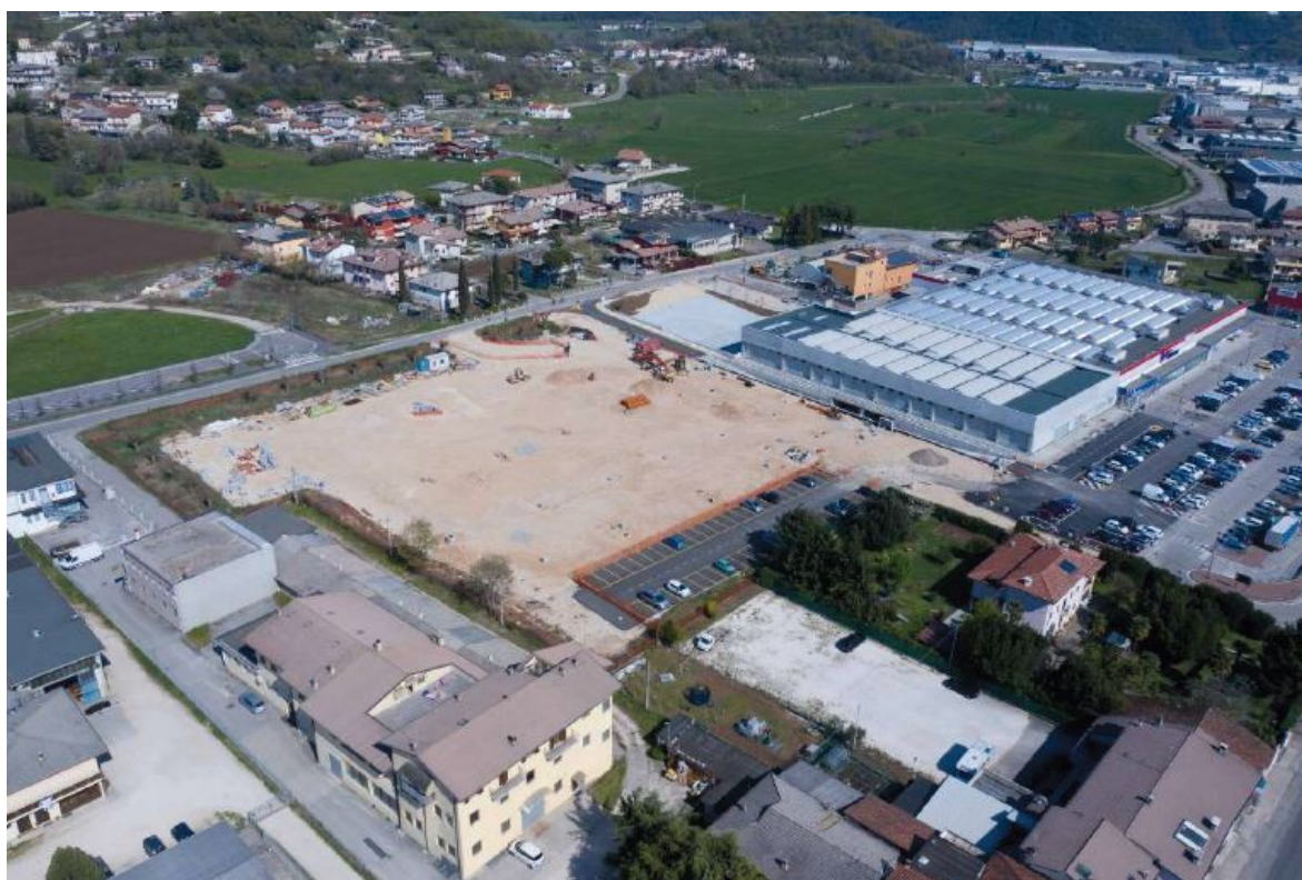
Figura 19 – Stato di fatto
