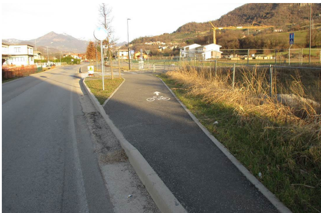
Figura 39 – Punto di innesto nuova pista ciclopedonale
