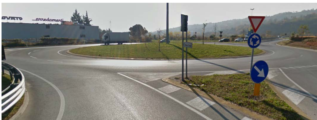
Figura 12 – Intersezione lungo la SP 246 con la SR 246
