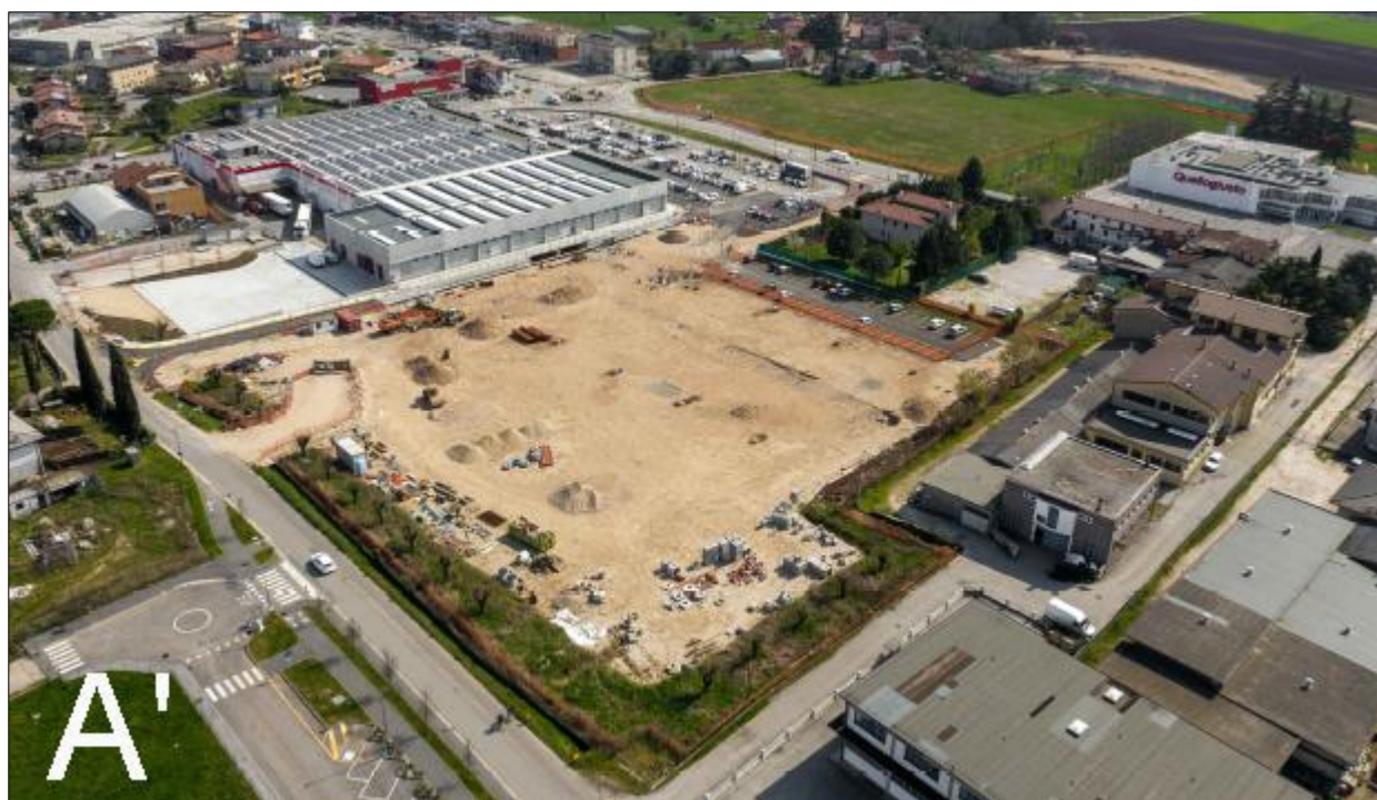
Figura 4-35. Stato attuale dell'ambito di intervento visto da nord-ovest (sorvolo del 06/04/2020)
