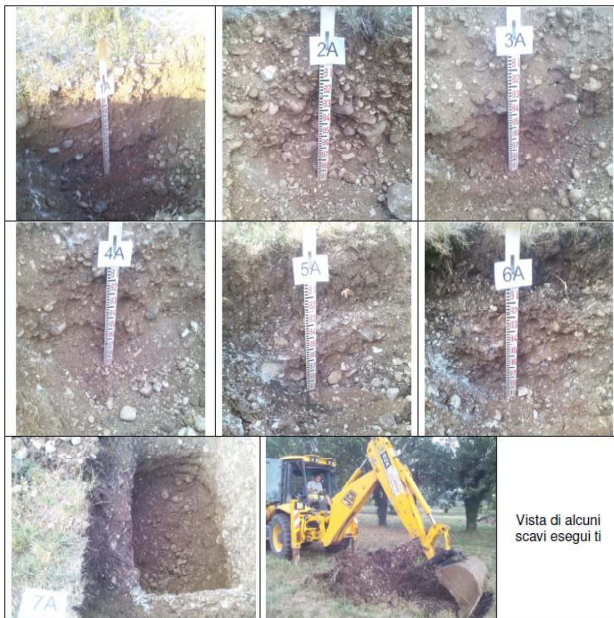
Figura 4-27. Vista di alcuni scavi eseguiti (fonte: Relazione ambientale per la gestione di terre da scavo derivanti dall'ampliamento del punto vendita Supermercati Tosano in Località Melonara a Cornedo Vicentino)
