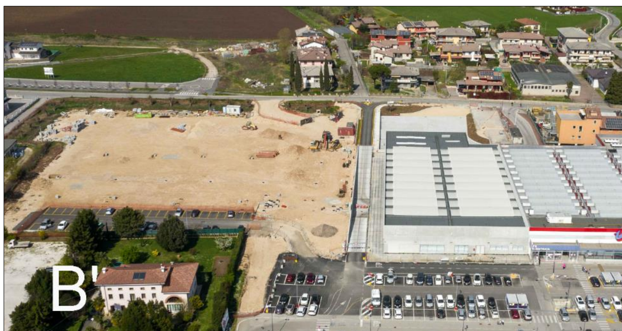
Figura 4-36. Stato attuale dell'ambito di intervento visto da sud (sorvolo del 06/04/2020)
