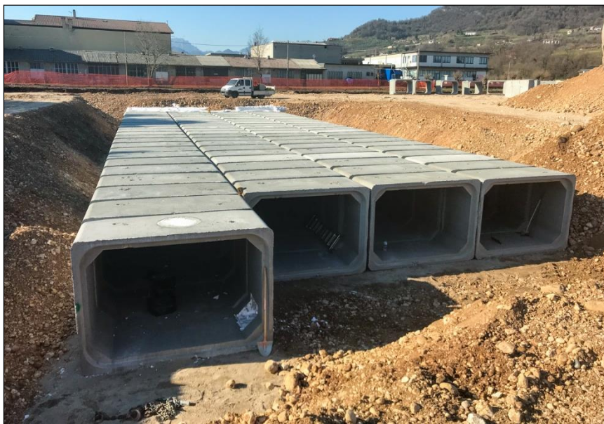
Figura 2-32. Particolare degli scatolari installati (a sinistra) e della pompa di rilancio installati (a destra)
